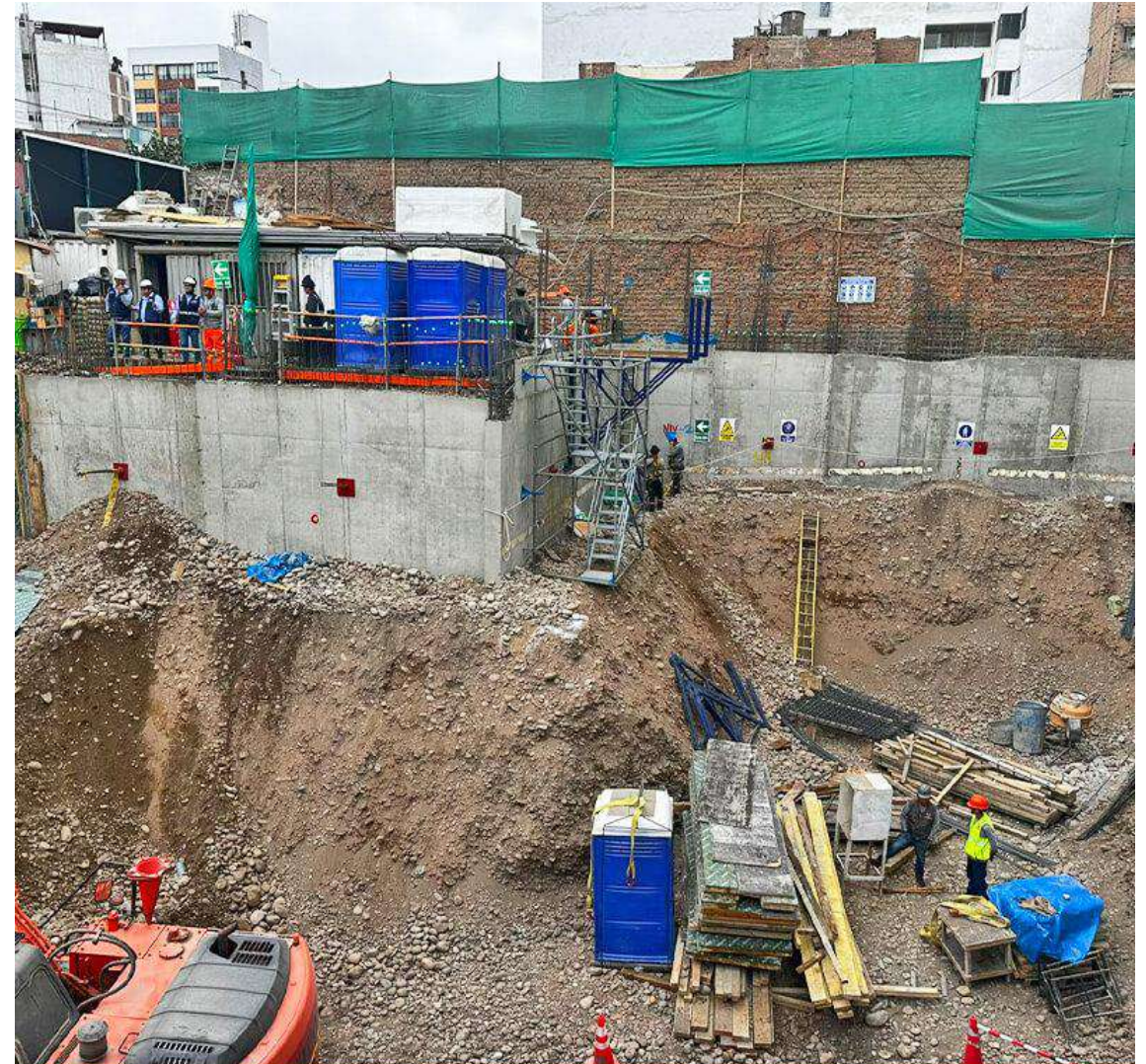
AVANCE DE OBRA - DICIEMBRE 2025
