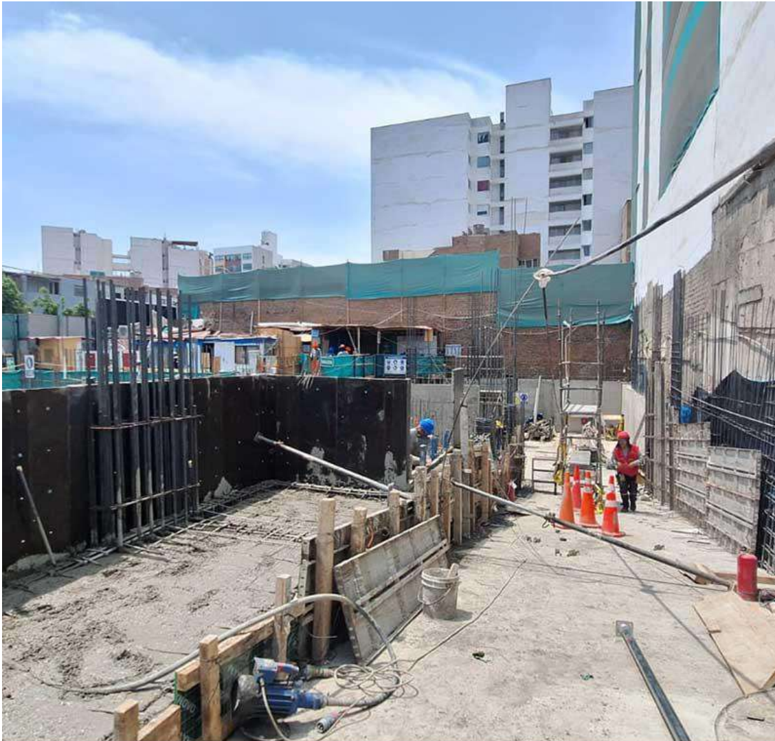
AVANCE DE OBRA - MARZO 2026
