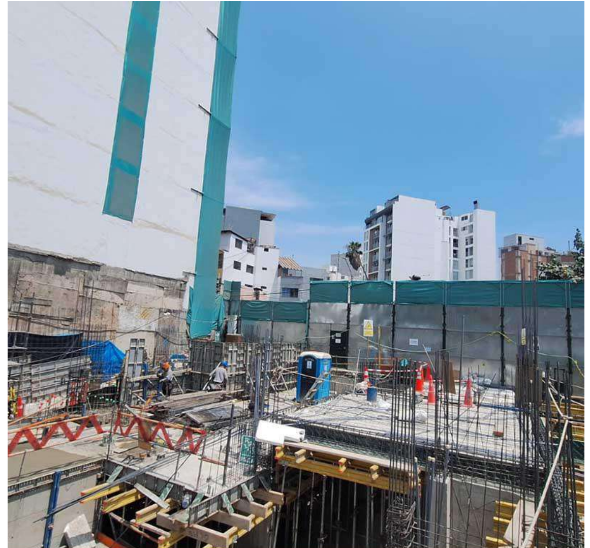
AVANCE DE OBRA - MARZO 2026
