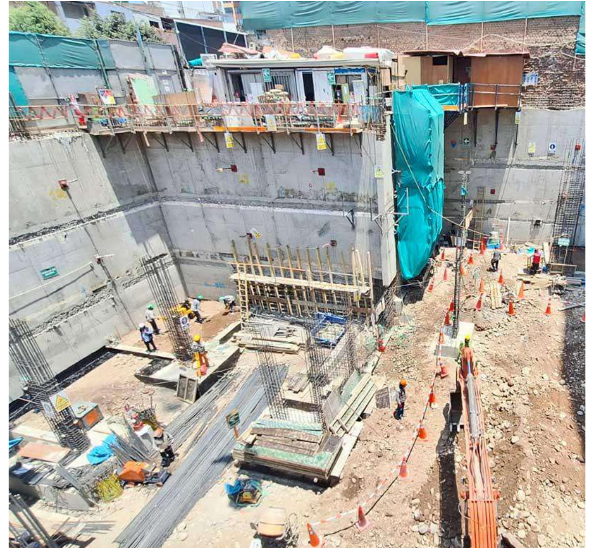
AVANCE DE OBRA - ENERO 2026
