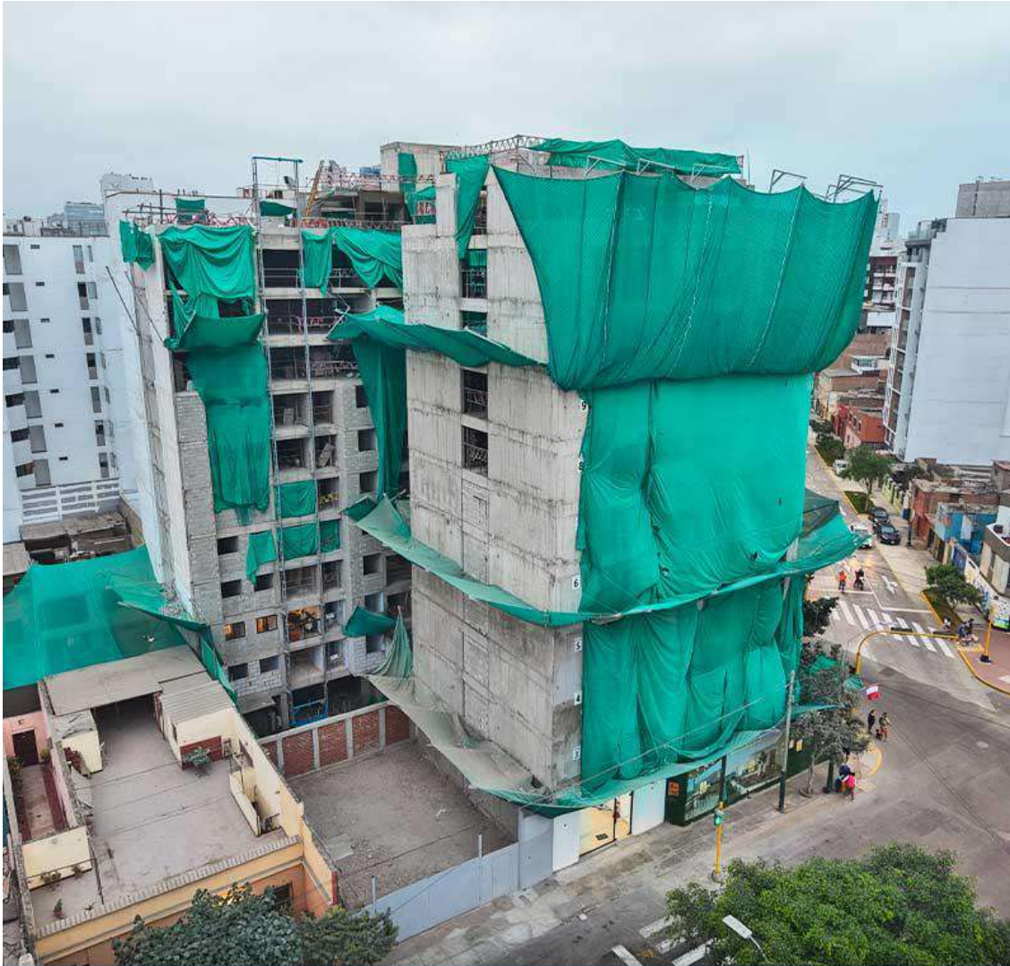
AVANCE DE OBRA - JULIO 2026
