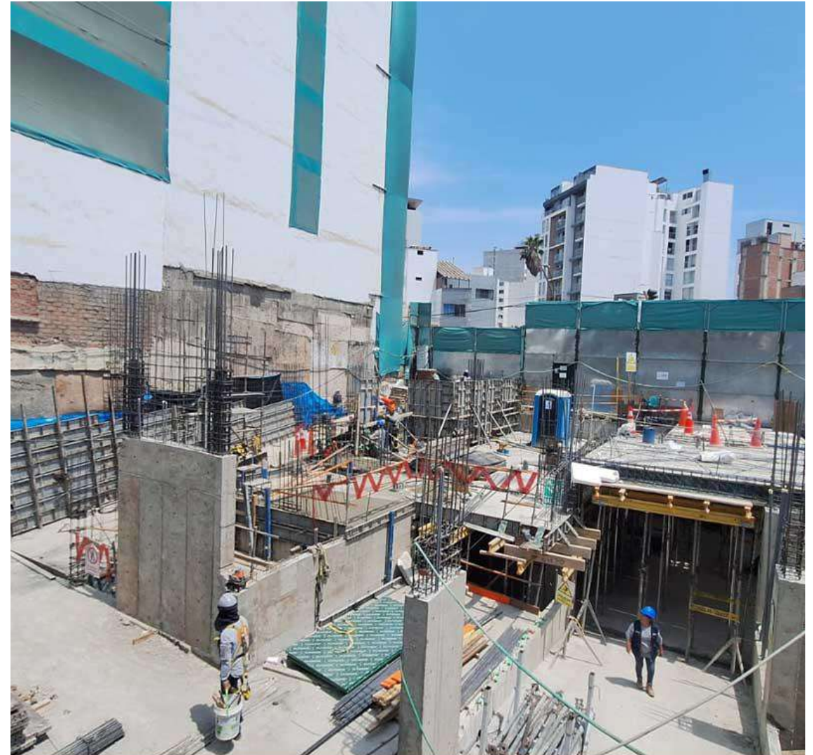
AVANCE DE OBRA - MARZO 2026
