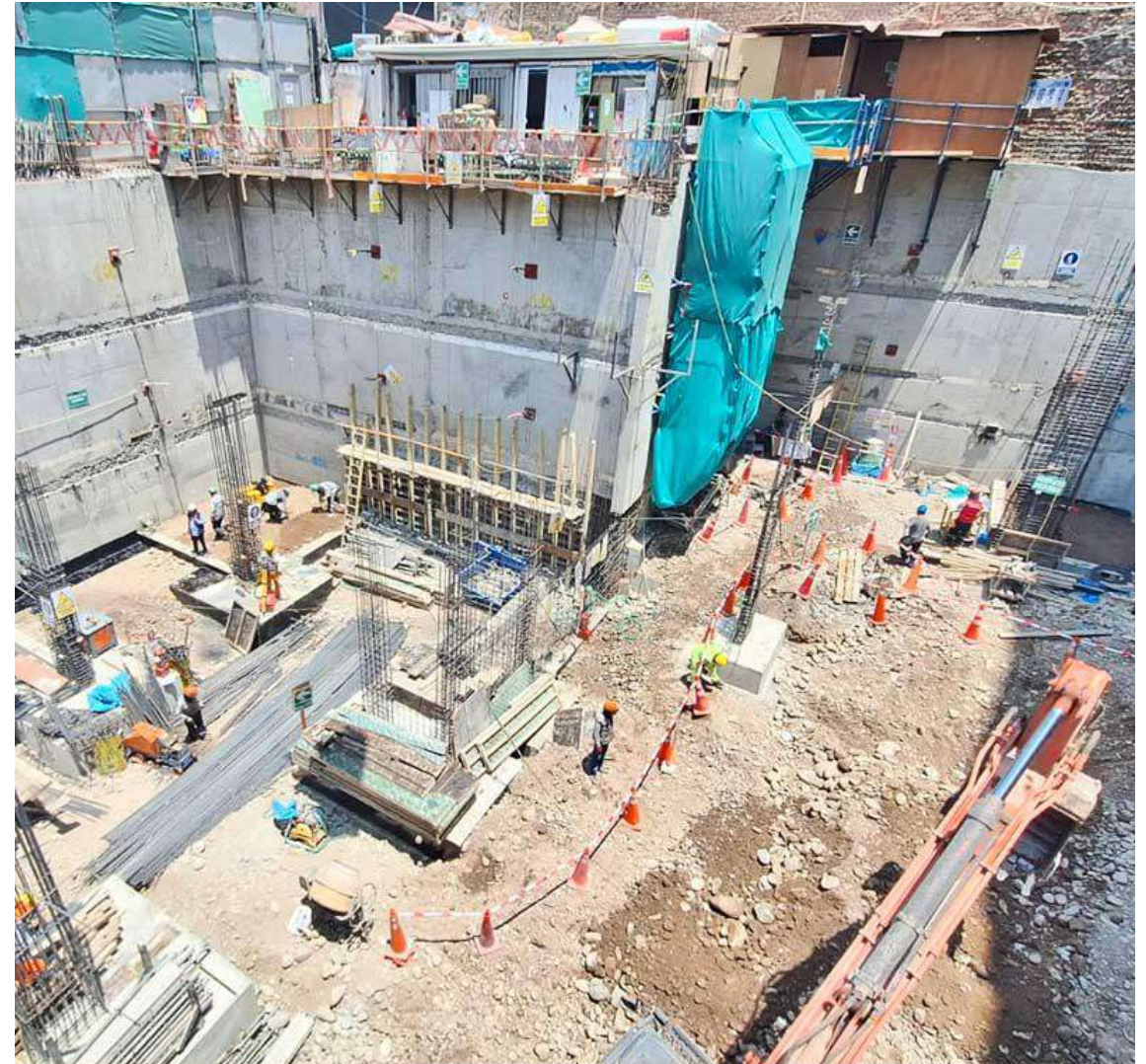
AVANCE DE OBRA - ENERO 2026
