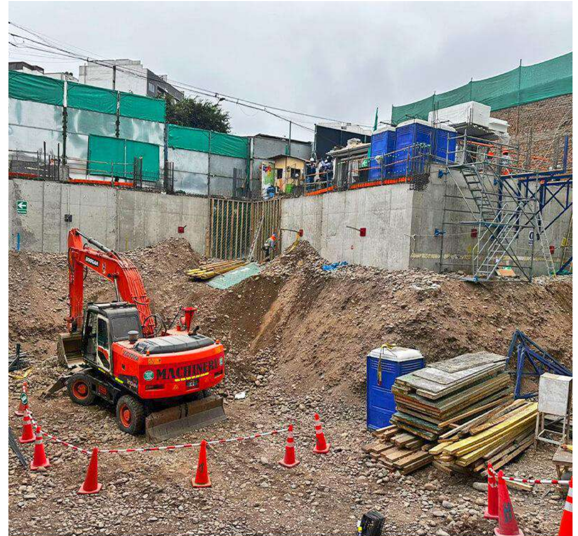
AVANCE DE OBRA - DICIEMBRE 2025
