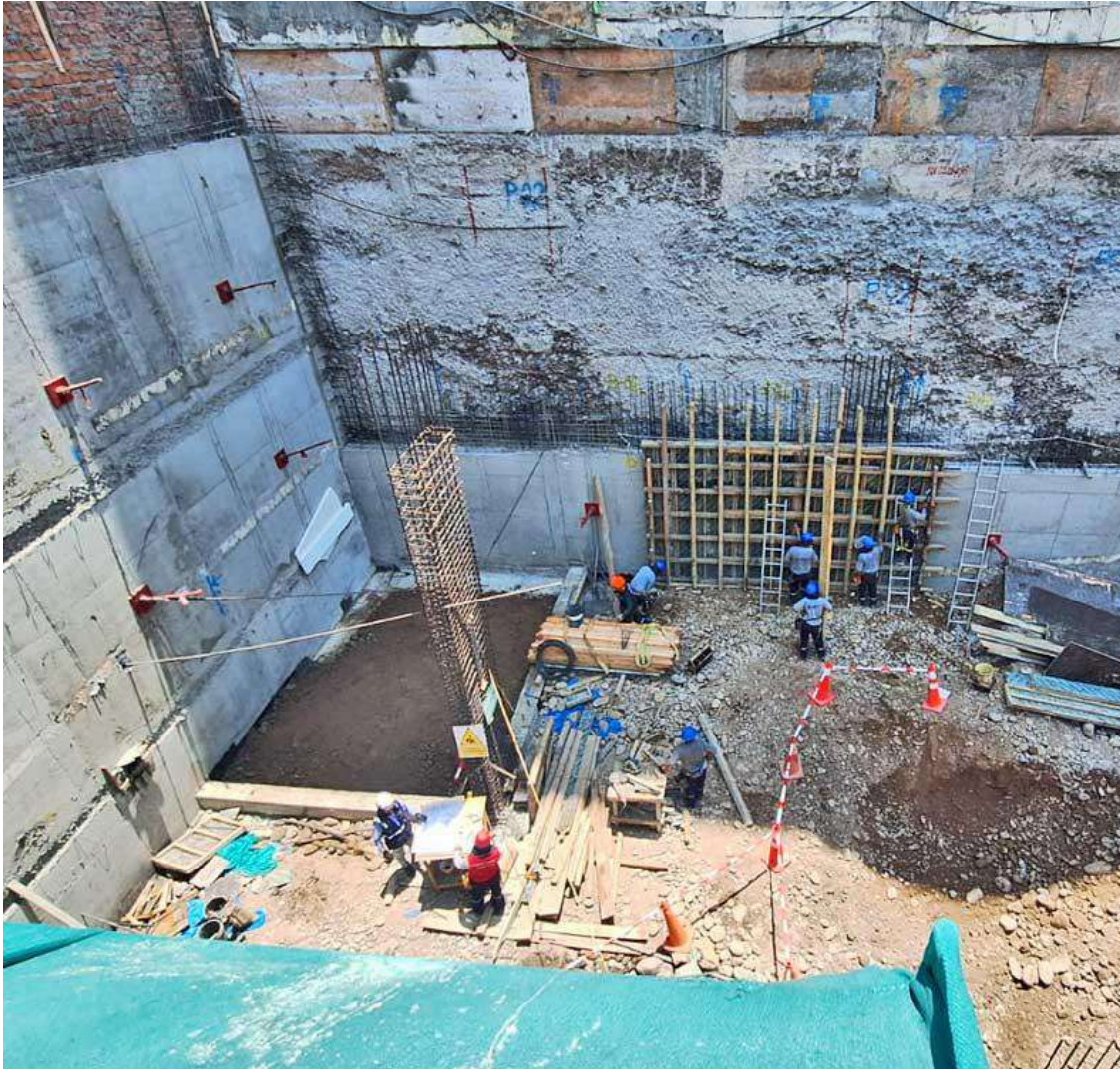
AVANCE DE OBRA - ENERO 2026
