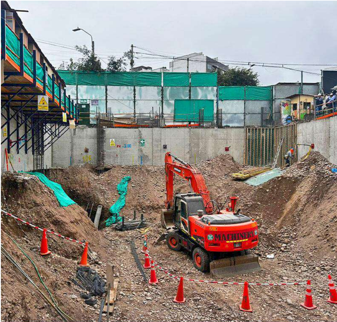
AVANCE DE OBRA - DICIEMBRE 2025
