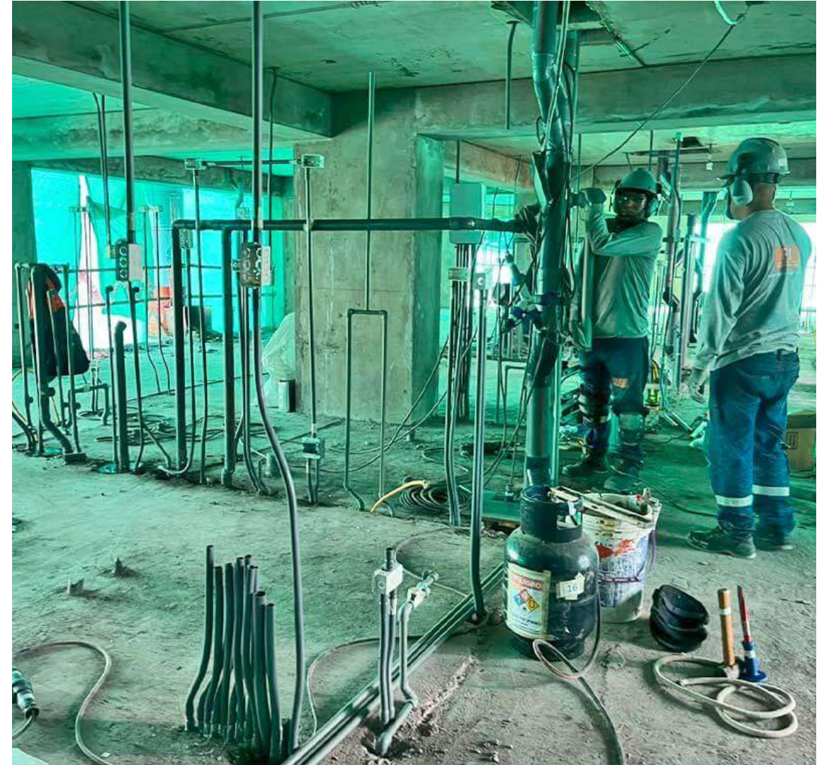
AVANCE DE OBRA - MAYO 2026
