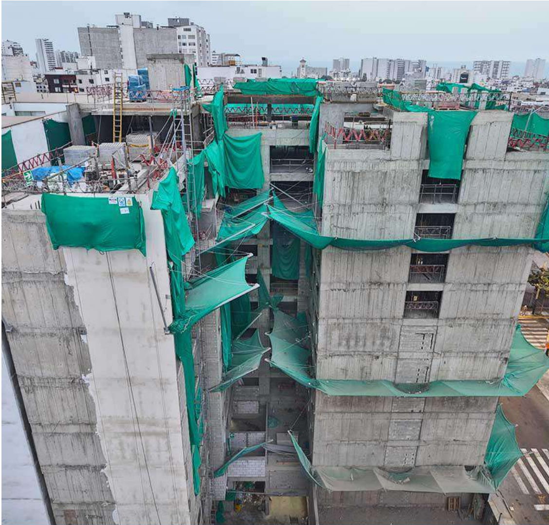
AVANCE DE OBRA - JULIO 2026
