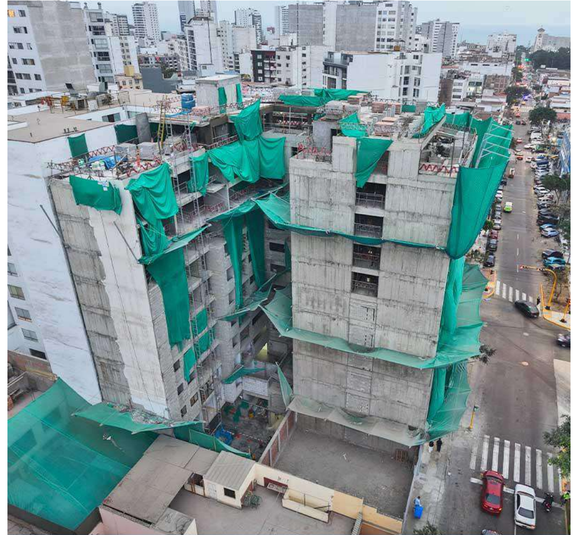
AVANCE DE OBRA - JULIO 2026
