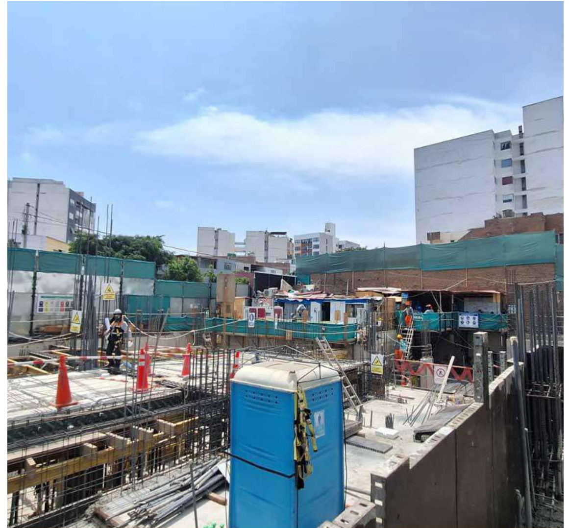
AVANCE DE OBRA - MARZO 2026
