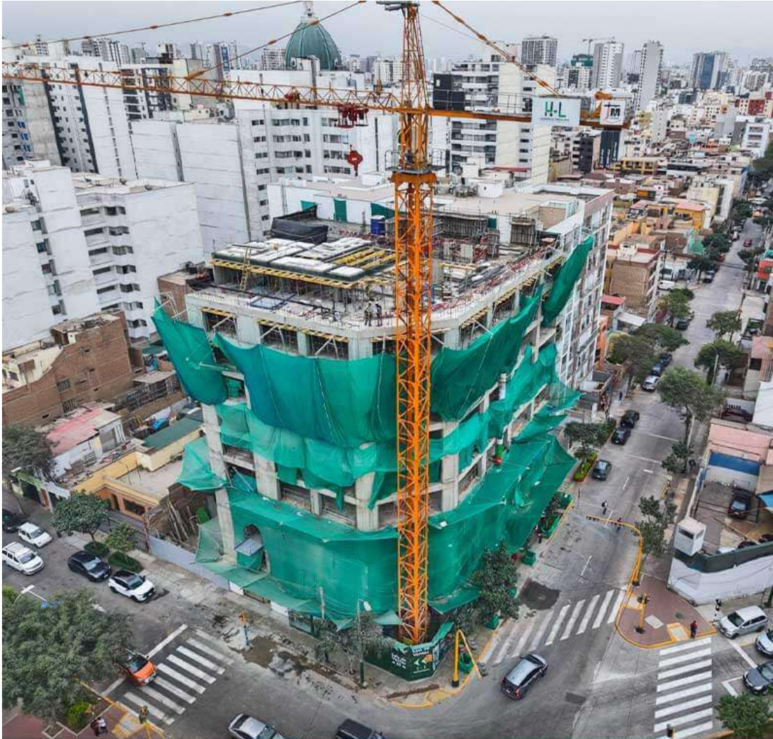
AVANCE DE OBRA - MAYO 2026
