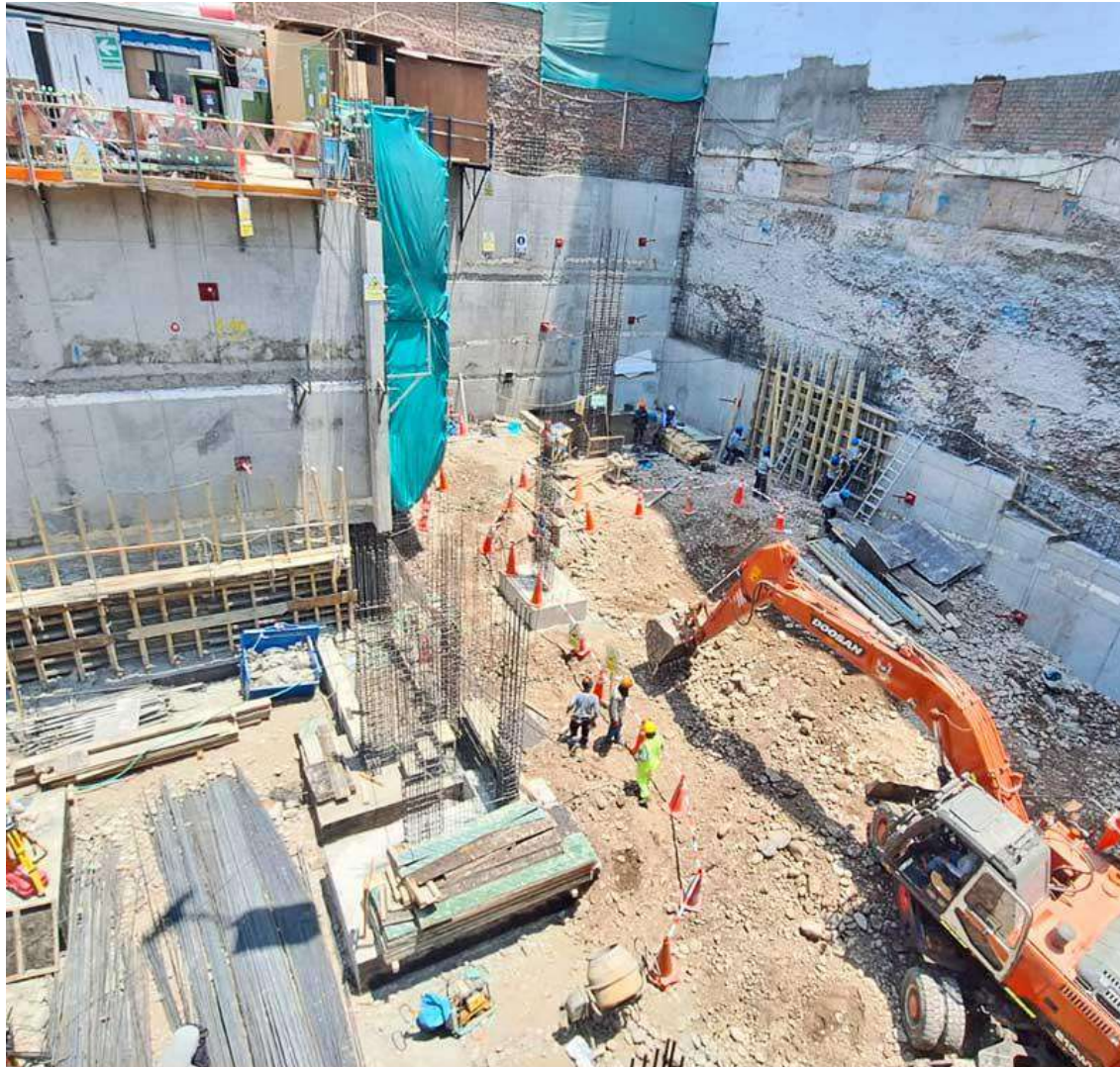
AVANCE DE OBRA - ENERO 2026
