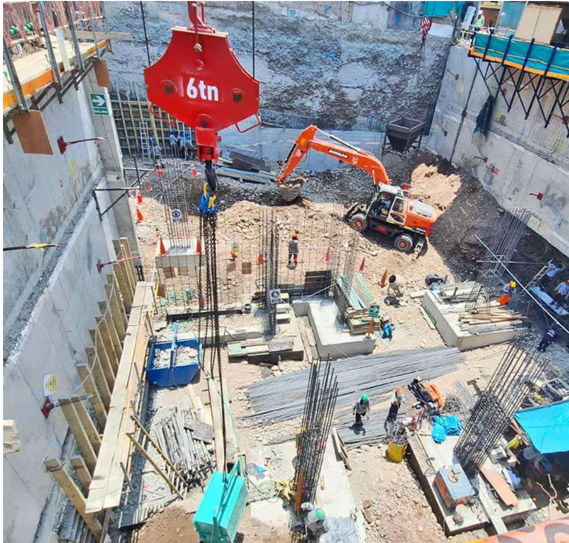
AVANCE DE OBRA - ENERO 2026
