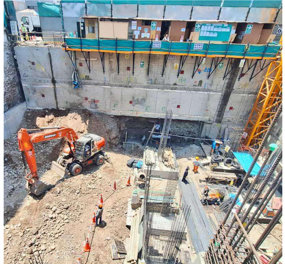
AVANCE DE OBRA - ENERO 2026
