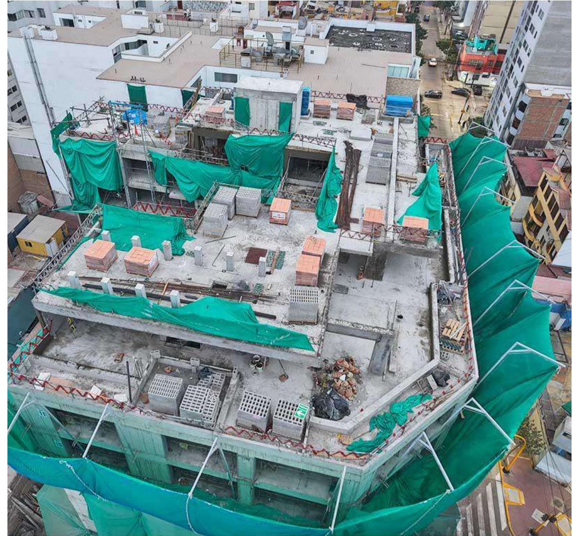
AVANCE DE OBRA - JULIO 2026
