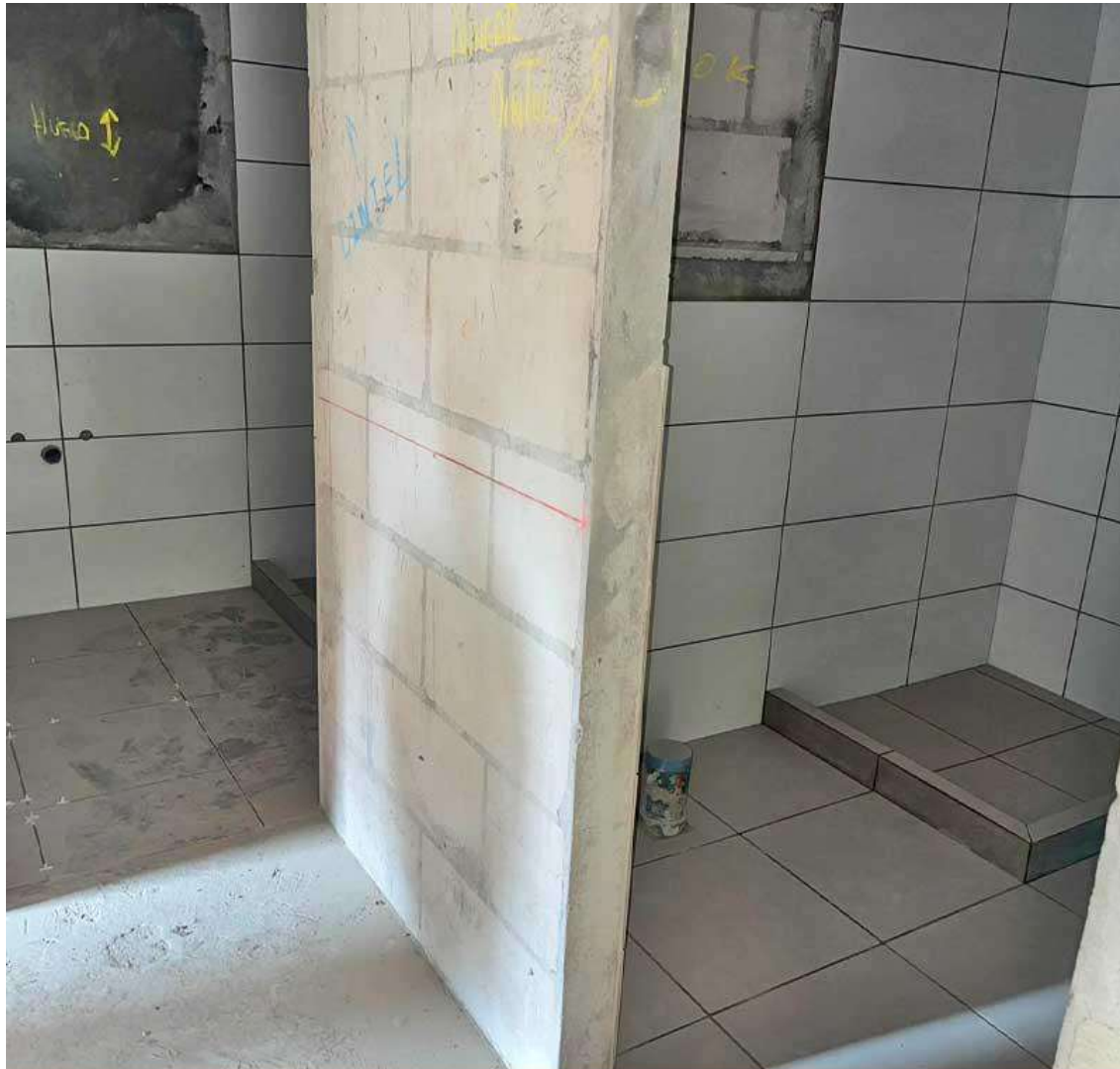
AVANCE DE OBRA - MAYO 2026
