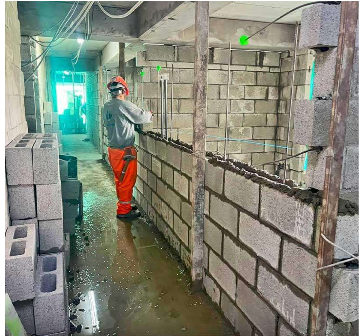
AVANCE DE OBRA - MAYO 2026
