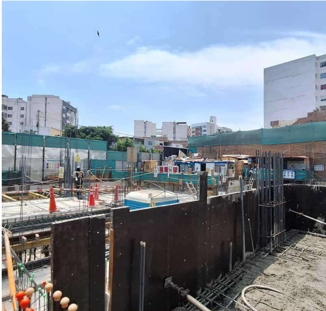
AVANCE DE OBRA - MARZO 2026
