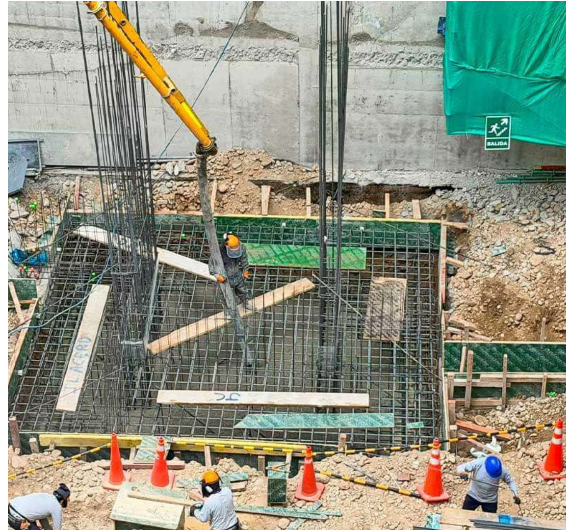
AVANCE DE OBRA - JULIO 2026
