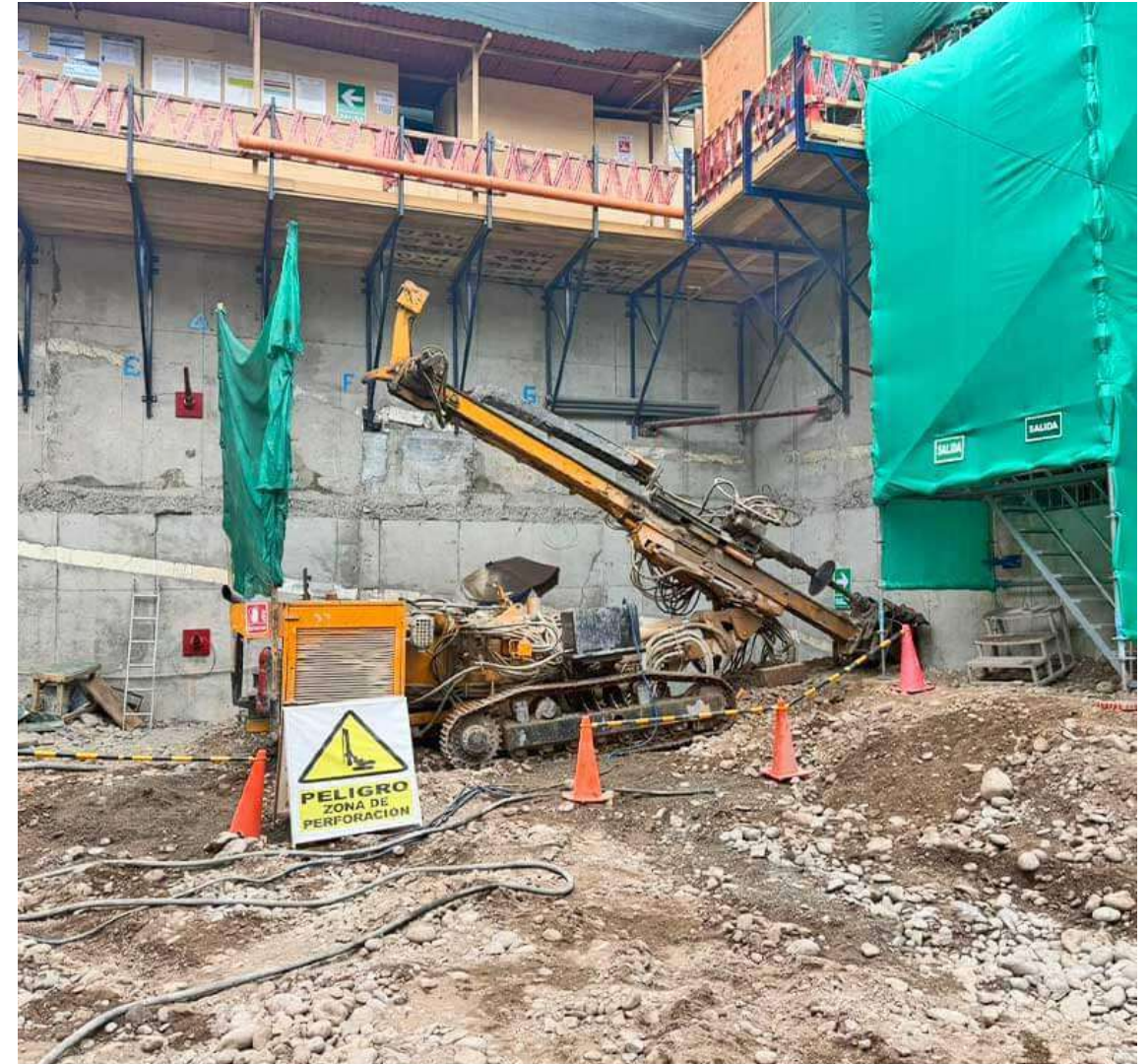
AVANCE DE OBRA - MAYO 2026
