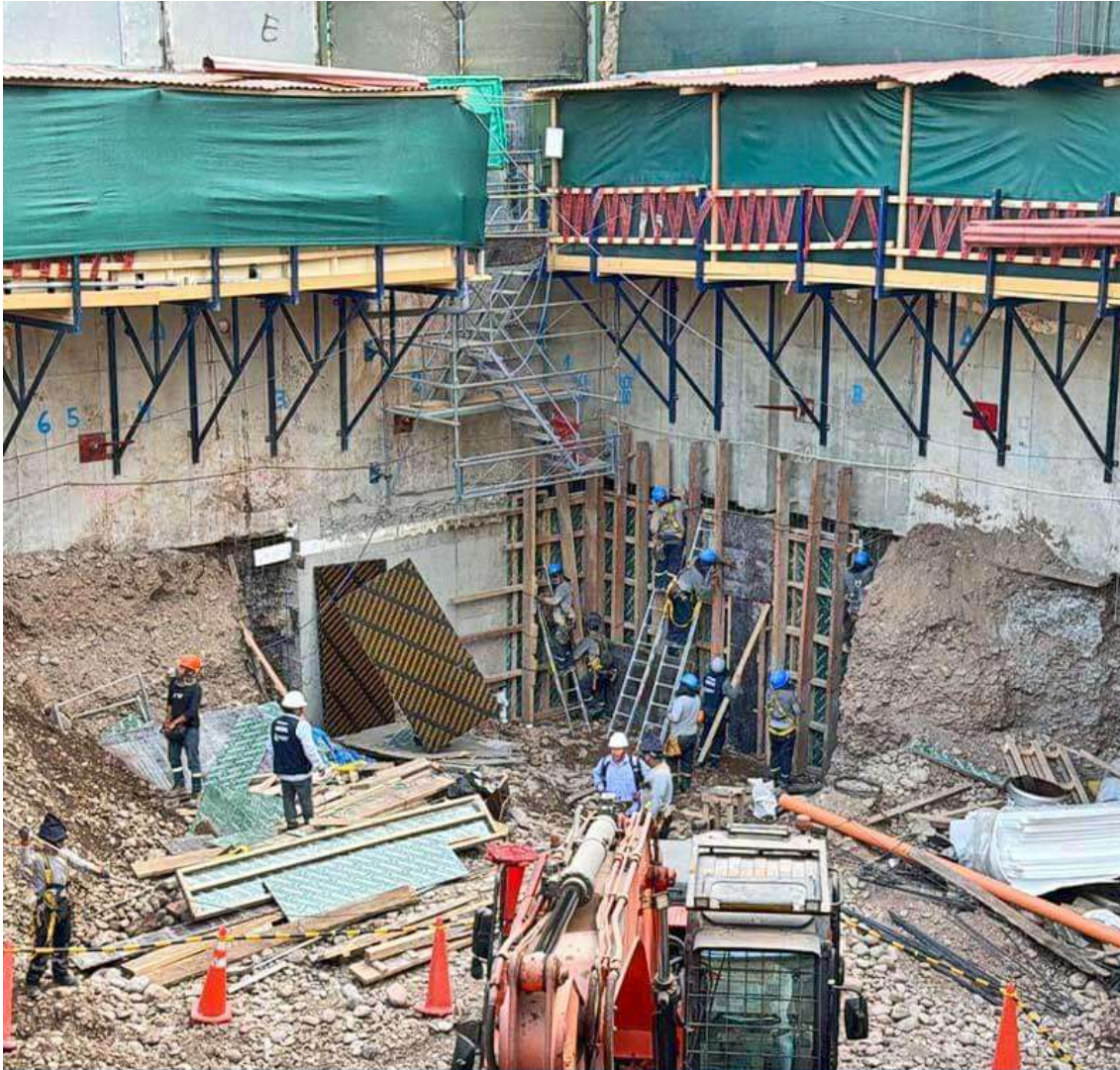
AVANCE DE OBRA - MAYO 2026
