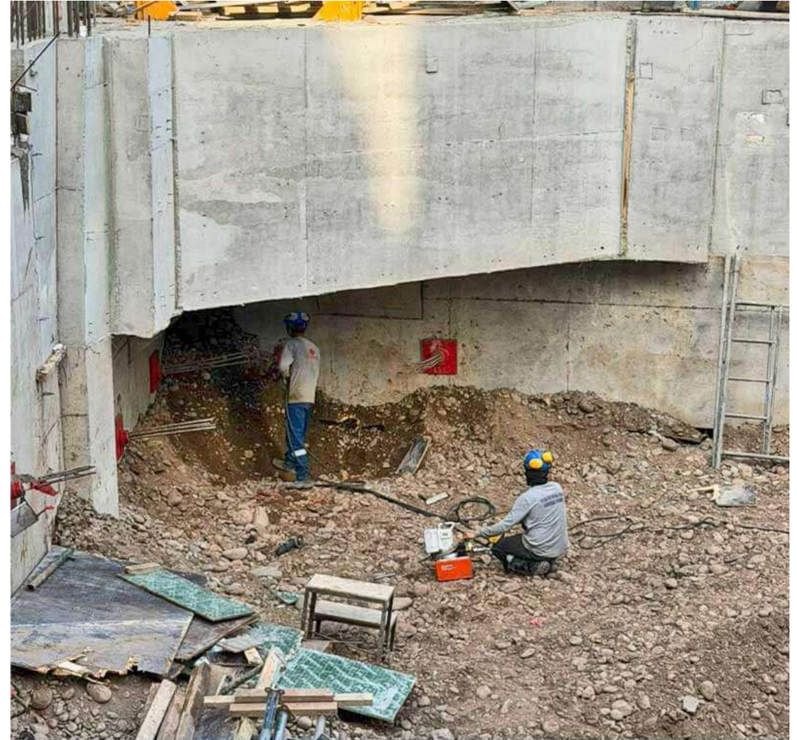
AVANCE DE OBRA - MAYO 2026
