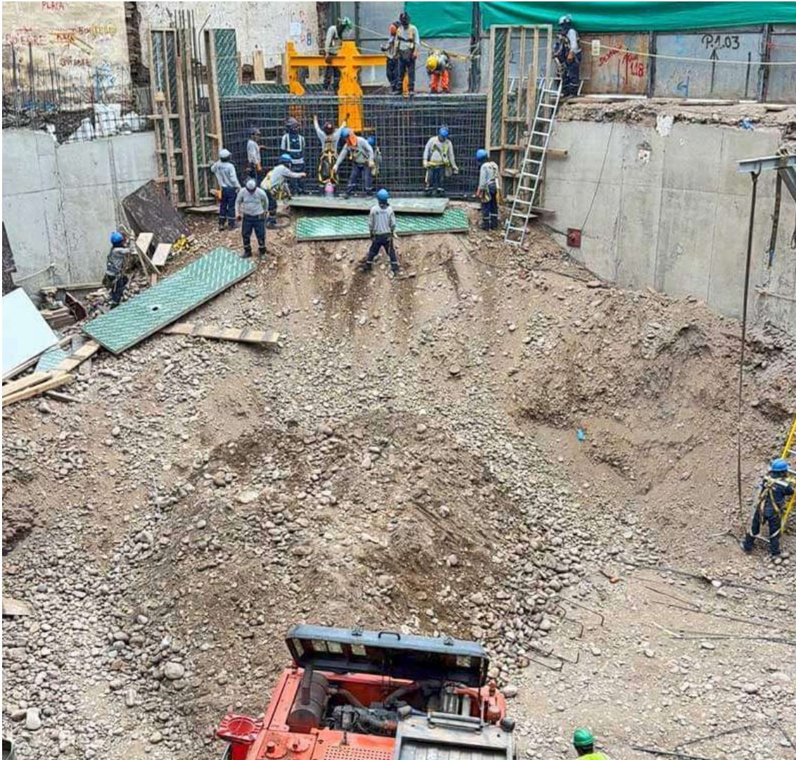
AVANCE DE OBRA - MAYO 2026
