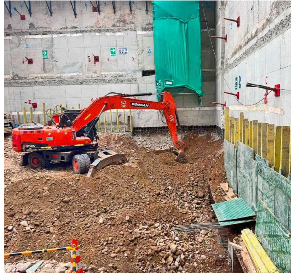
AVANCE DE OBRA - JULIO 2026
