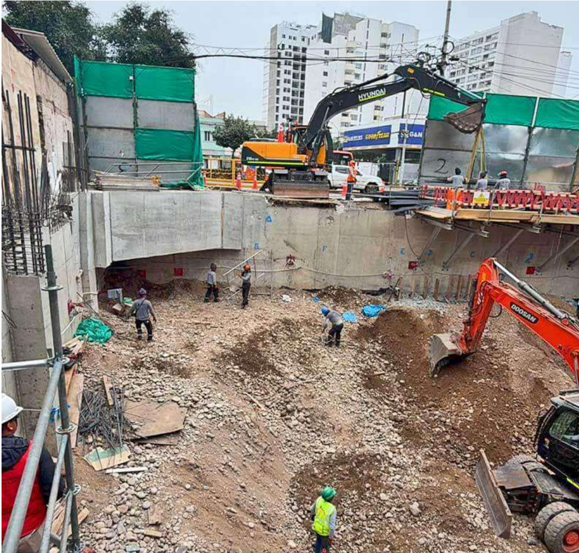
AVANCE DE OBRA - MAYO 2026
