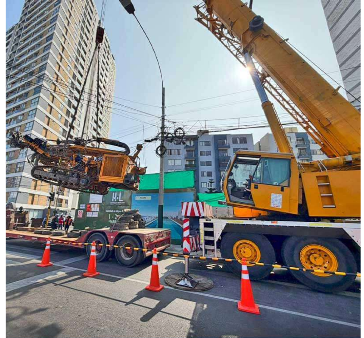
AVANCE DE OBRA - MAYO 2026
