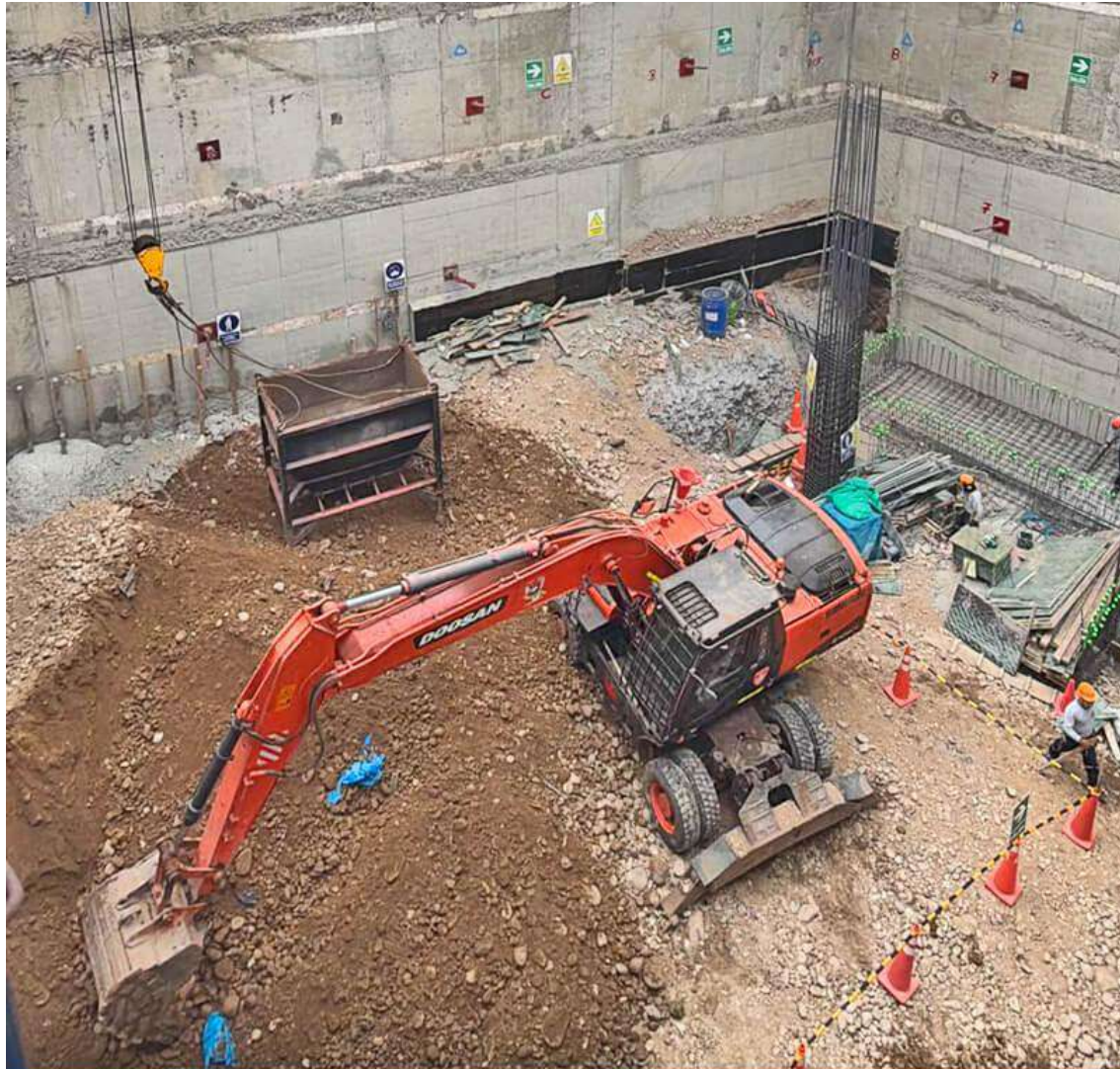
AVANCE DE OBRA - JULIO 2026
