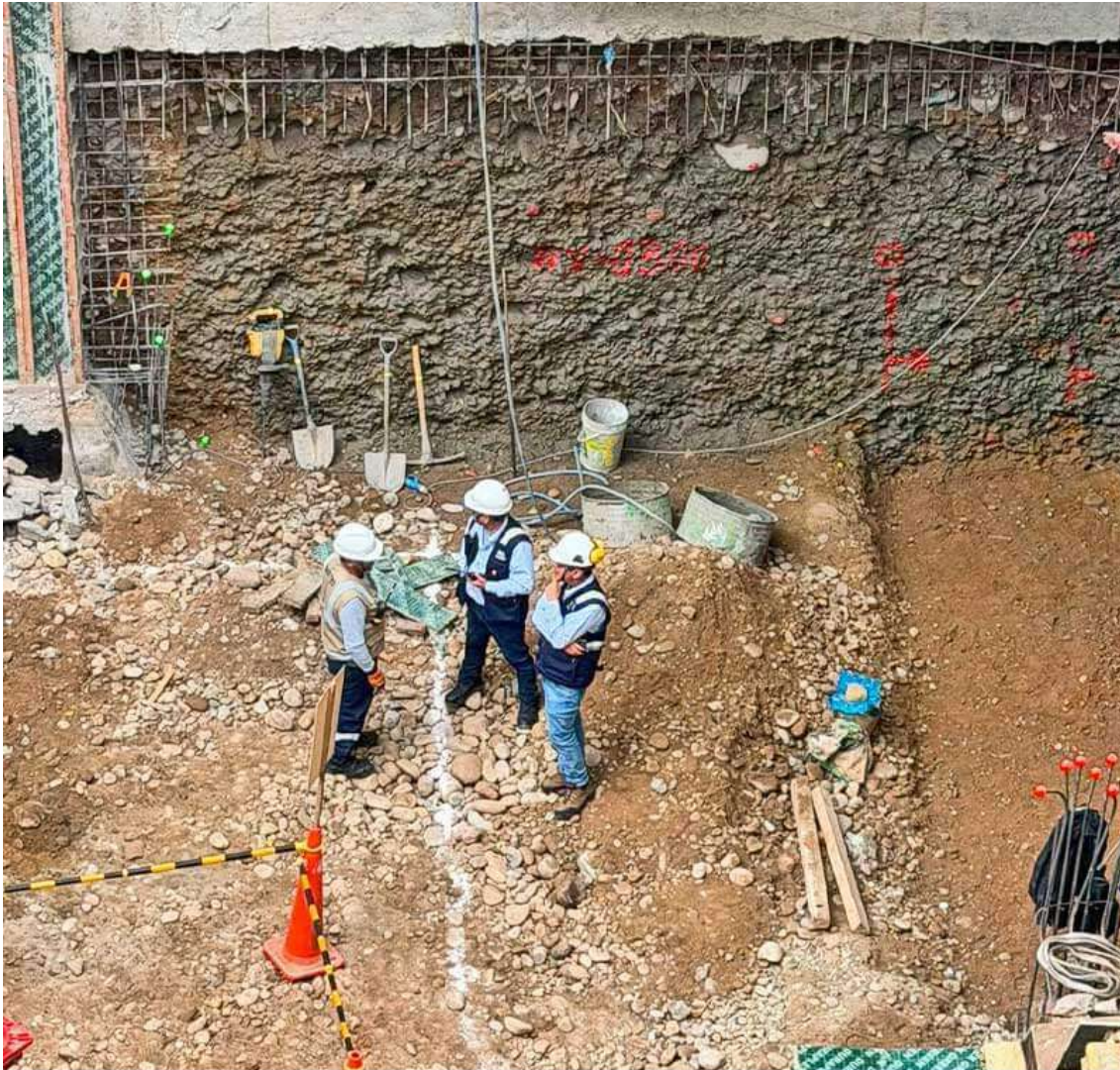
AVANCE DE OBRA - JULIO 2026
