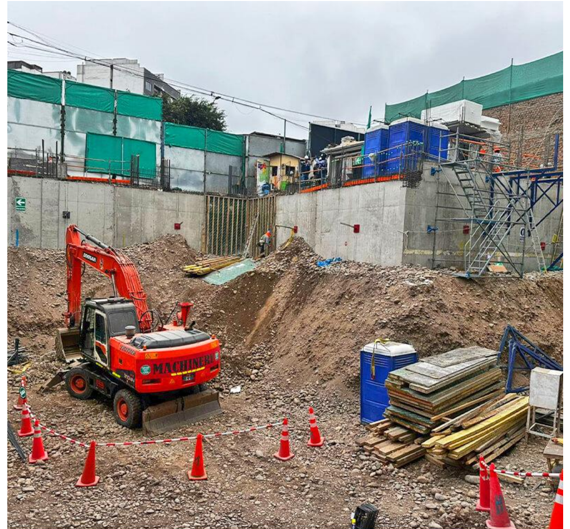
AVANCE DE OBRA - DICIEMBRE 2025
