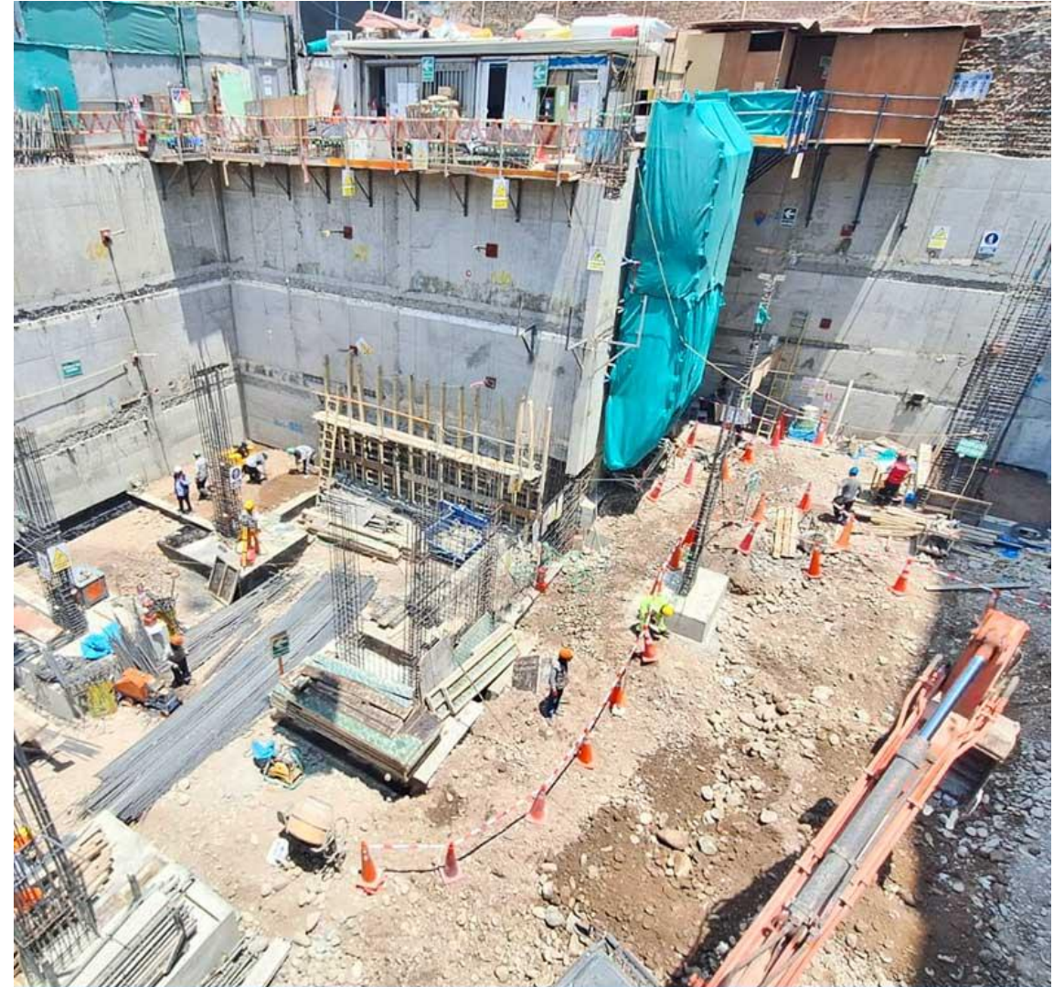
AVANCE DE OBRA - ENERO 2026
