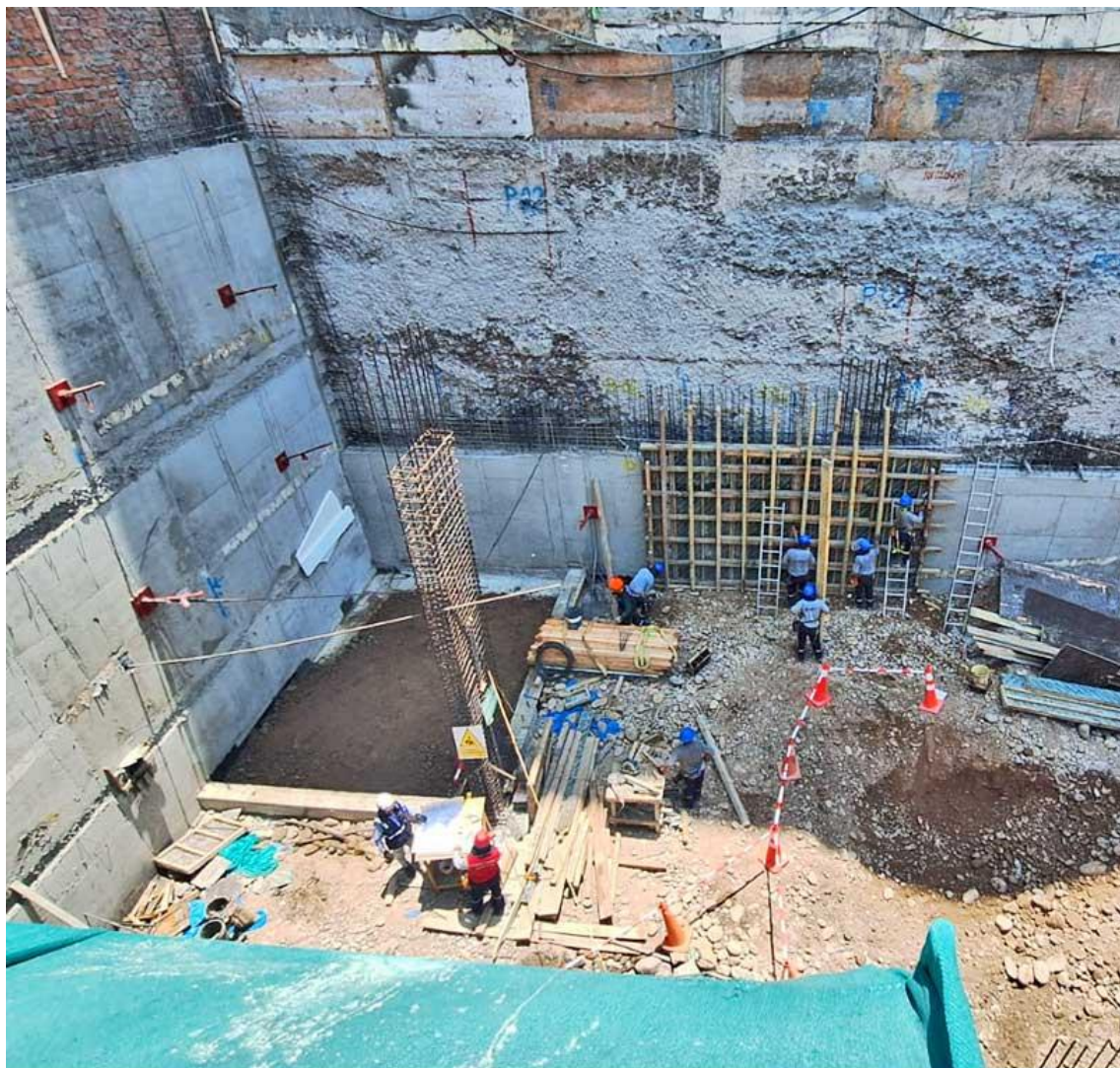
AVANCE DE OBRA - ENERO 2026
