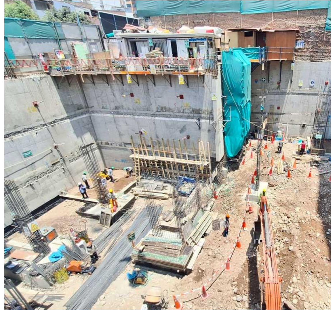
AVANCE DE OBRA - ENERO 2026
