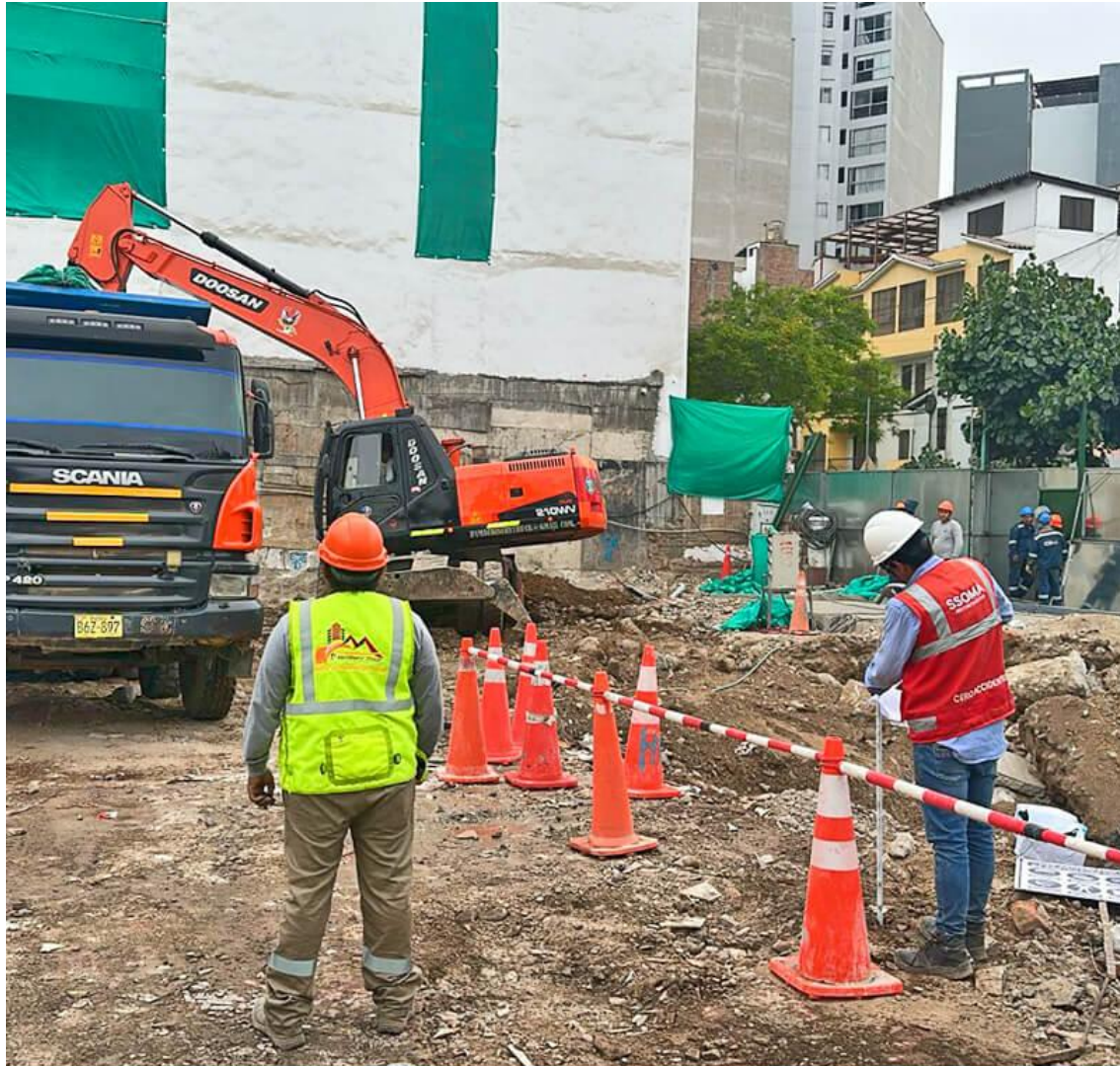
AVANCE DE OBRA - NOVIEMBRE 2025
