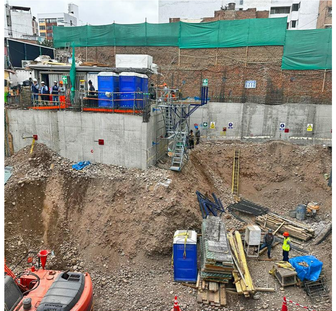
AVANCE DE OBRA - DICIEMBRE 2025
