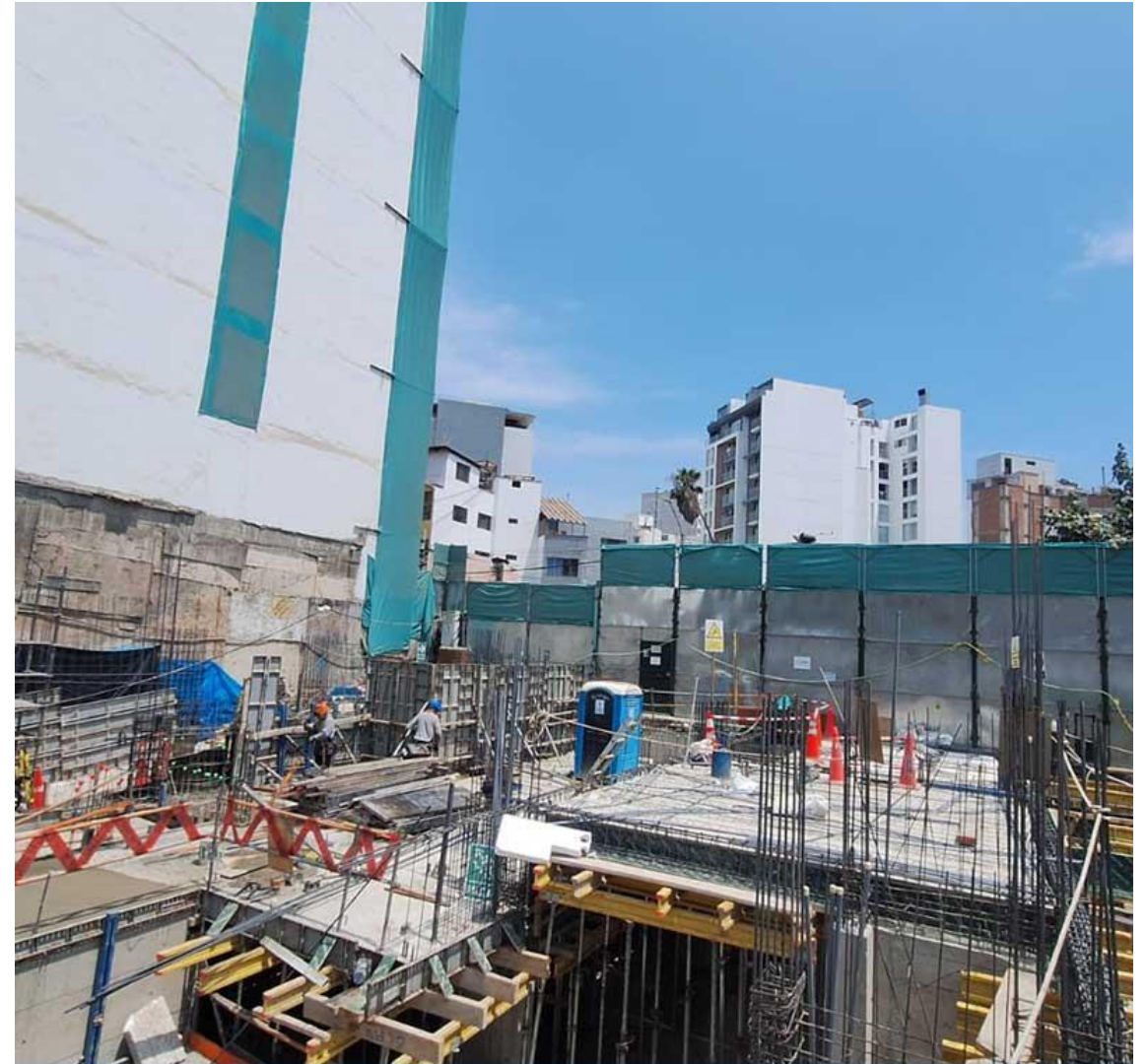
AVANCE DE OBRA - MARZO 2026
