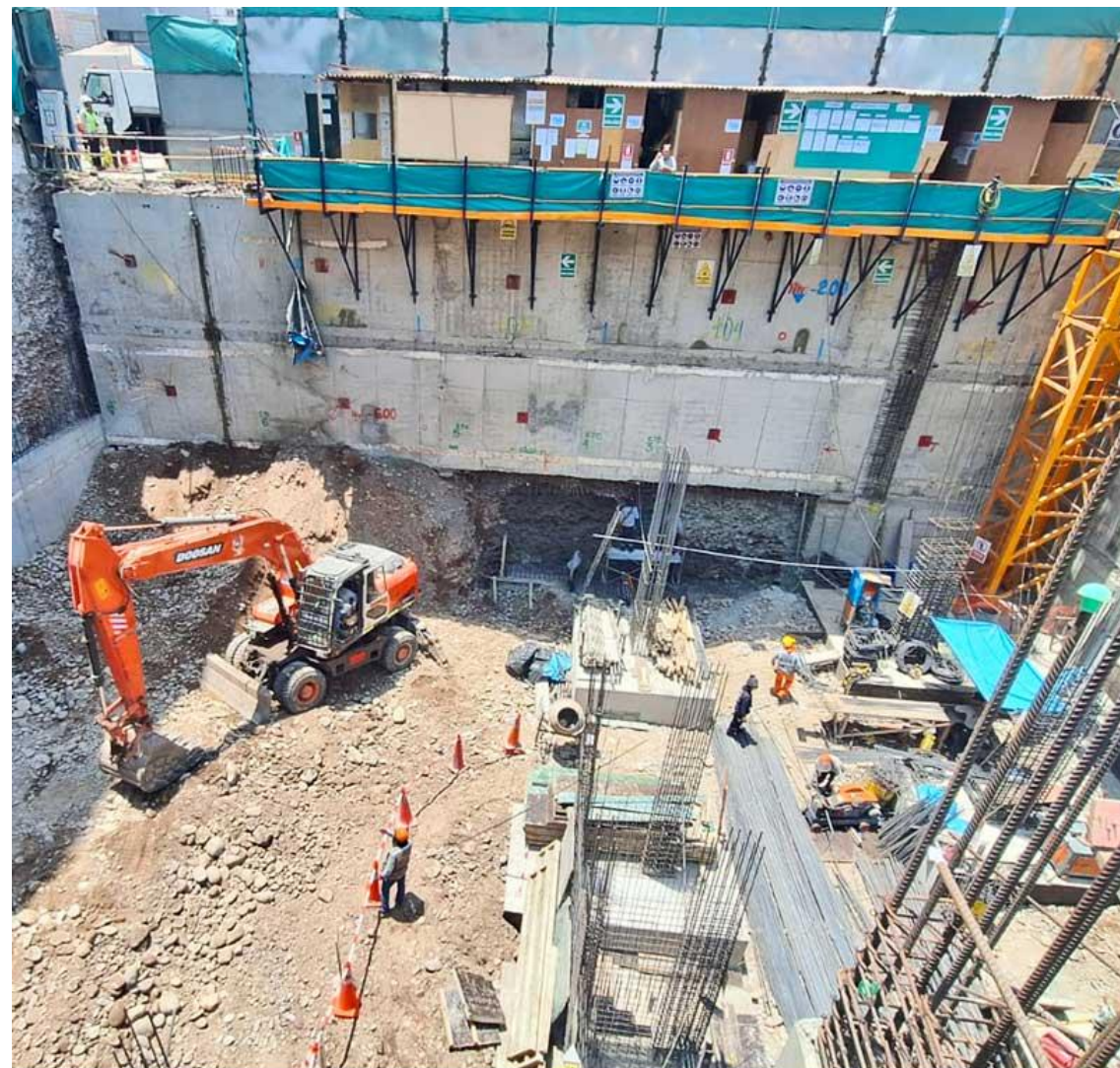
AVANCE DE OBRA - ENERO 2026
