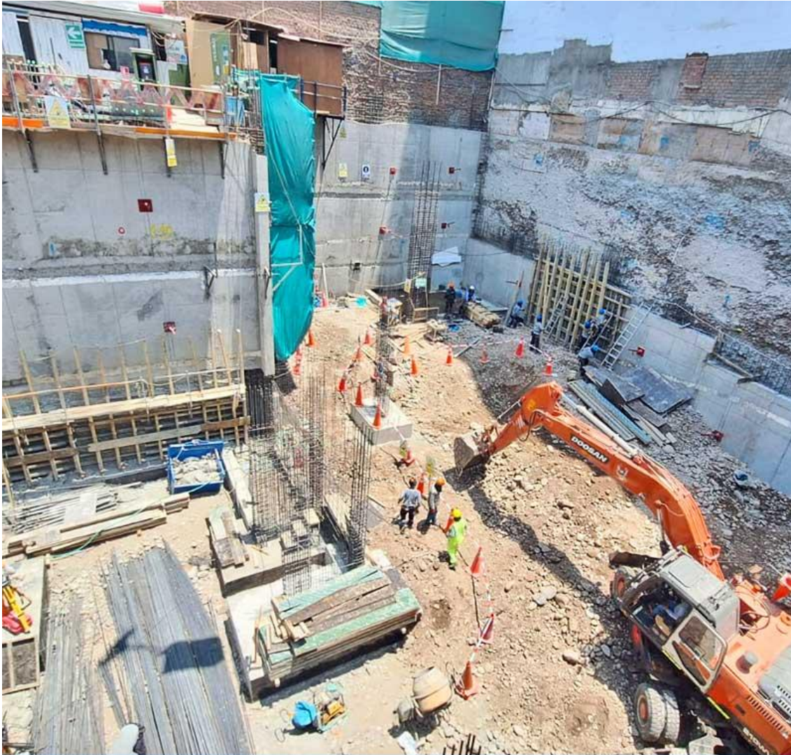
AVANCE DE OBRA - ENERO 2026
