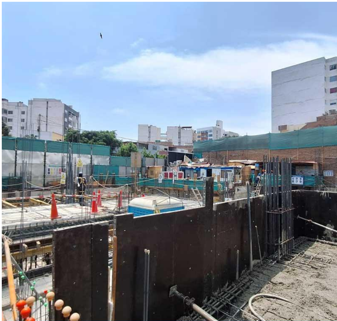
AVANCE DE OBRA - MARZO 2026
