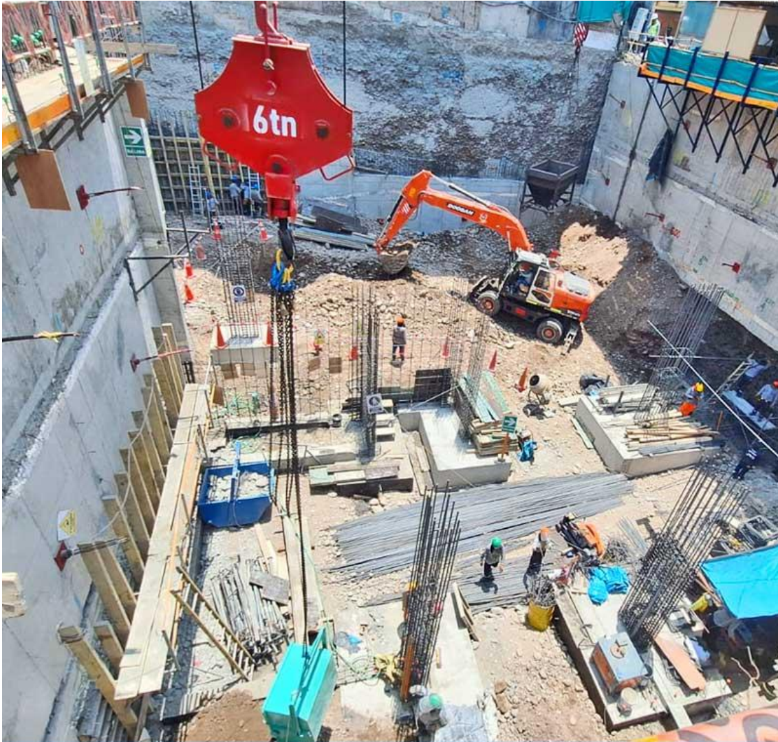
AVANCE DE OBRA - ENERO 2026
