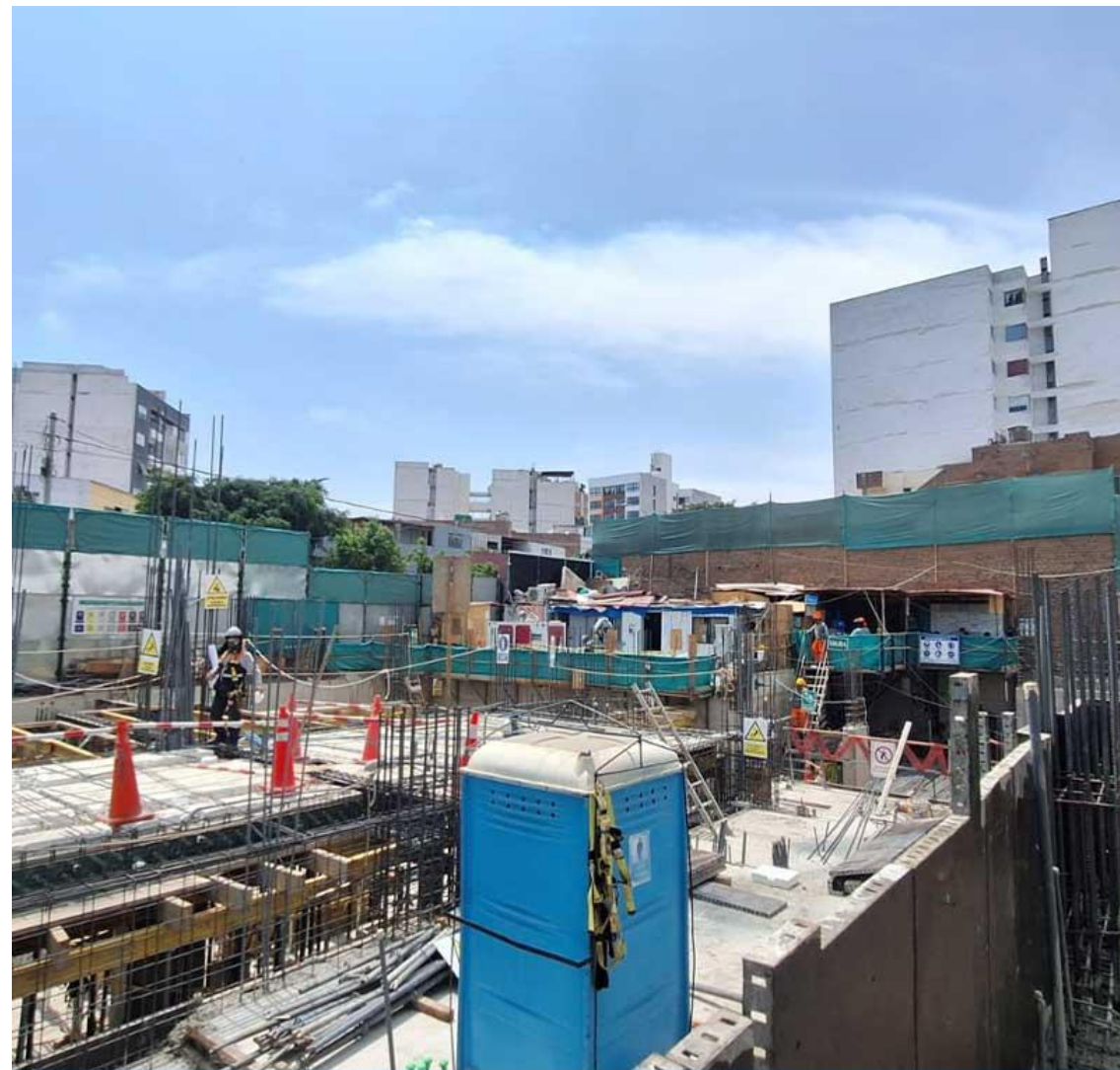
AVANCE DE OBRA - MARZO 2026
