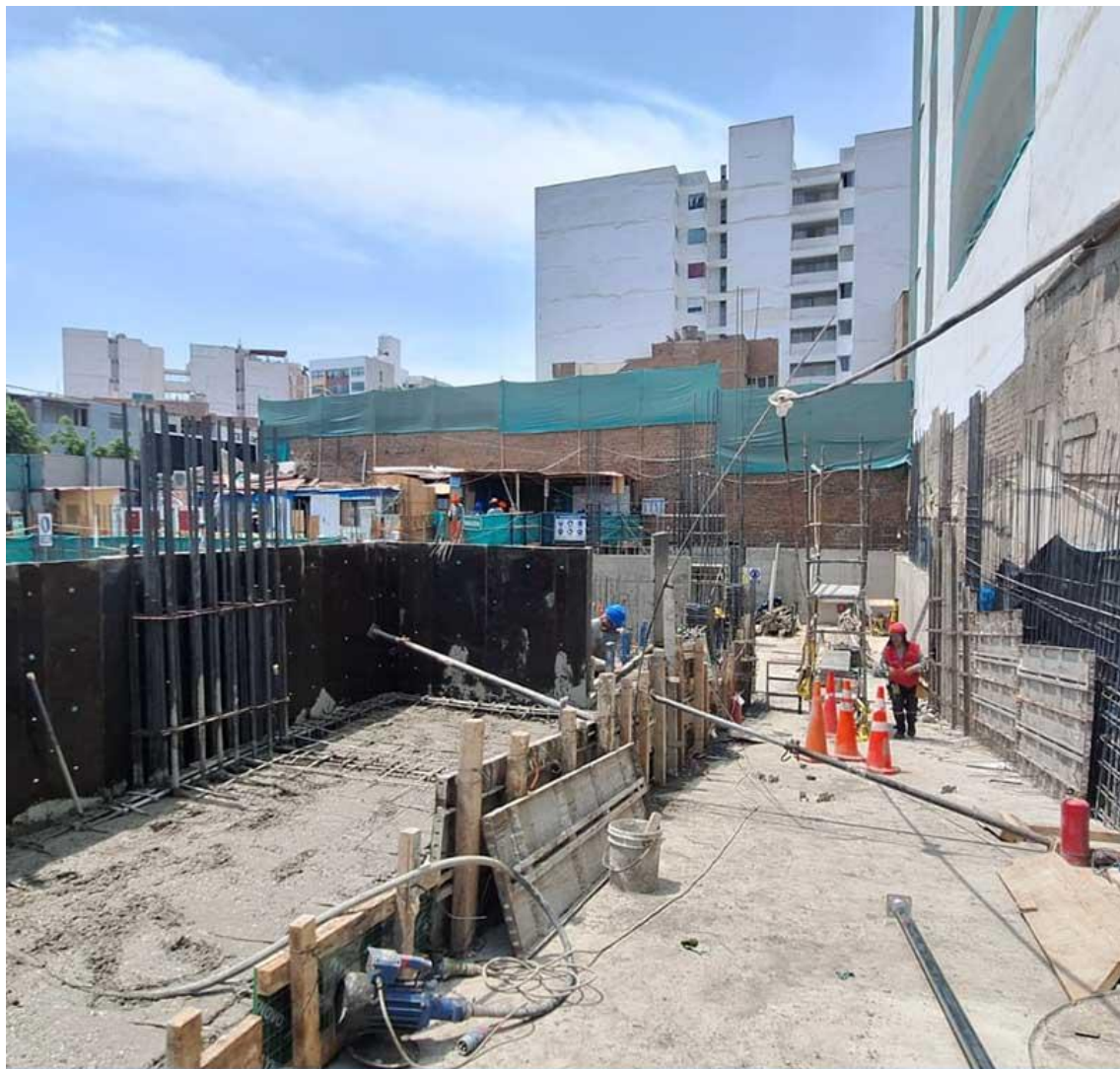
AVANCE DE OBRA - MARZO 2026
