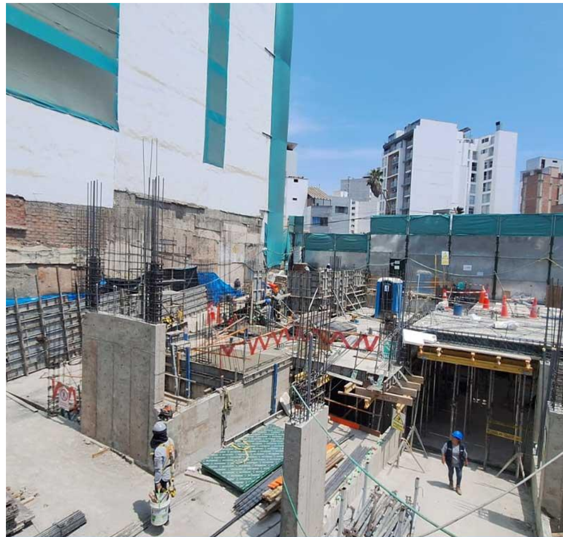
AVANCE DE OBRA - MARZO 2026
