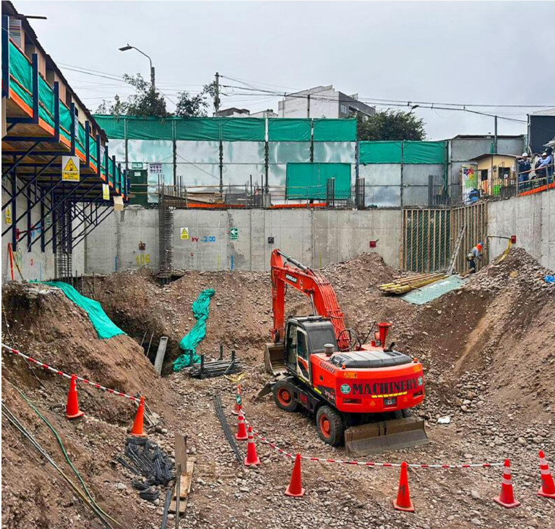
AVANCE DE OBRA - DICIEMBRE 2025
