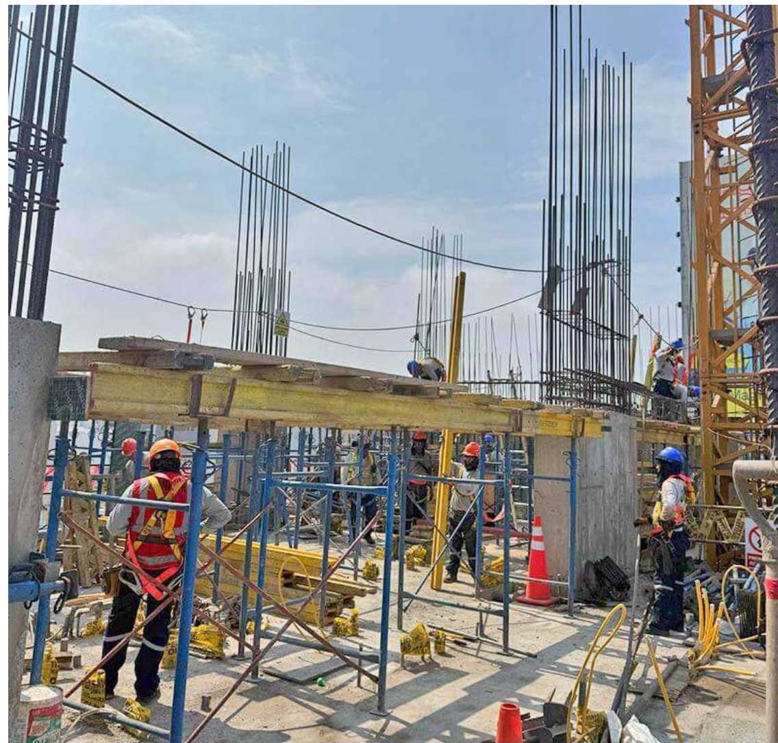
AVANCE DE OBRA - ABRIL 2025
