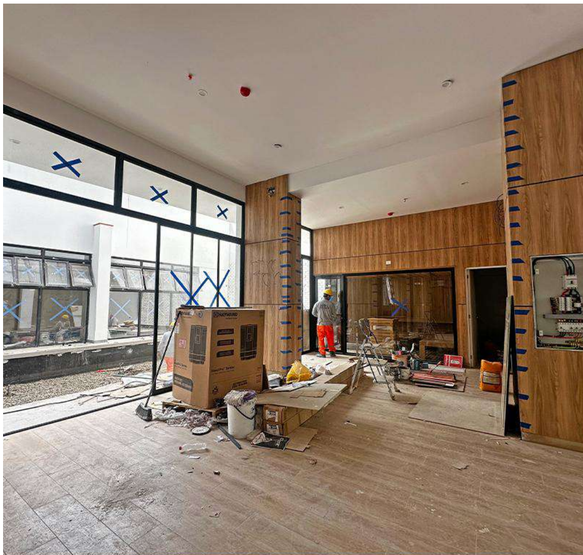
AVANCE DE OBRA - ENERO 2026
