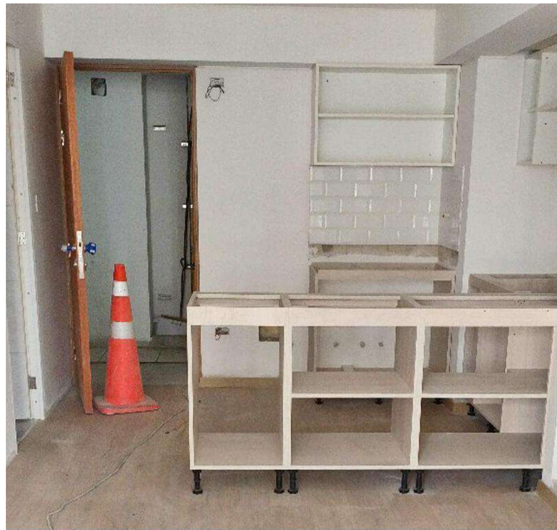
AVANCE DE OBRA - JULIO 2025
