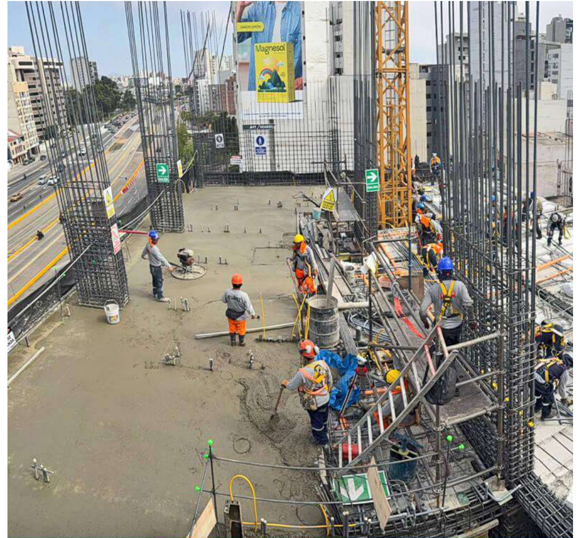
AVANCE DE OBRA - ENERO 2025
