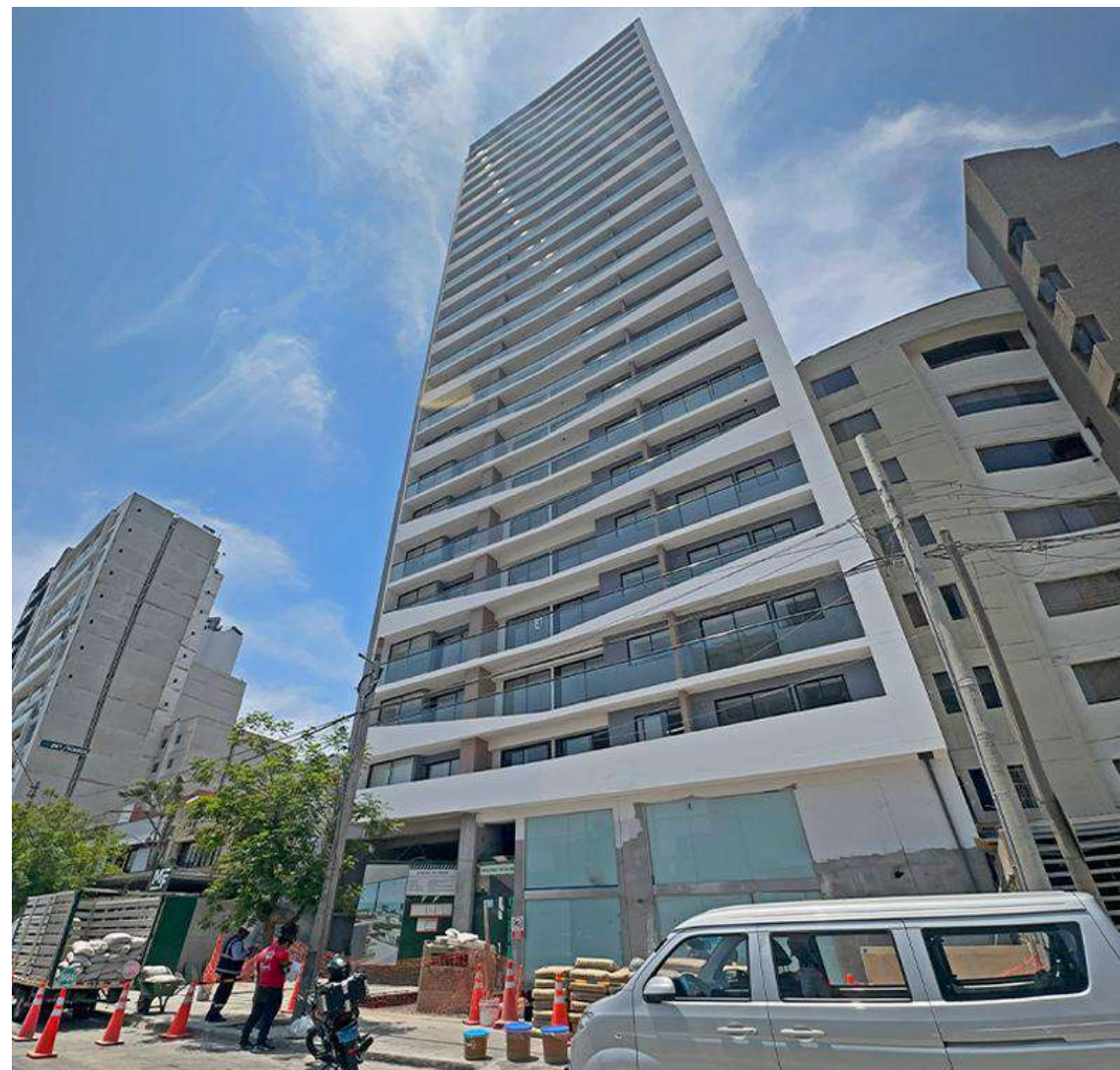
AVANCE DE OBRA - ENERO 2026
