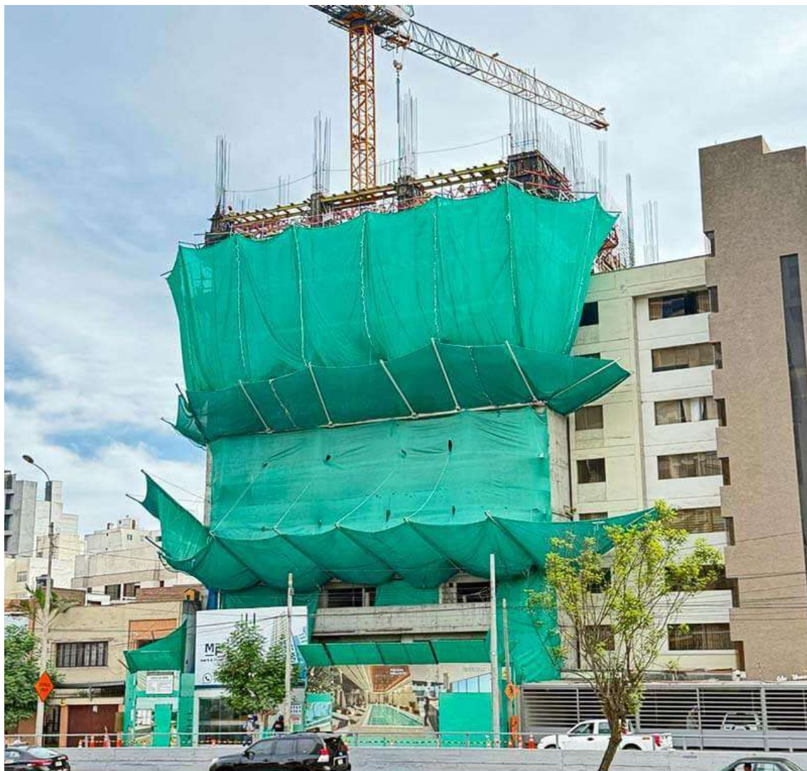
AVANCE DE OBRA - ABRIL 2025
