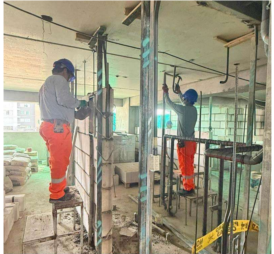
AVANCE DE OBRA - MAYO 2025
