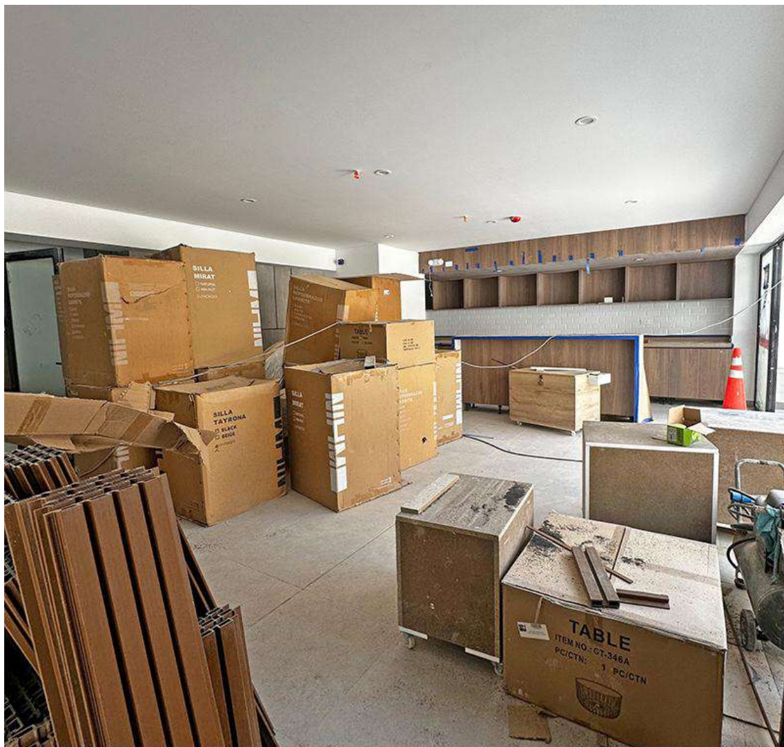
AVANCE DE OBRA - ENERO 2026
