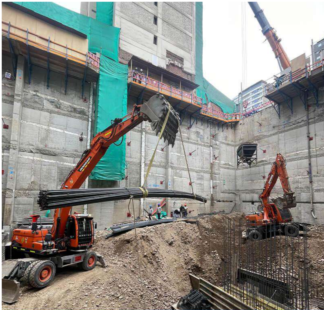
AVANCE DE OBRA - SEPTIEMBRE 2024
