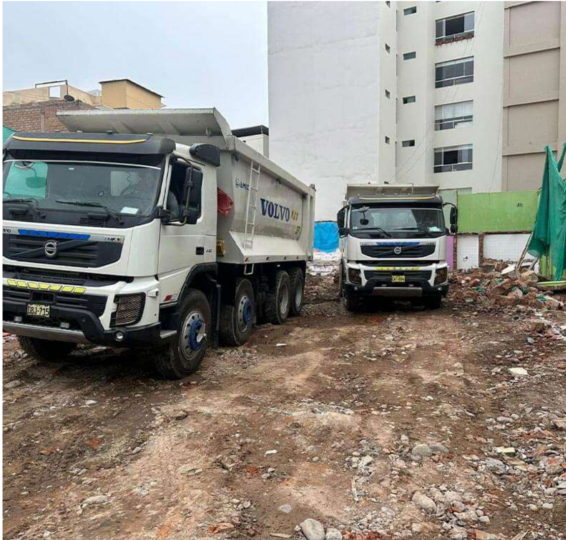
AVANCE DE OBRA - MAYO 2024
