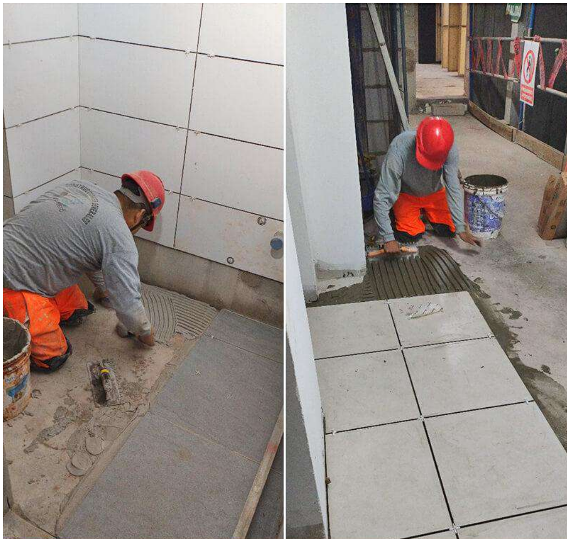
AVANCE DE OBRA - JULIO 2025
