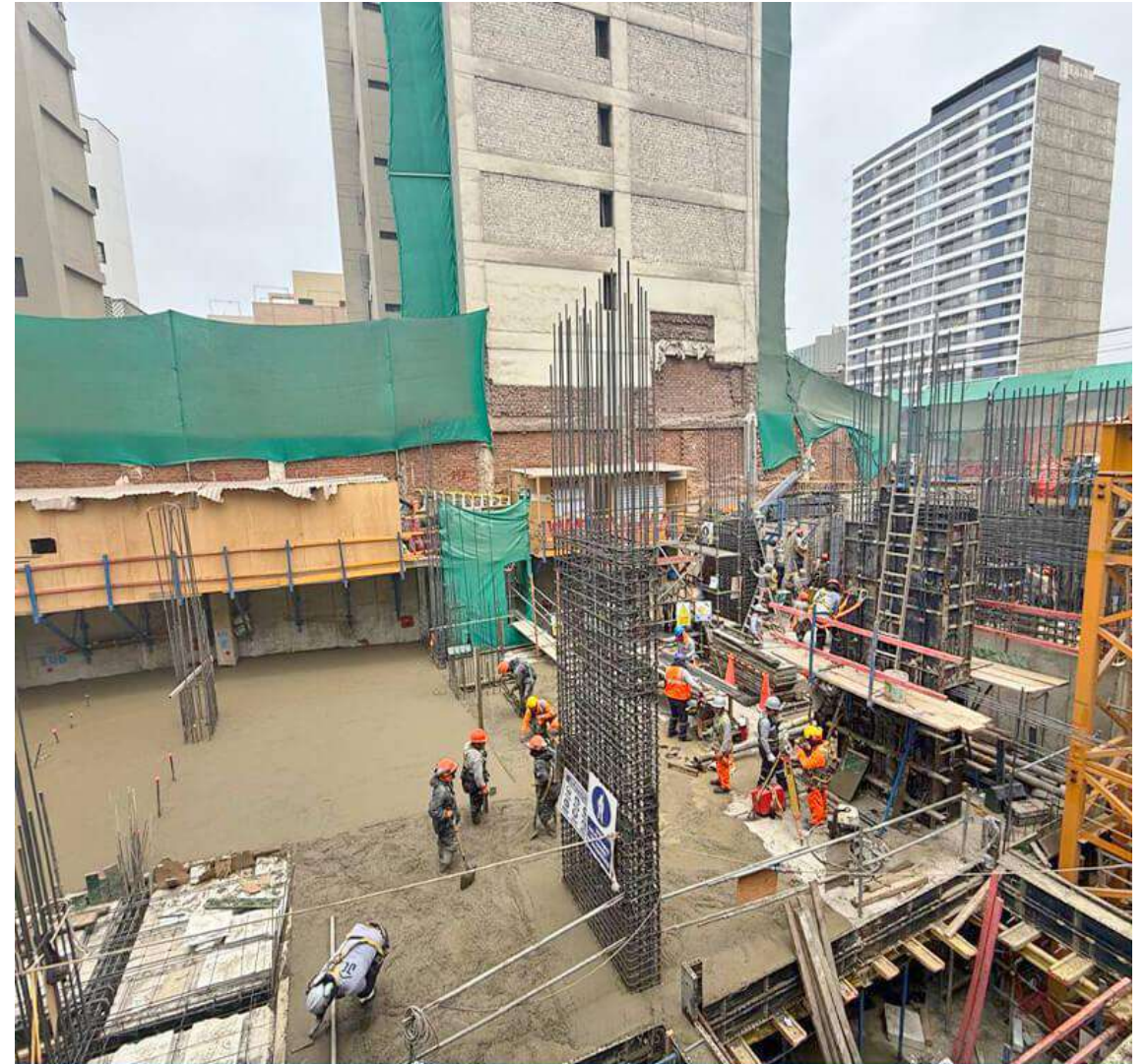
AVANCE DE OBRA - NOVIEMBRE 2024
