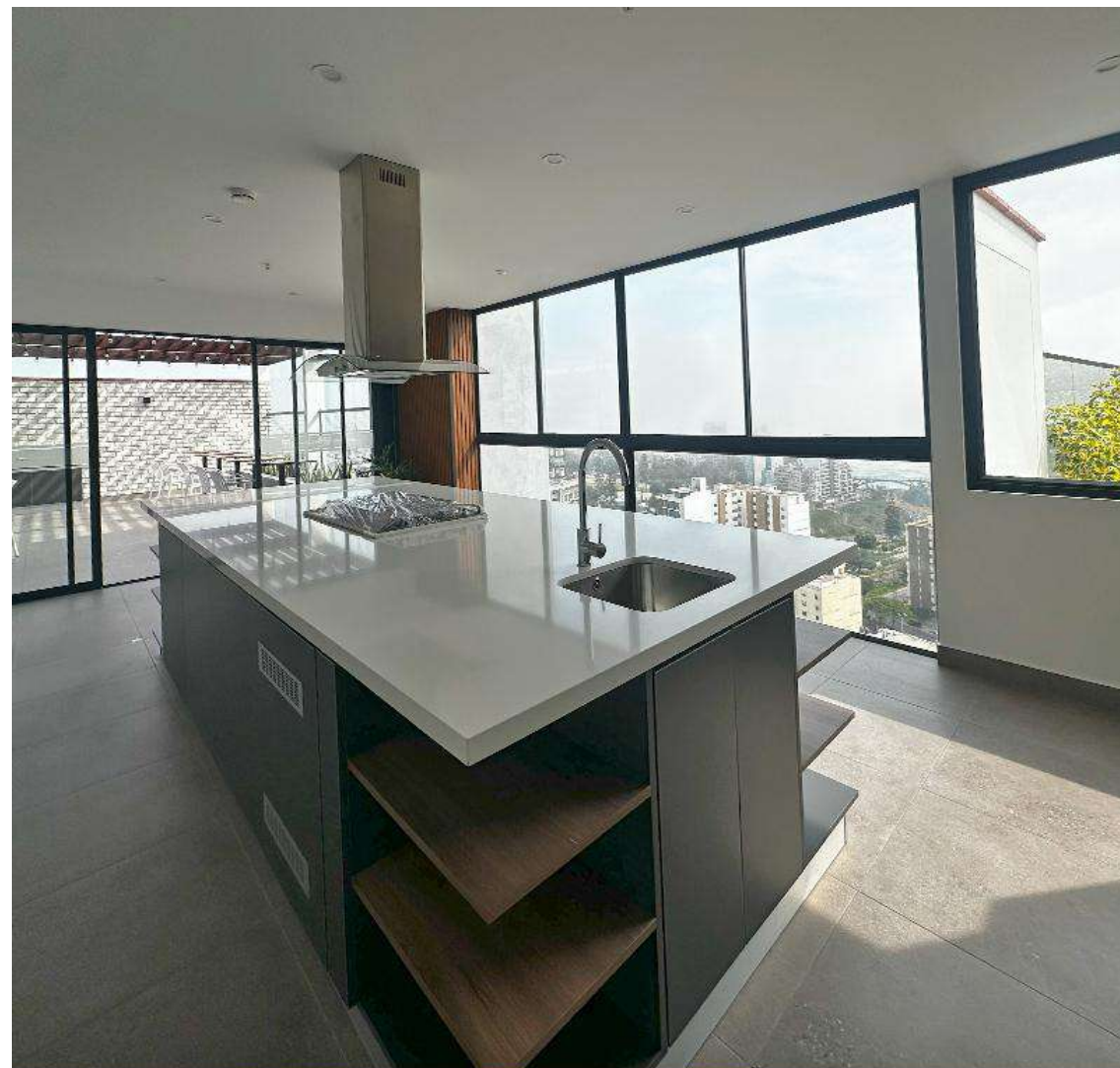
AVANCE DE OBRA - MARZO 2026
