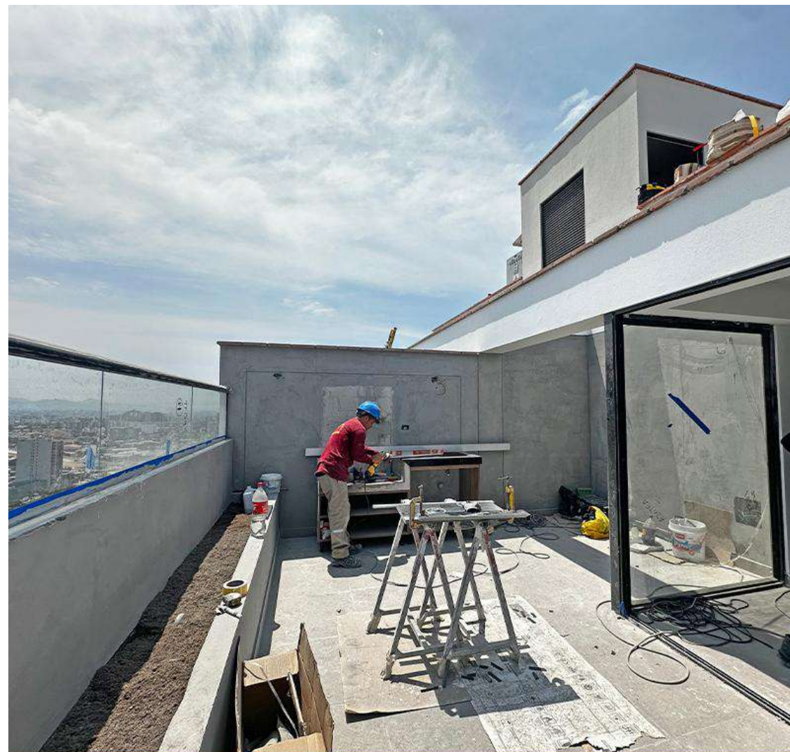
AVANCE DE OBRA - ENERO 2026
