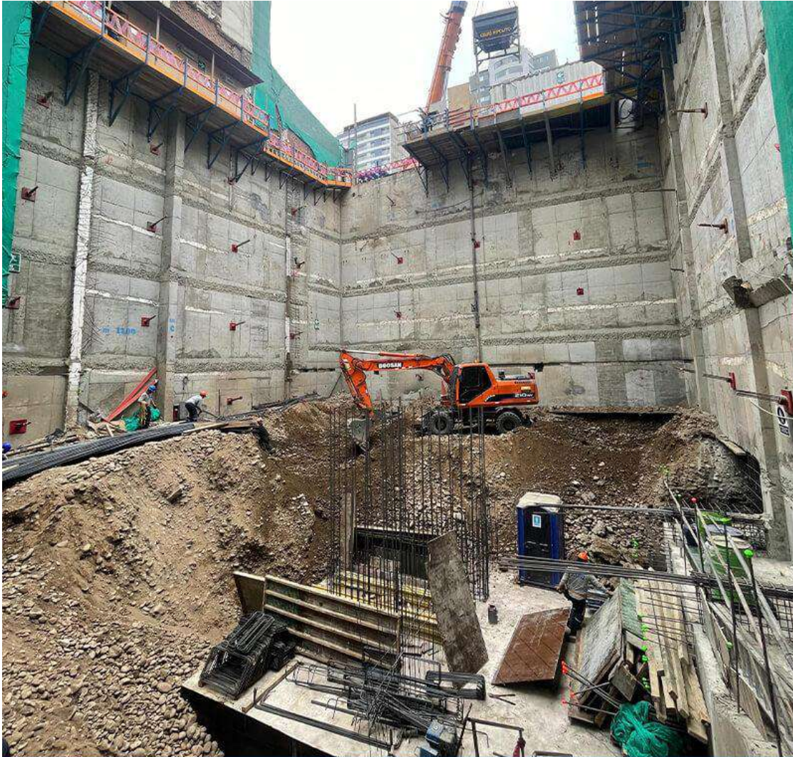
AVANCE DE OBRA - SEPTIEMBRE 2024
