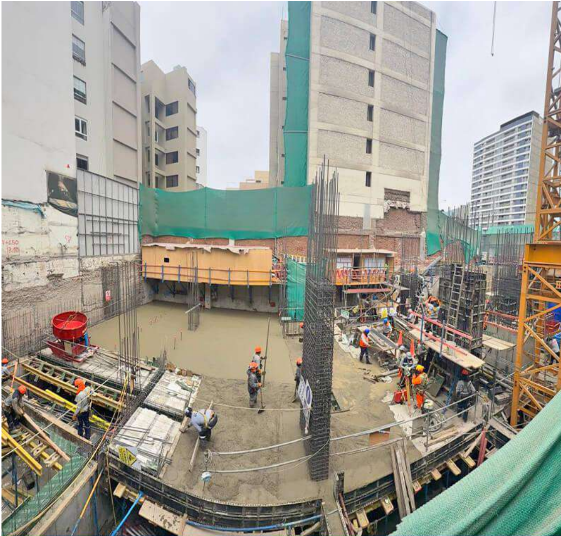
AVANCE DE OBRA - NOVIEMBRE 2024
