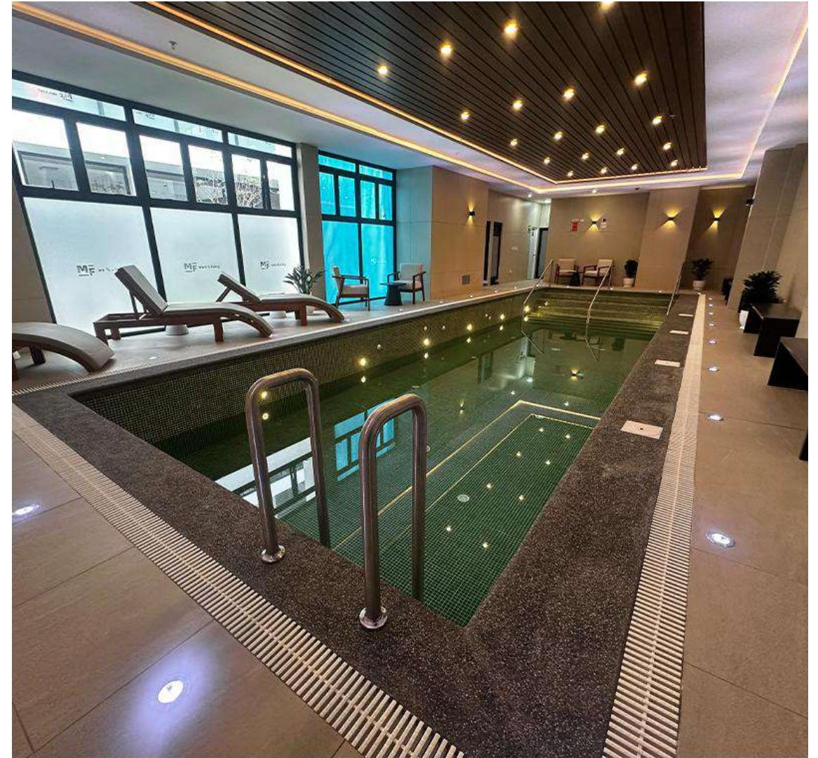
AVANCE DE OBRA - MARZO 2026
