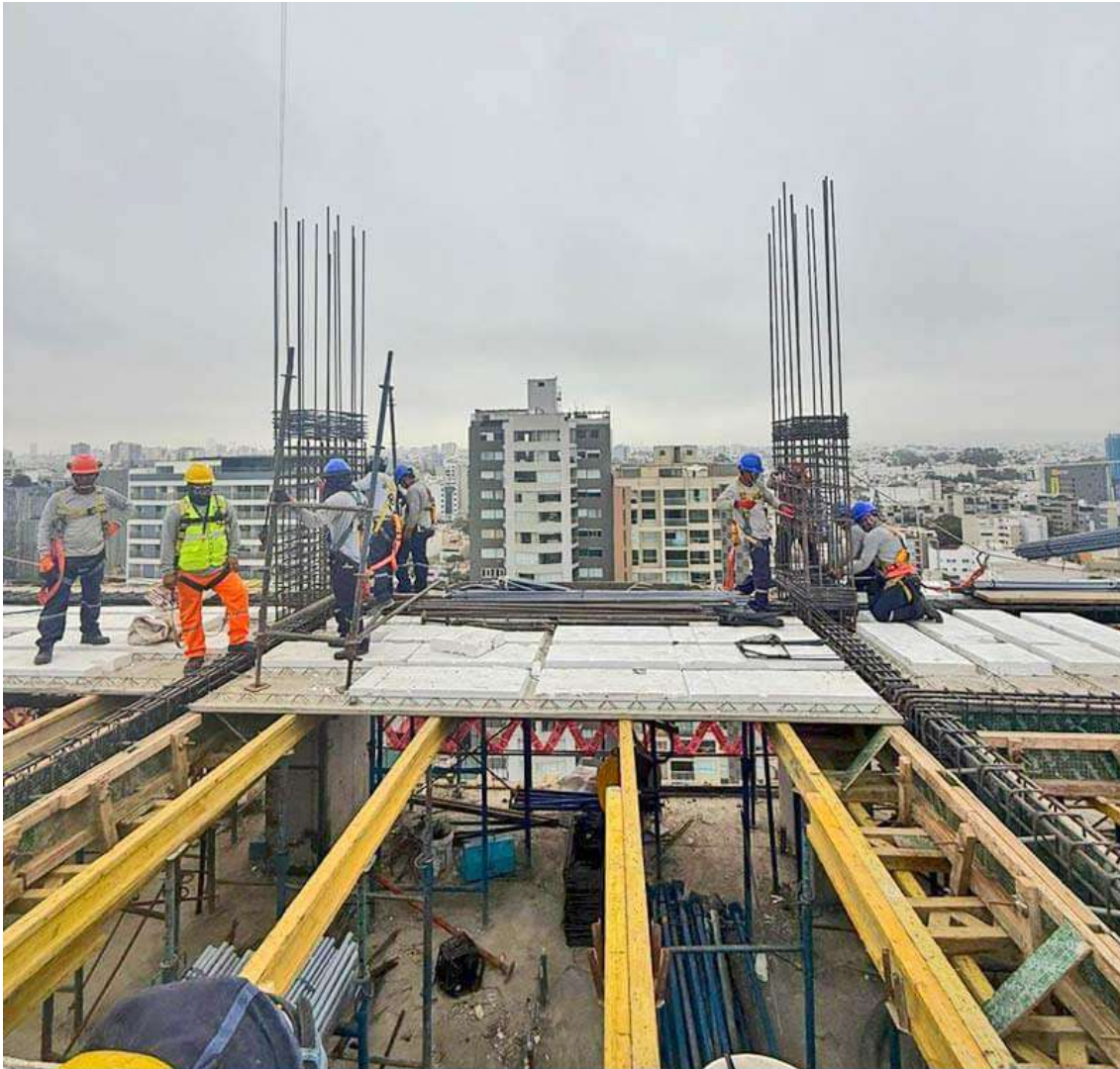
AVANCE DE OBRA - MAYO 2025
