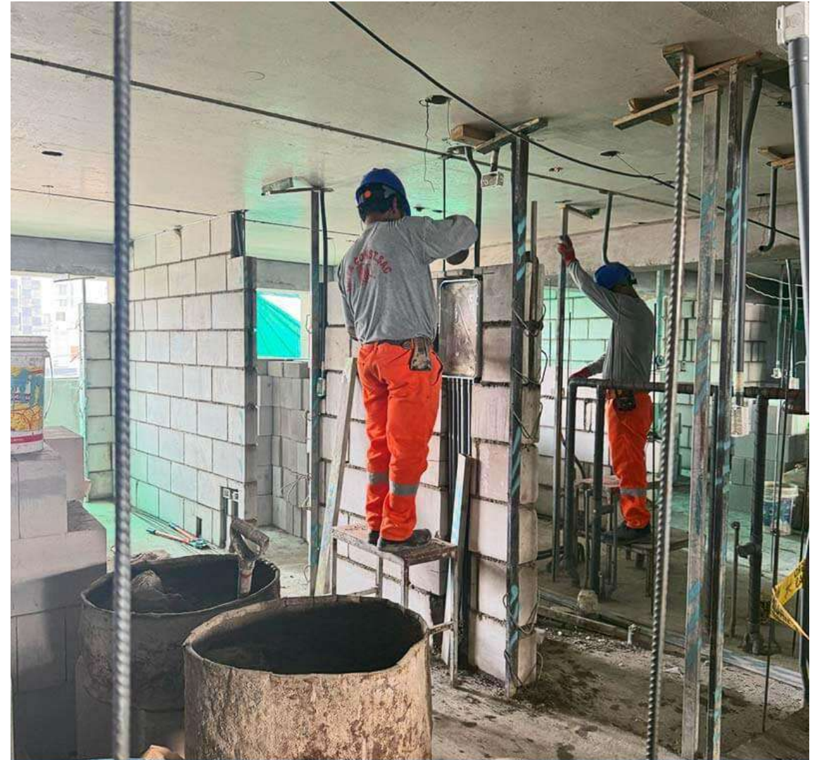
AVANCE DE OBRA - ABRIL 2025
