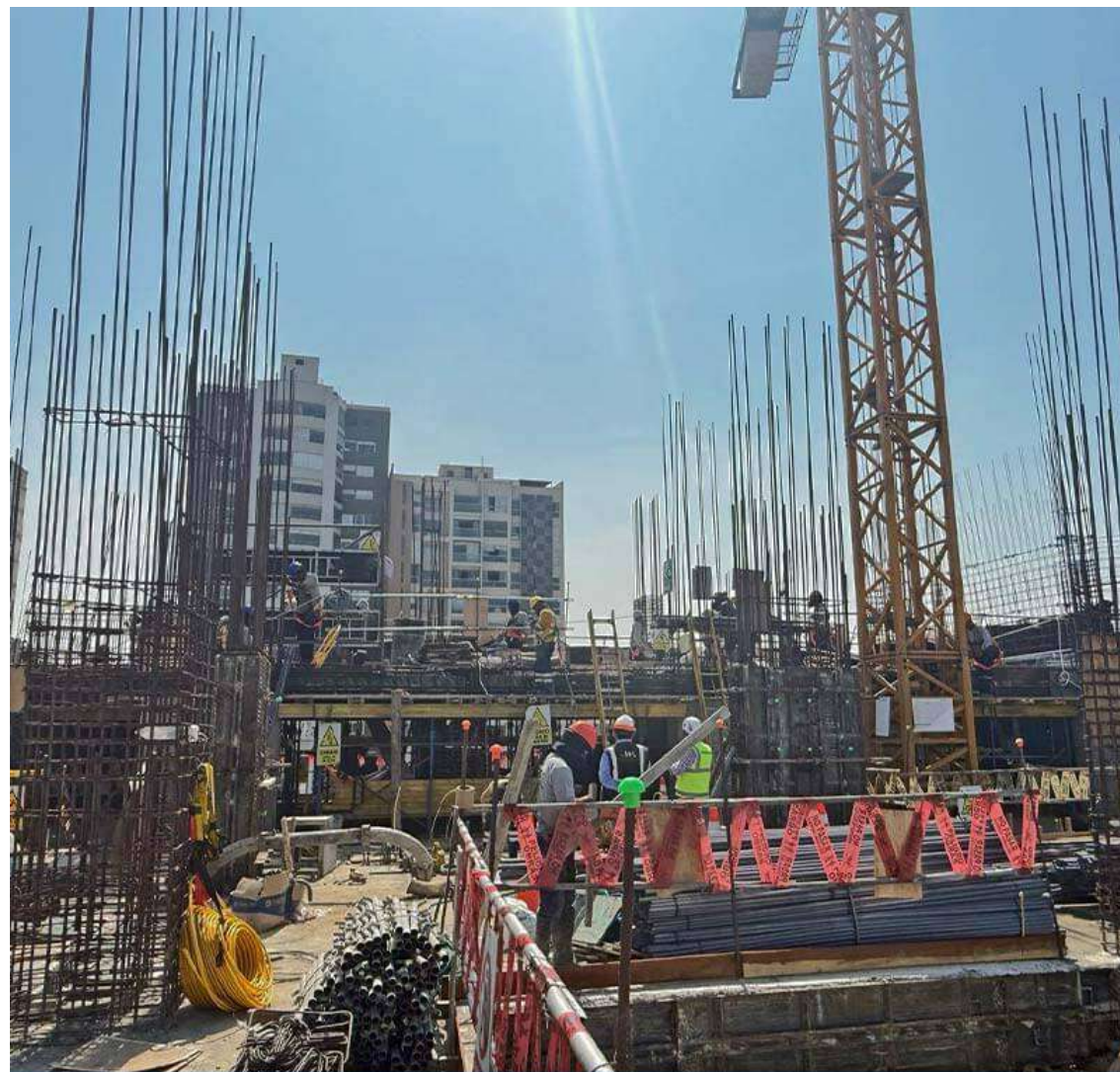
AVANCE DE OBRA - ABRIL 2025
