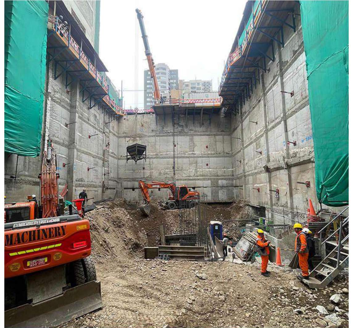
AVANCE DE OBRA - SEPTIEMBRE 2024
