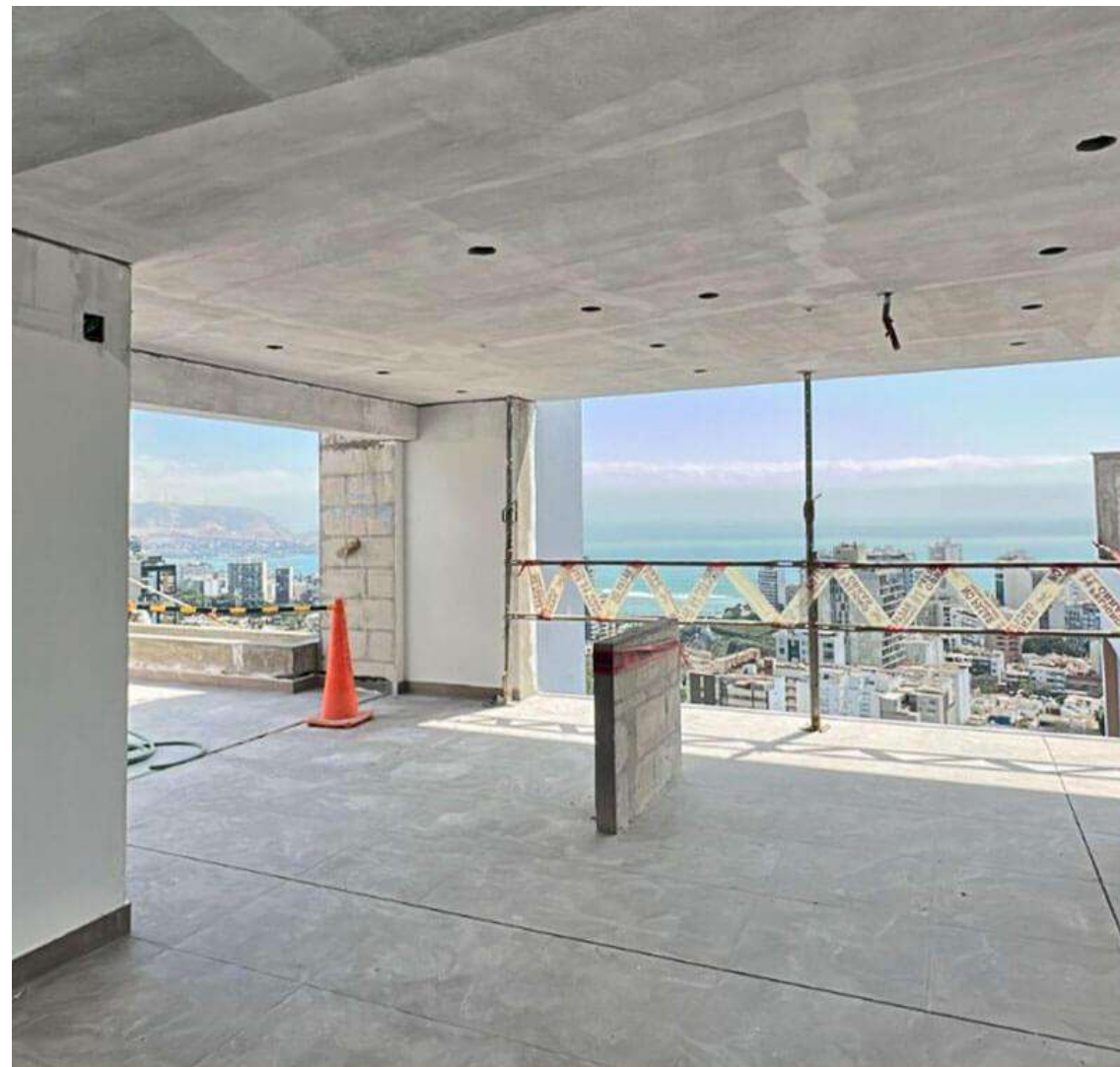
AVANCE DE OBRA - OCTUBRE 2025
