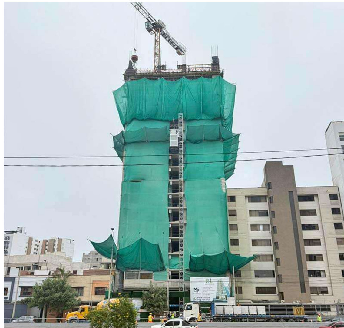
AVANCE DE OBRA - MAYO 2025
