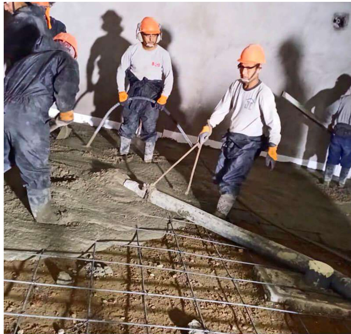
AVANCE DE OBRA - JULIO 2025
