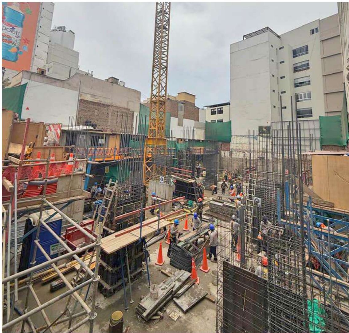
AVANCE DE OBRA - NOVIEMBRE 2024
