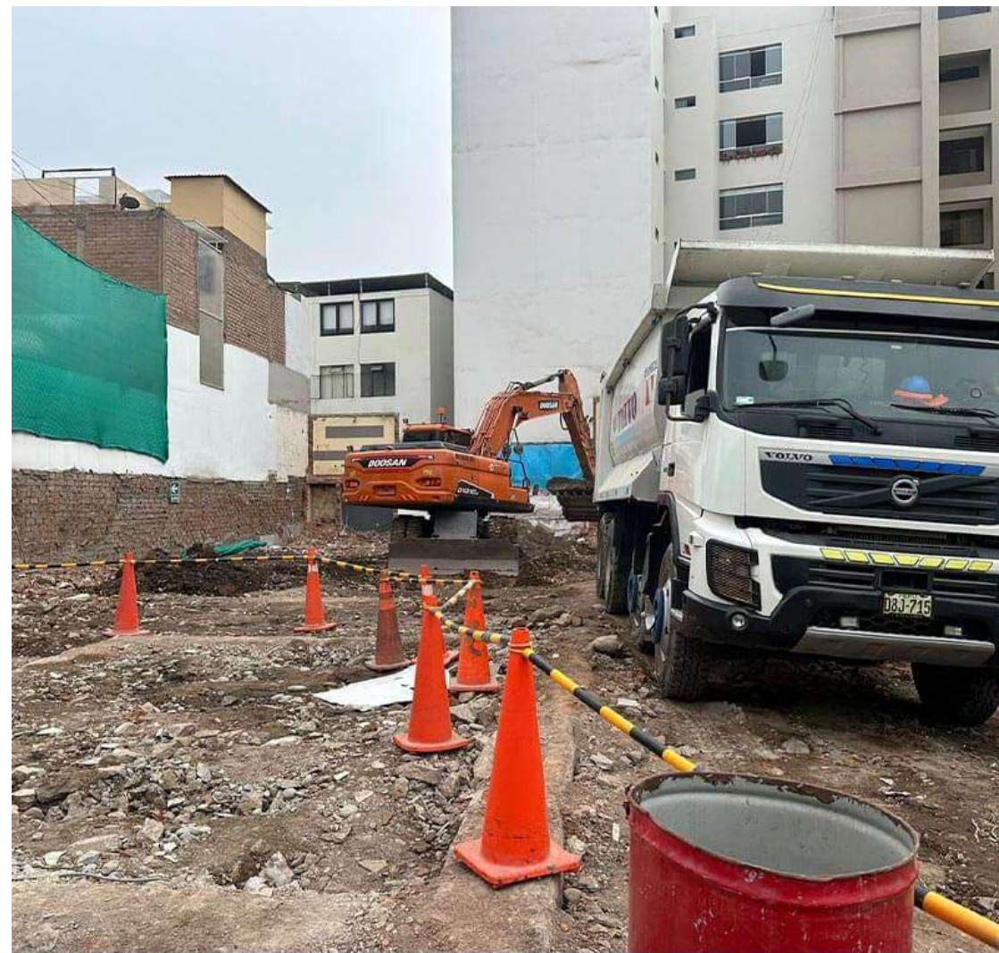
AVANCE DE OBRA - MAYO 2024
