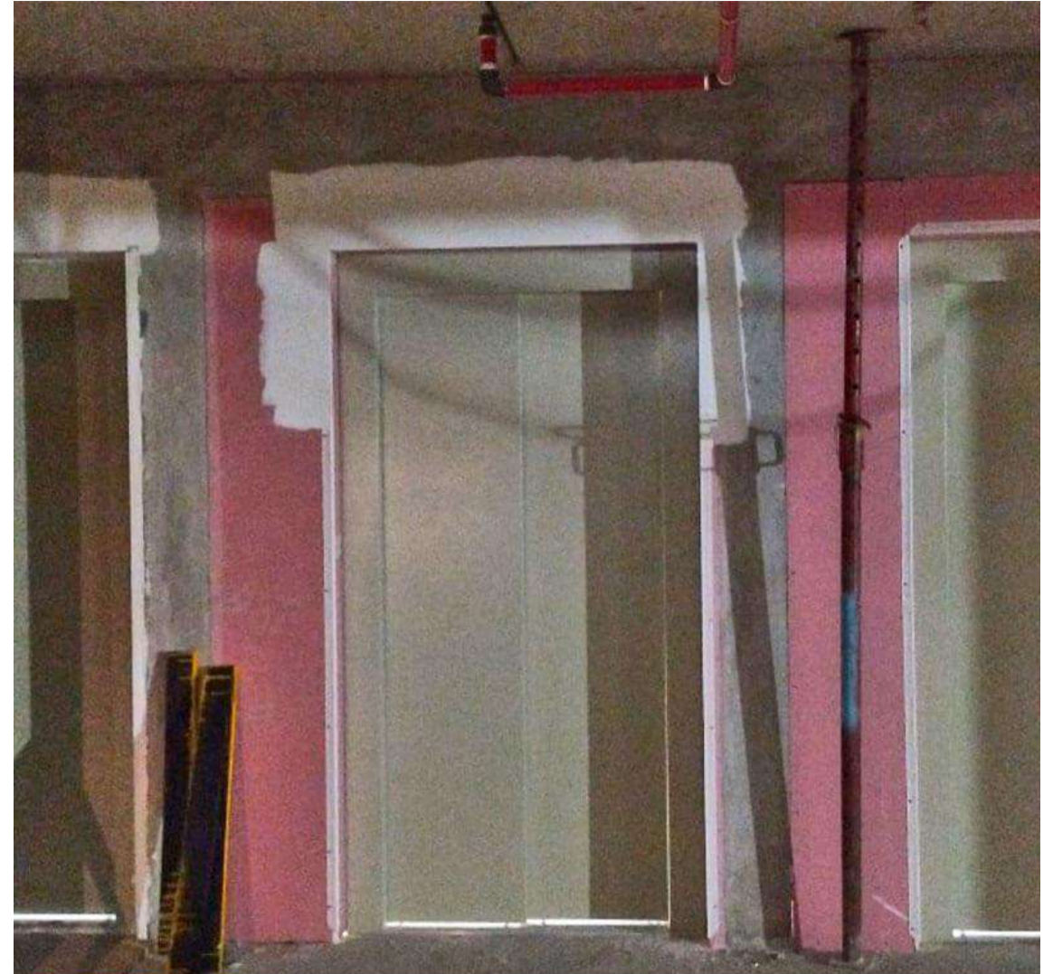
AVANCE DE OBRA - OCTUBRE 2025
