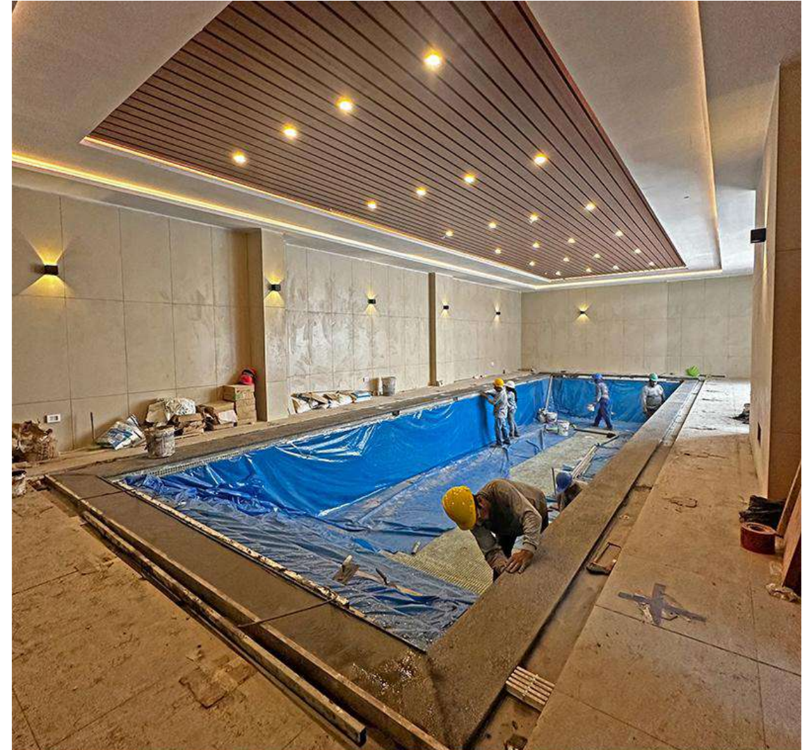
AVANCE DE OBRA - ENERO 2026
