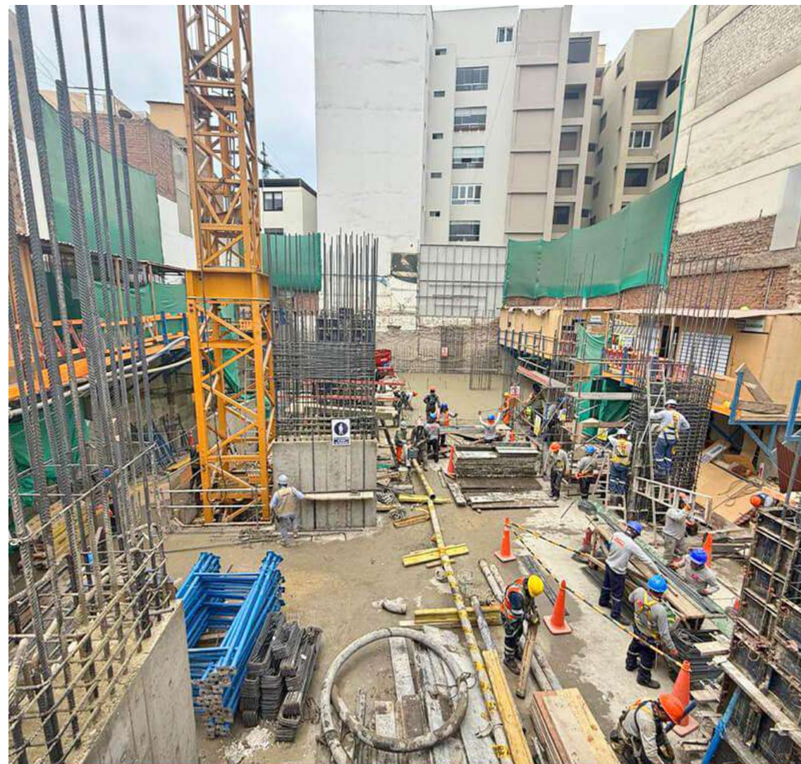
AVANCE DE OBRA - NOVIEMBRE 2024
