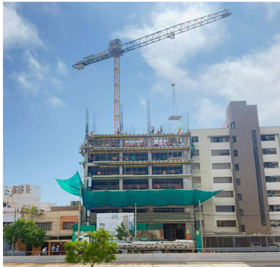
AVANCE DE OBRA - ENERO 2025
