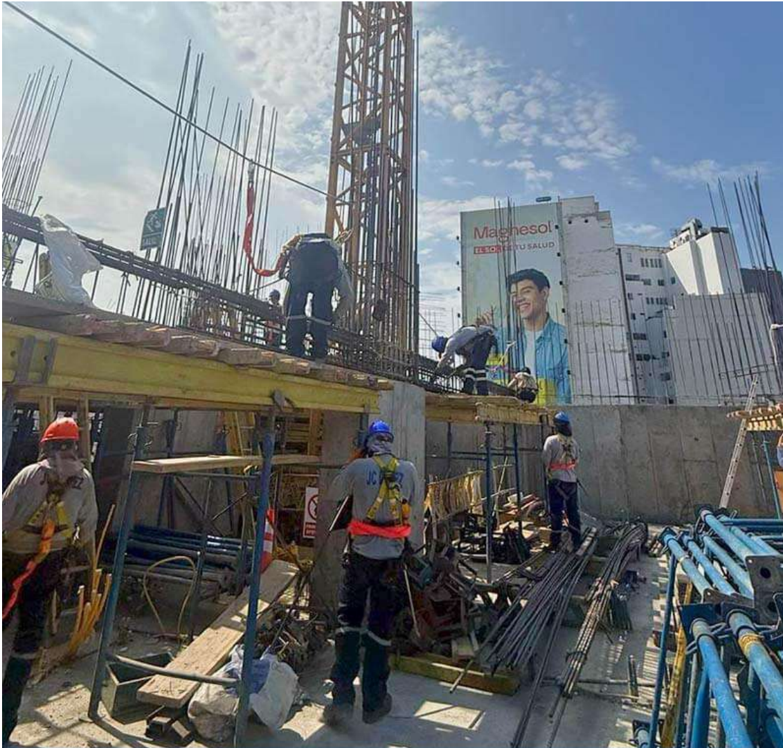
AVANCE DE OBRA - ABRIL 2025
