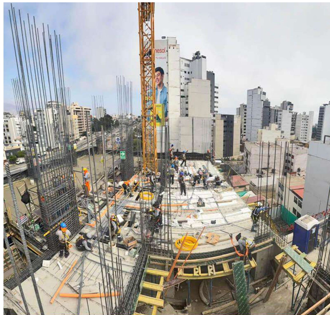
AVANCE DE OBRA - ENERO 2025
