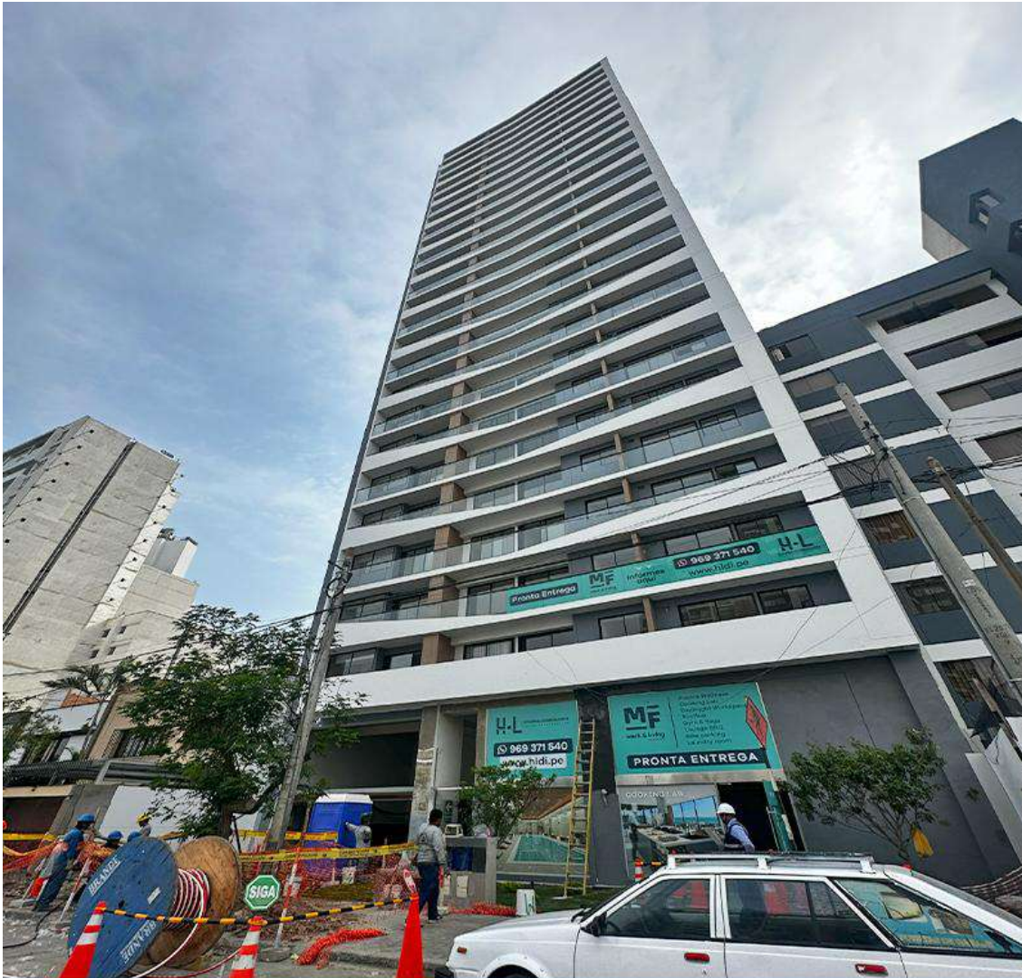
AVANCE DE OBRA - MARZO 2026
