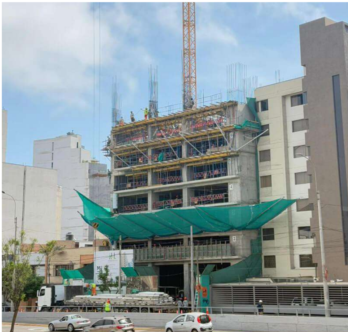
AVANCE DE OBRA - ENERO 2025
