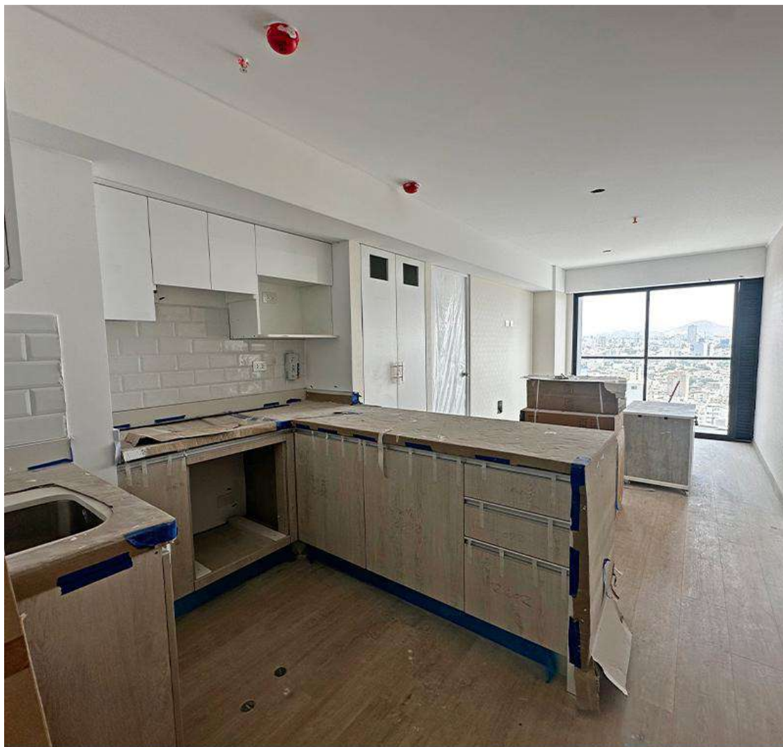
AVANCE DE OBRA - ENERO 2026
