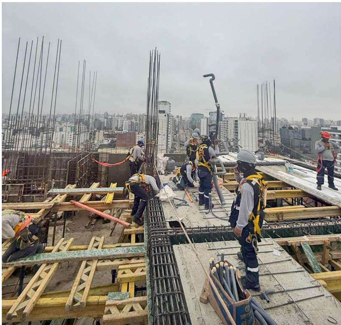
AVANCE DE OBRA - MAYO 2025
