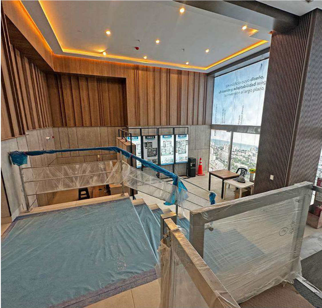
AVANCE DE OBRA - ENERO 2026
