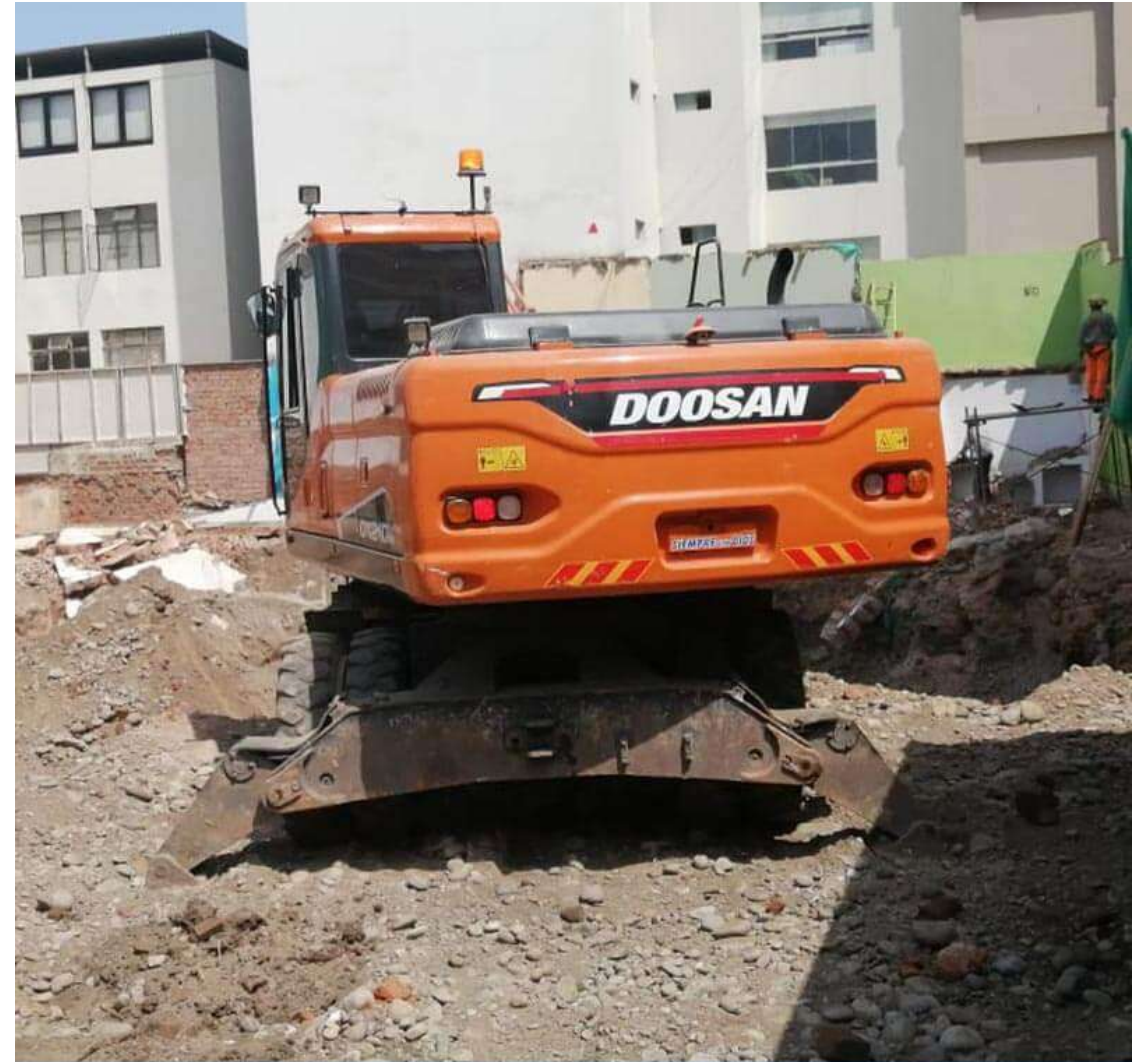
AVANCE DE OBRA - MAYO 2024
