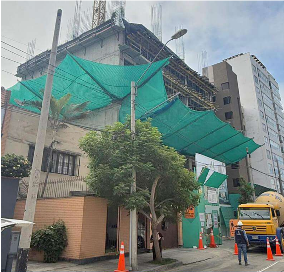
AVANCE DE OBRA - ENERO 2025
