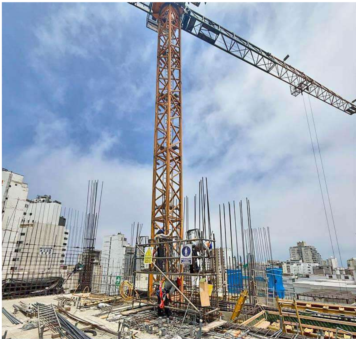
AVANCE DE OBRA - ABRIL 2025
