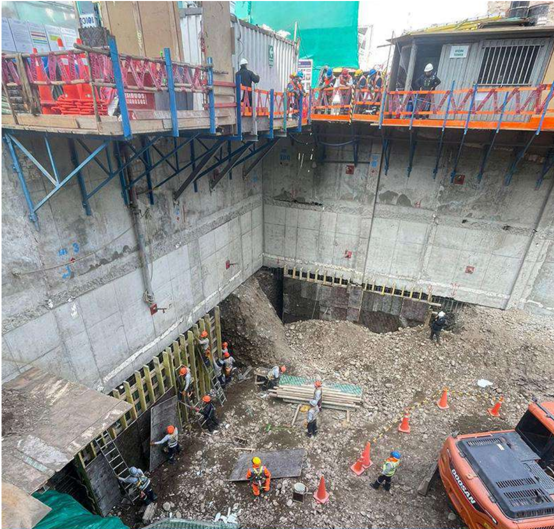
AVANCE DE OBRA - JULIO 2024
