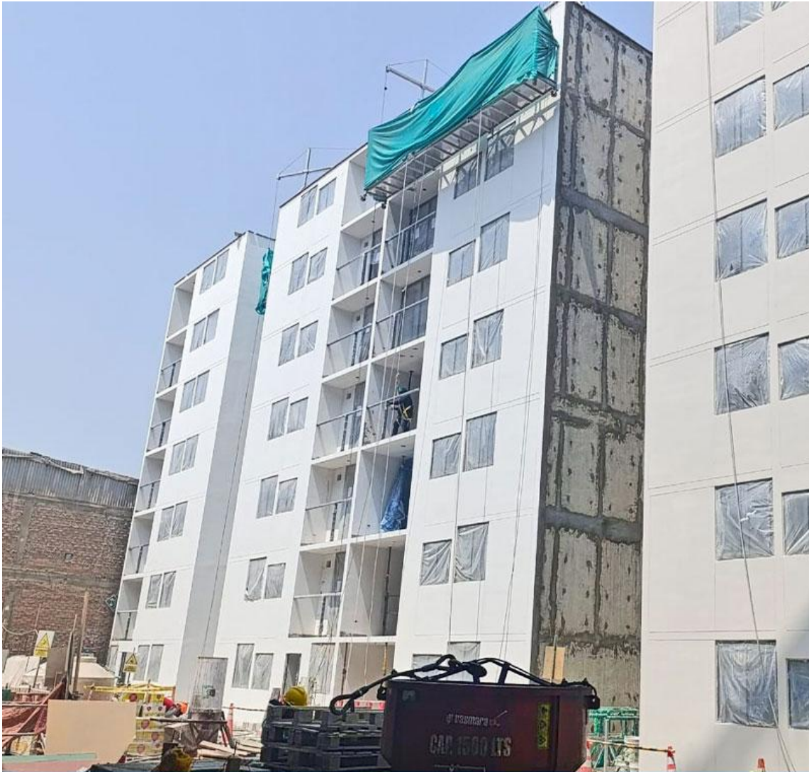
AVANCE DE OBRA - ABRIL 2025
