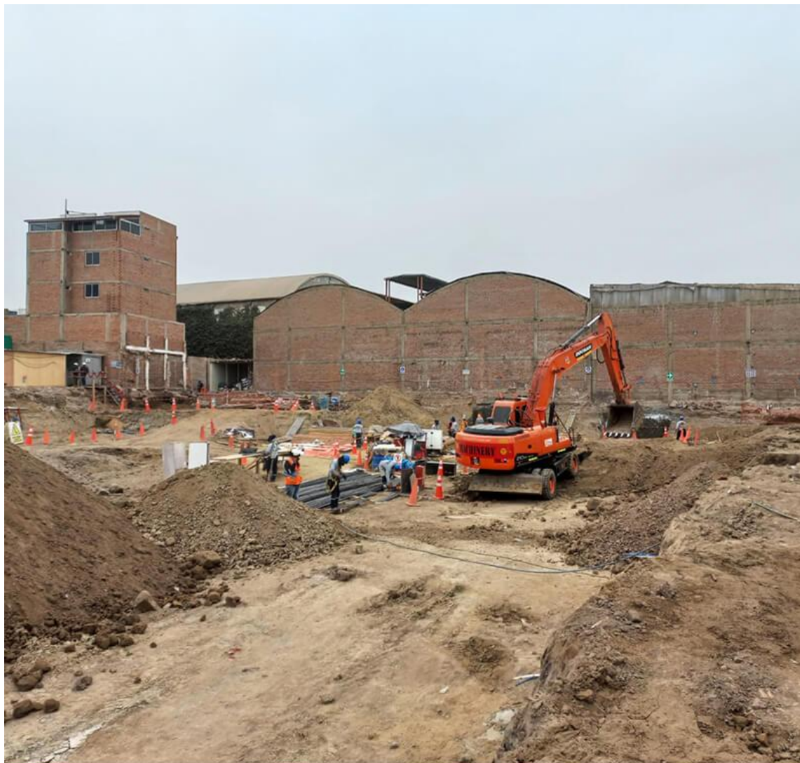
AVANCE DE OBRA - AGOSTO 2024
