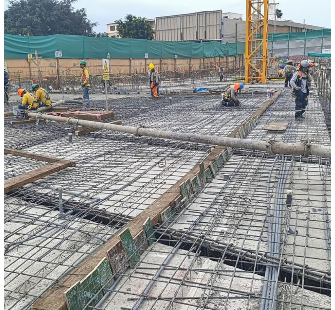
AVANCE DE OBRA - NOVIEMBRE 2024
