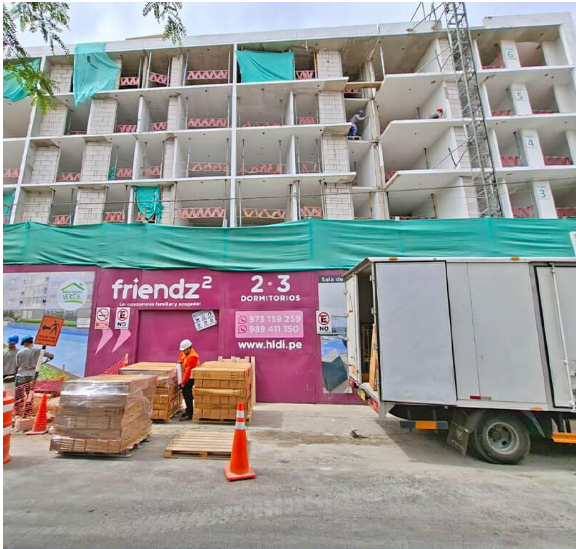
AVANCE DE OBRA - MAYO 2025
