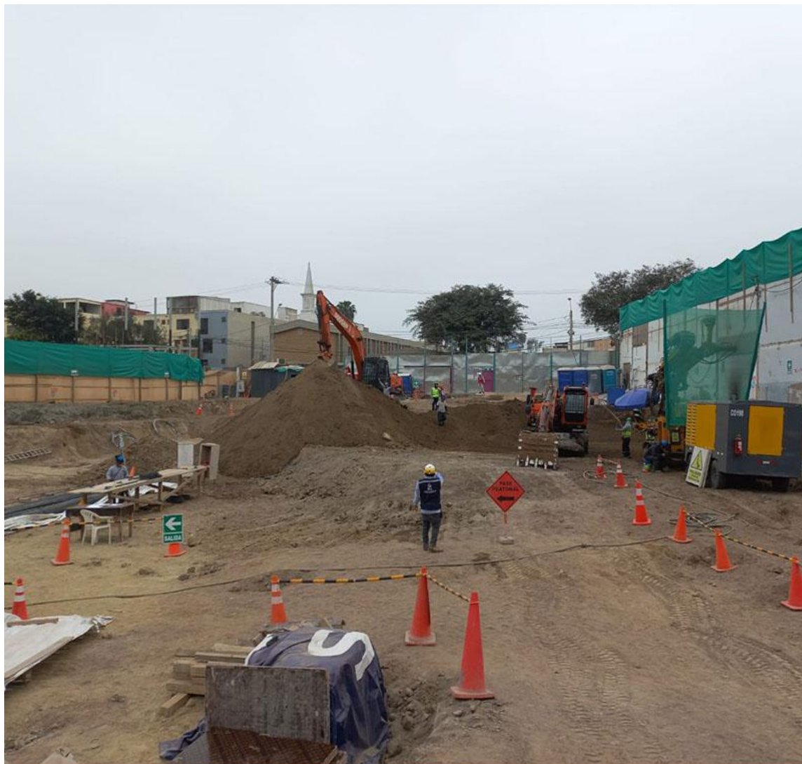
AVANCE DE OBRA - AGOSTO 2024
