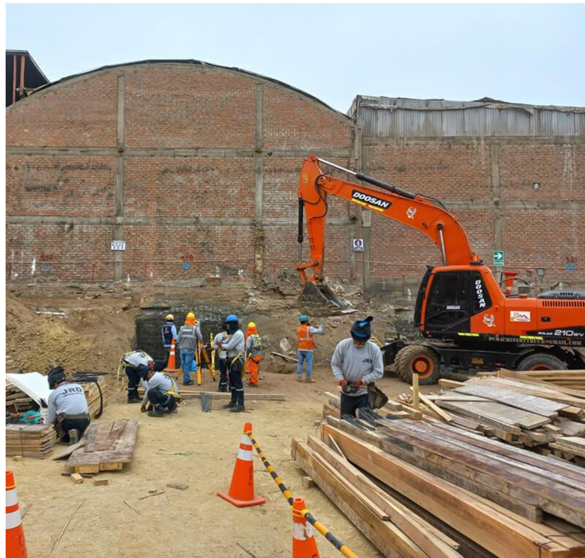
AVANCE DE OBRA - AGOSTO 2024
