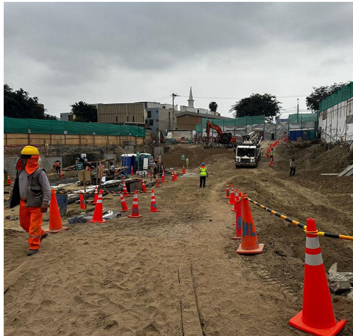
AVANCE DE OBRA - AGOSTO 2024
