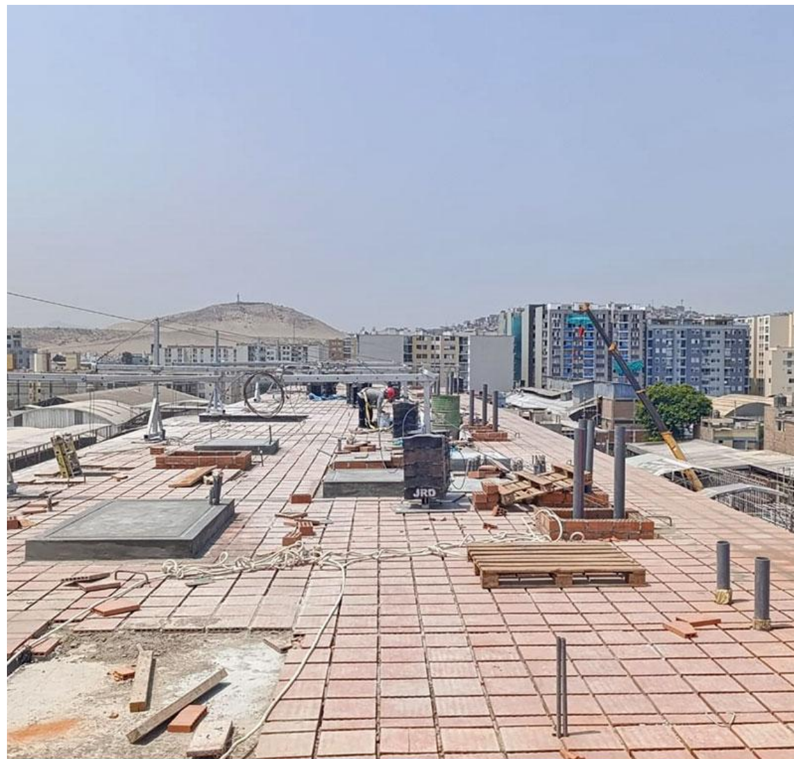
AVANCE DE OBRA - ABRIL 2025
