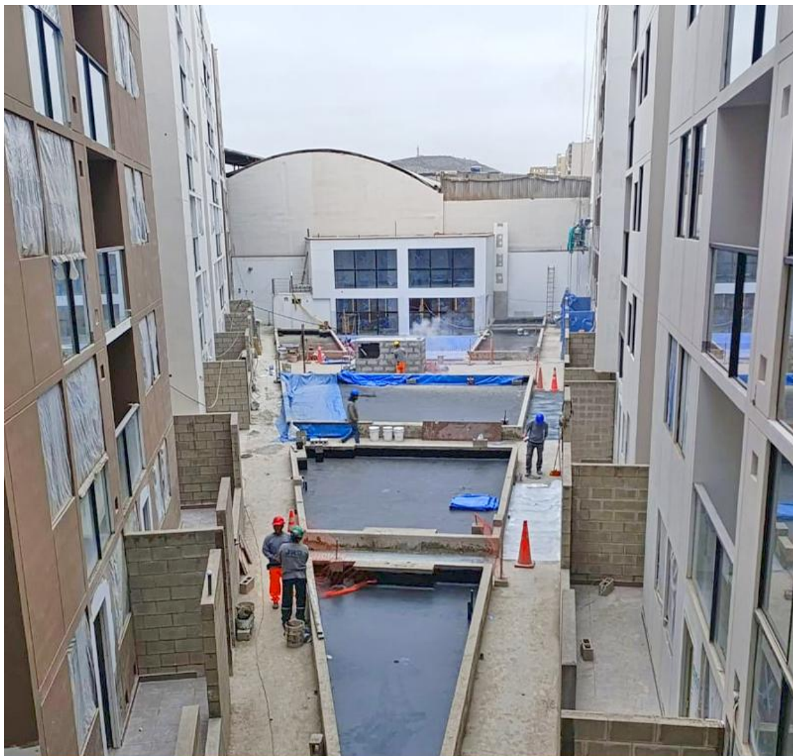
AVANCE DE OBRA - JULIO 2025
