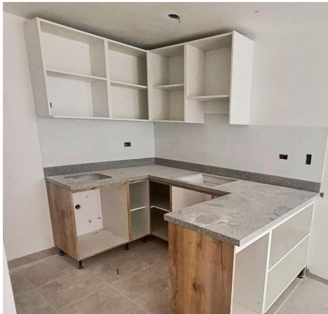
AVANCE DE OBRA - ABRIL 2025
