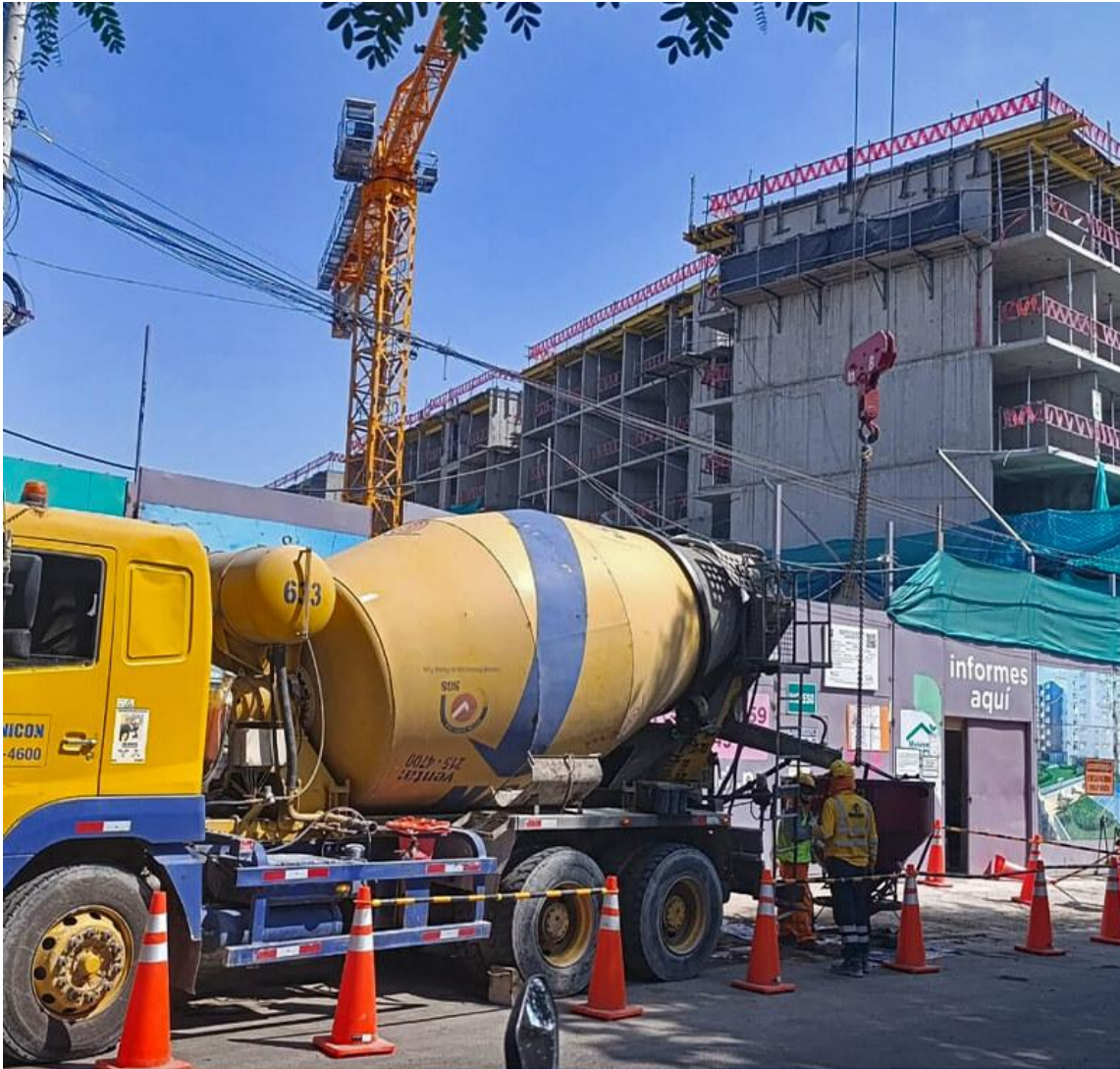
AVANCE DE OBRA - ENERO 2025
