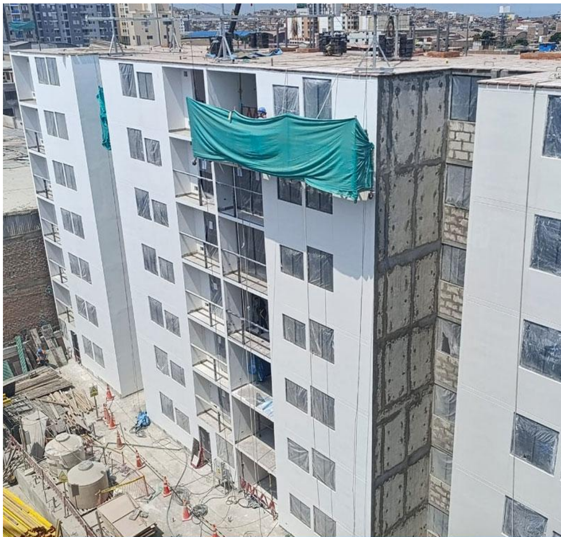
AVANCE DE OBRA - ABRIL 2025
