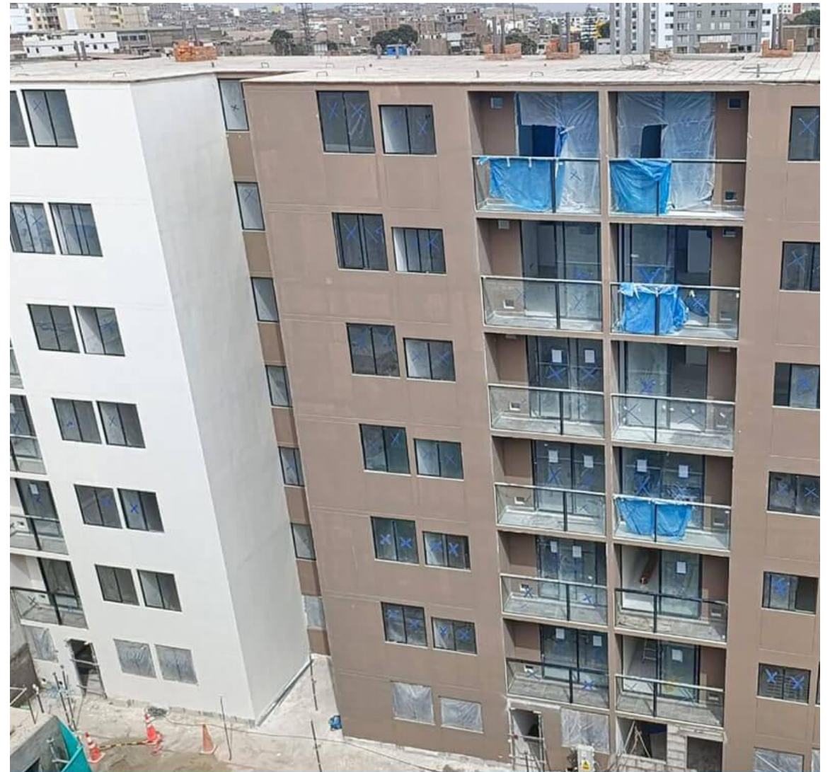
AVANCE DE OBRA - MAYO 2025
