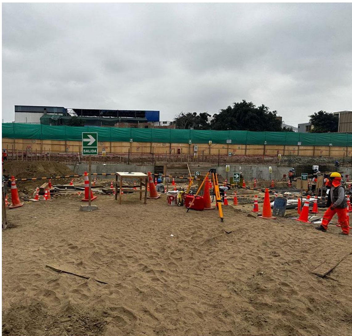
AVANCE DE OBRA - AGOSTO 2024
