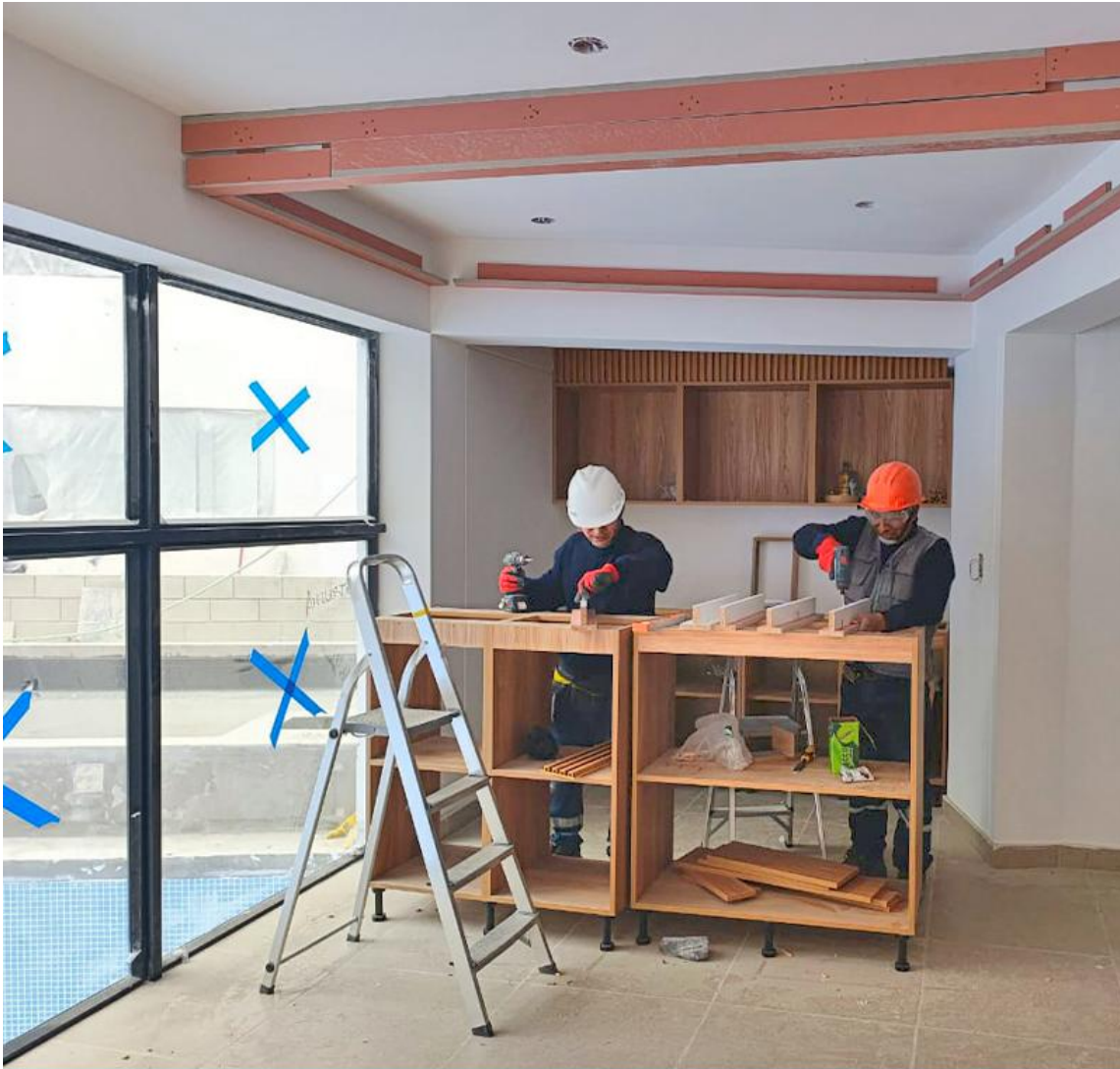
AVANCE DE OBRA - JULIO 2025
