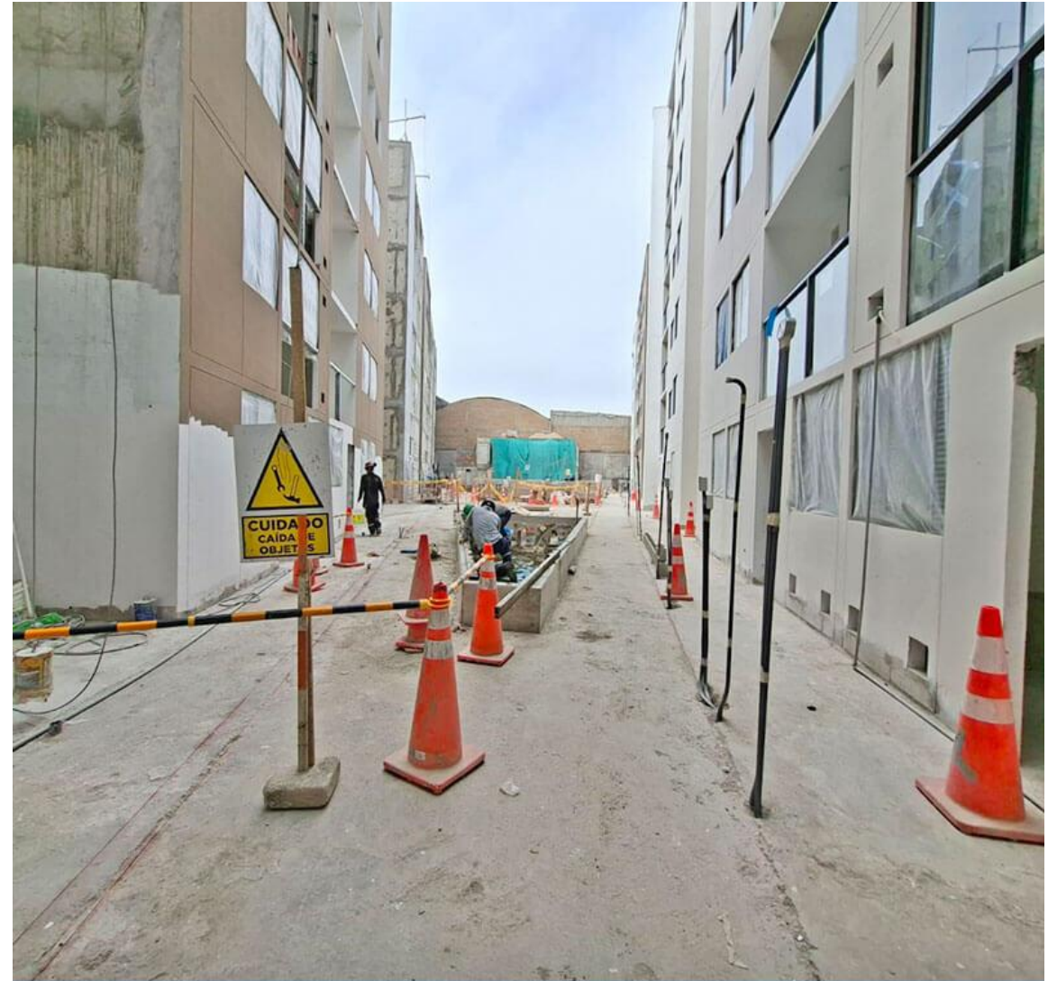
AVANCE DE OBRA - MAYO 2025
