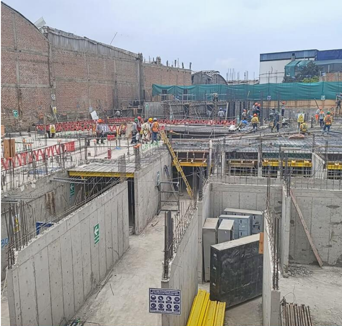
AVANCE DE OBRA - NOVIEMBRE 2024
