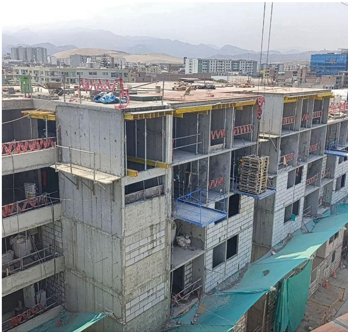
AVANCE DE OBRA - ABRIL 2025
