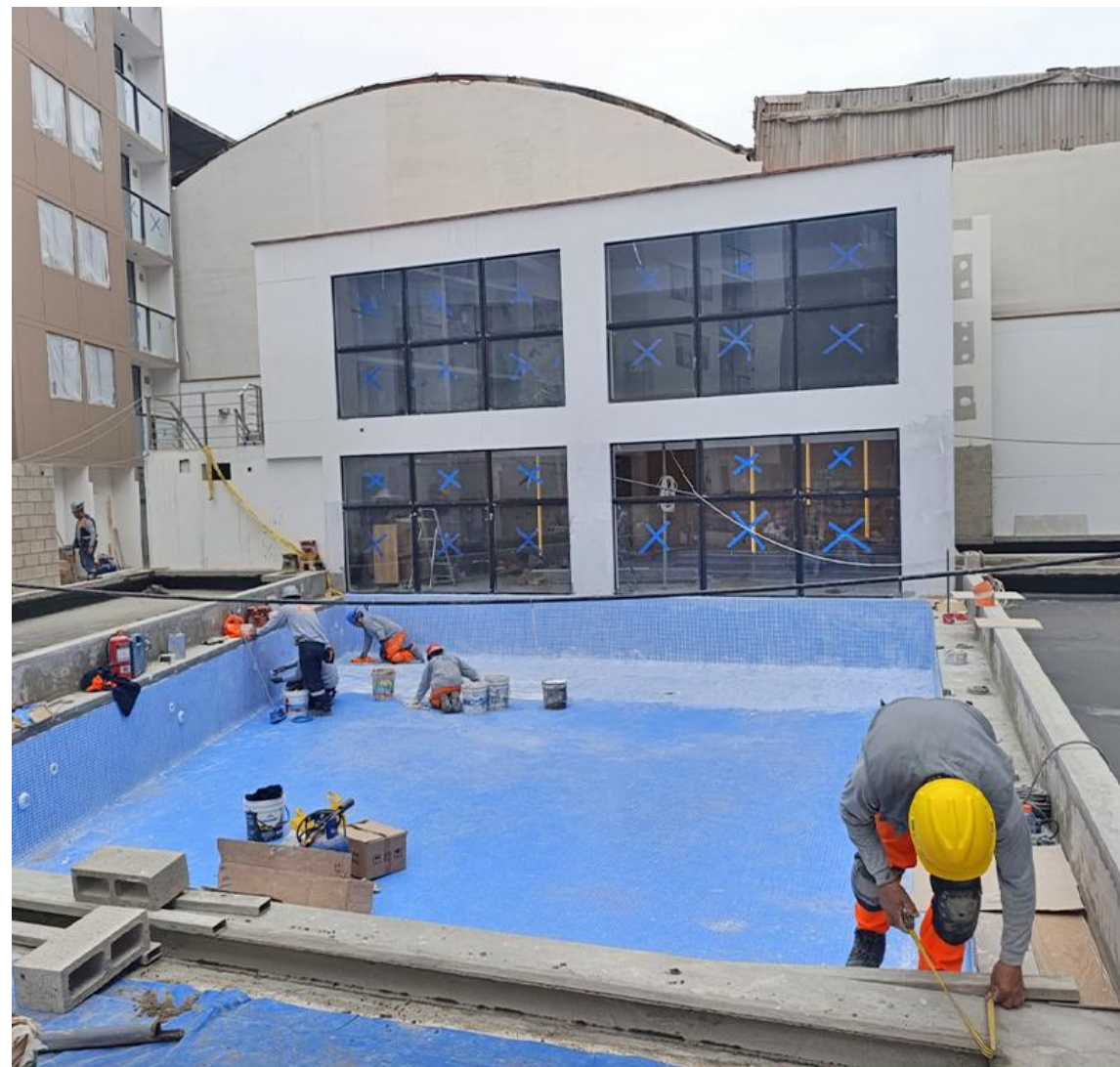
AVANCE DE OBRA - JULIO 2025
