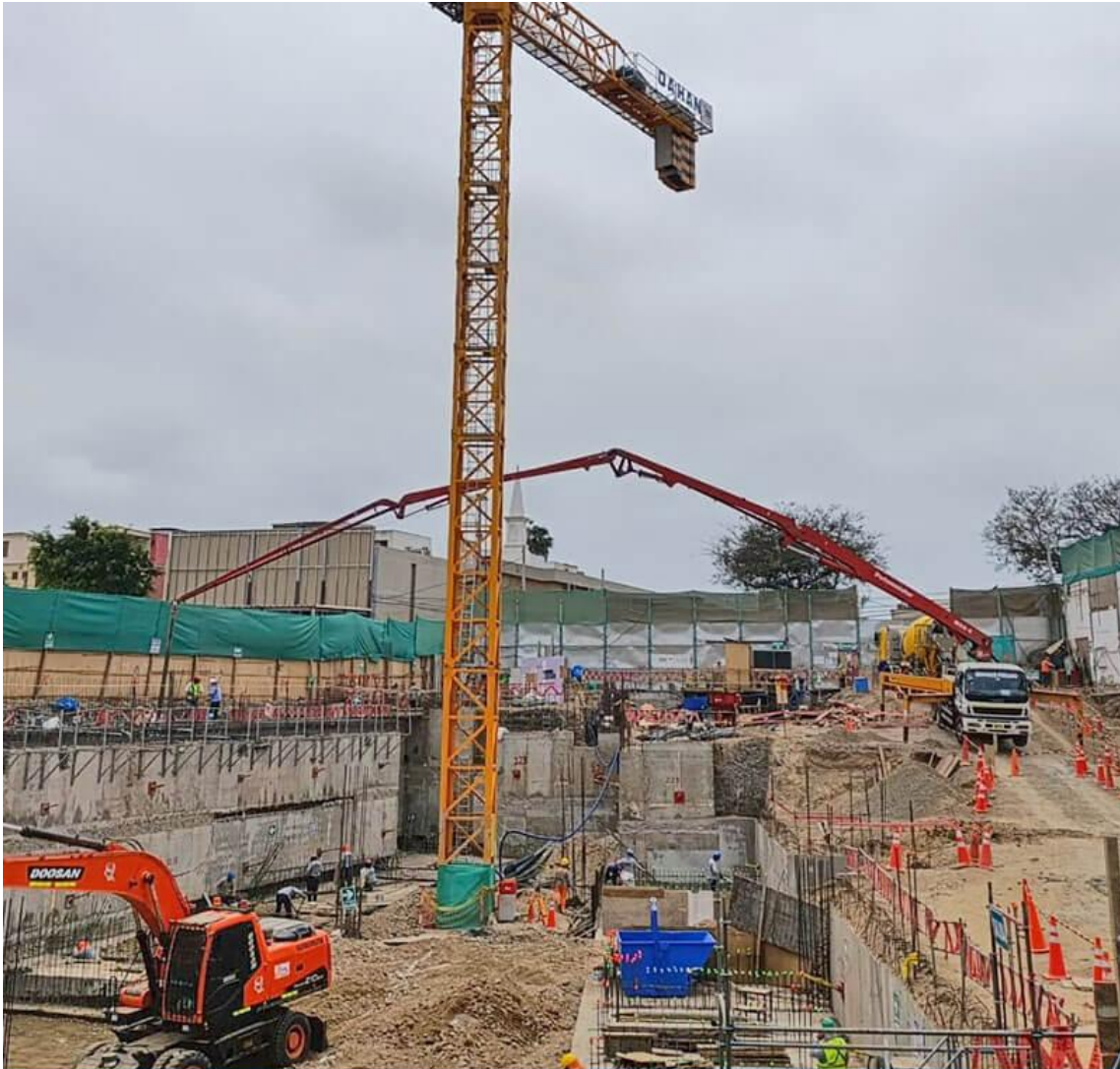
AVANCE DE OBRA - OCTUBRE 2024
