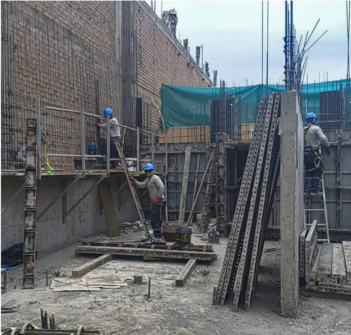
AVANCE DE OBRA - NOVIEMBRE 2024
