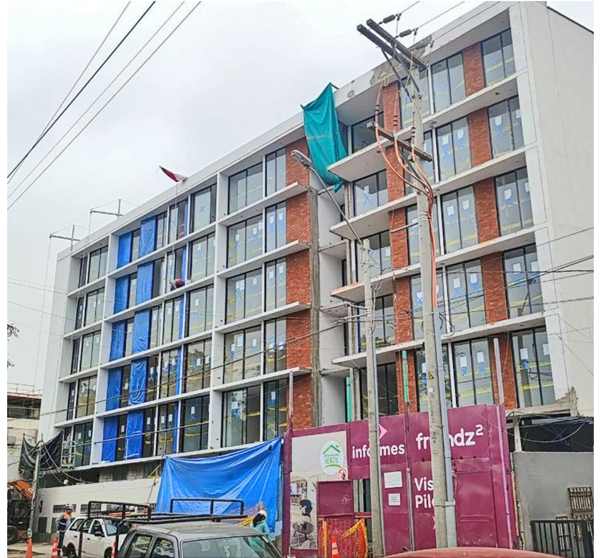
AVANCE DE OBRA - JULIO 2025
