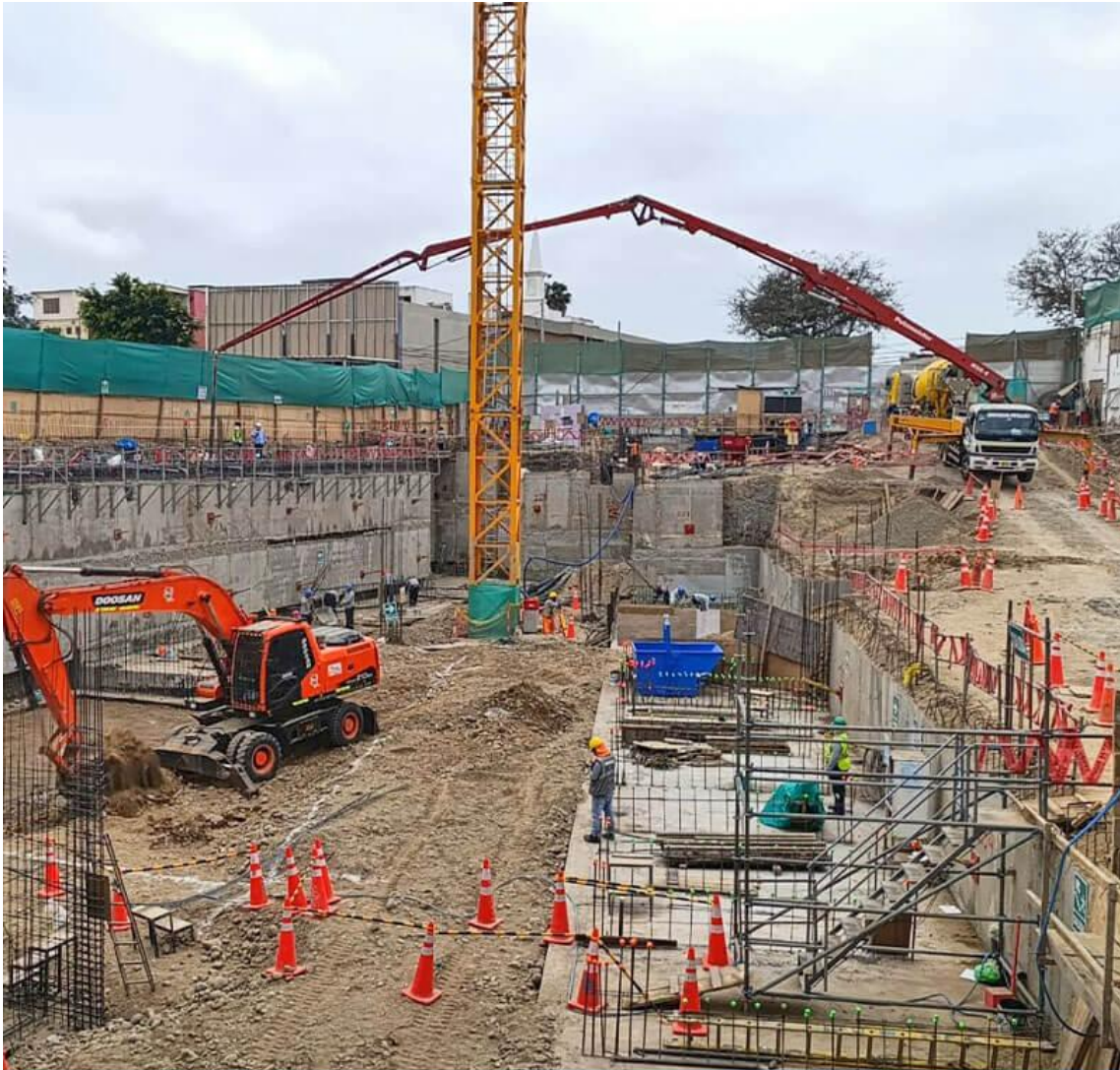
AVANCE DE OBRA - OCTUBRE 2024
