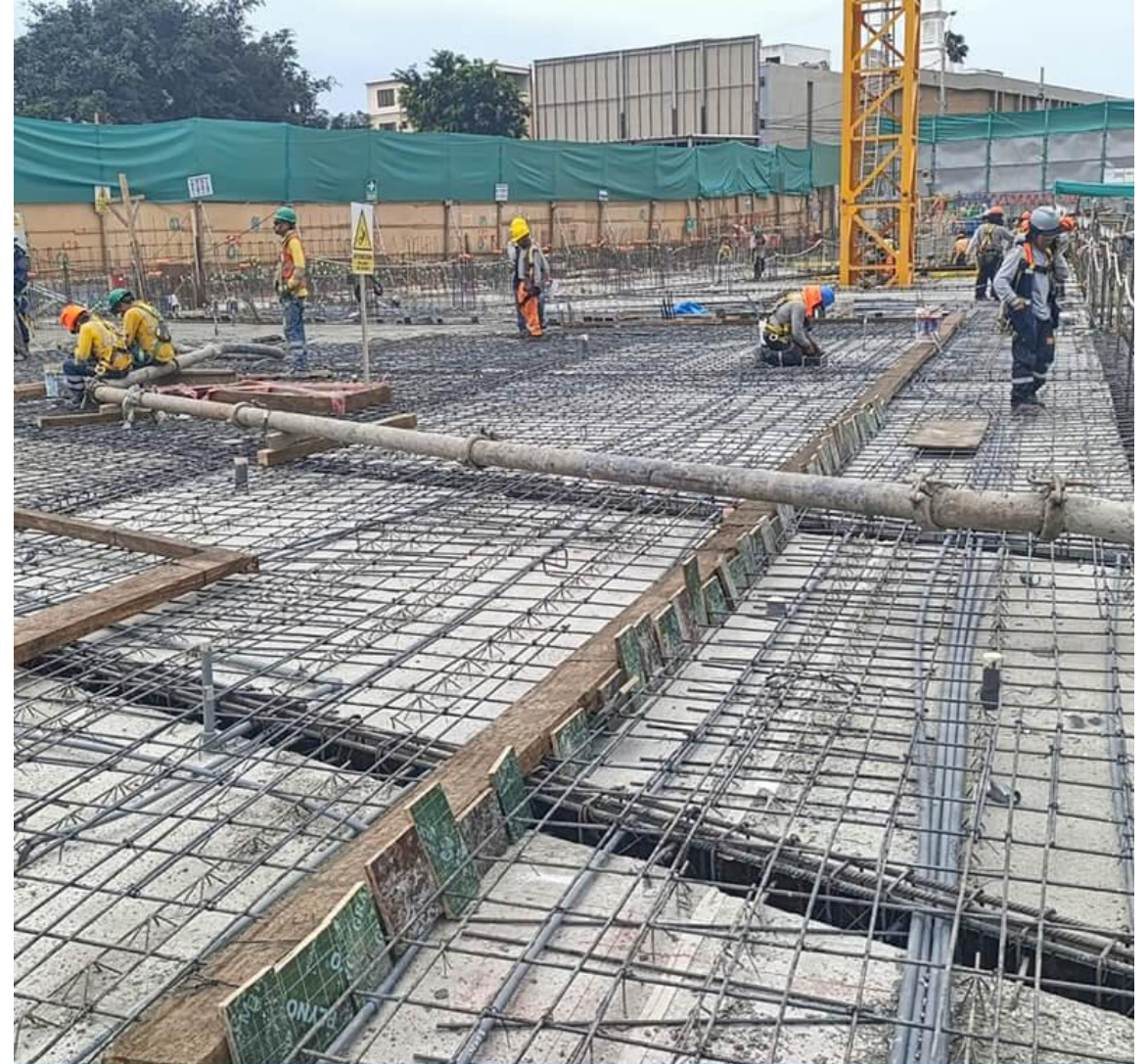
AVANCE DE OBRA - NOVIEMBRE 2024
