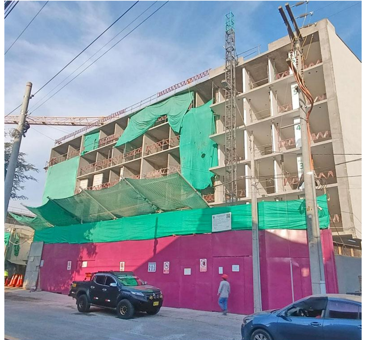
AVANCE DE OBRA - ABRIL 2025
