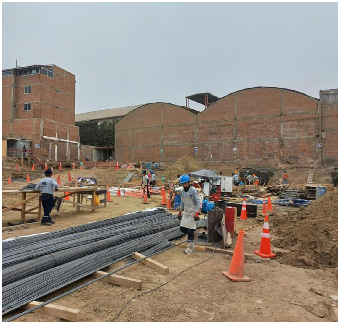
AVANCE DE OBRA - AGOSTO 2024
