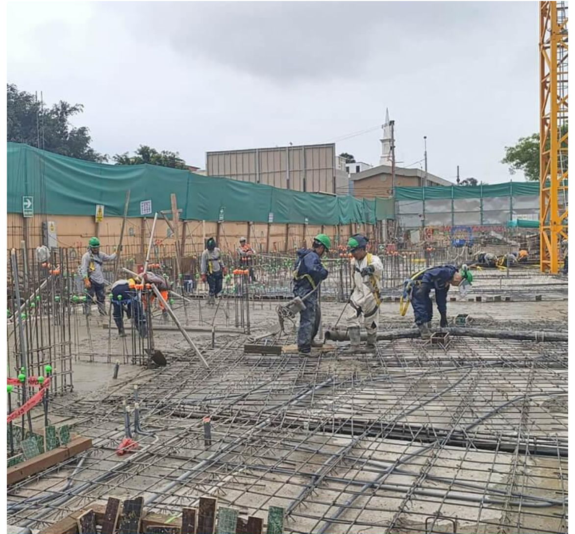
AVANCE DE OBRA - NOVIEMBRE 2024
