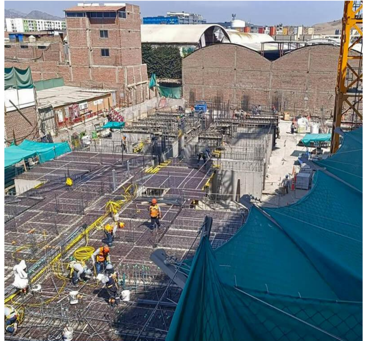
AVANCE DE OBRA - ENERO 2025
