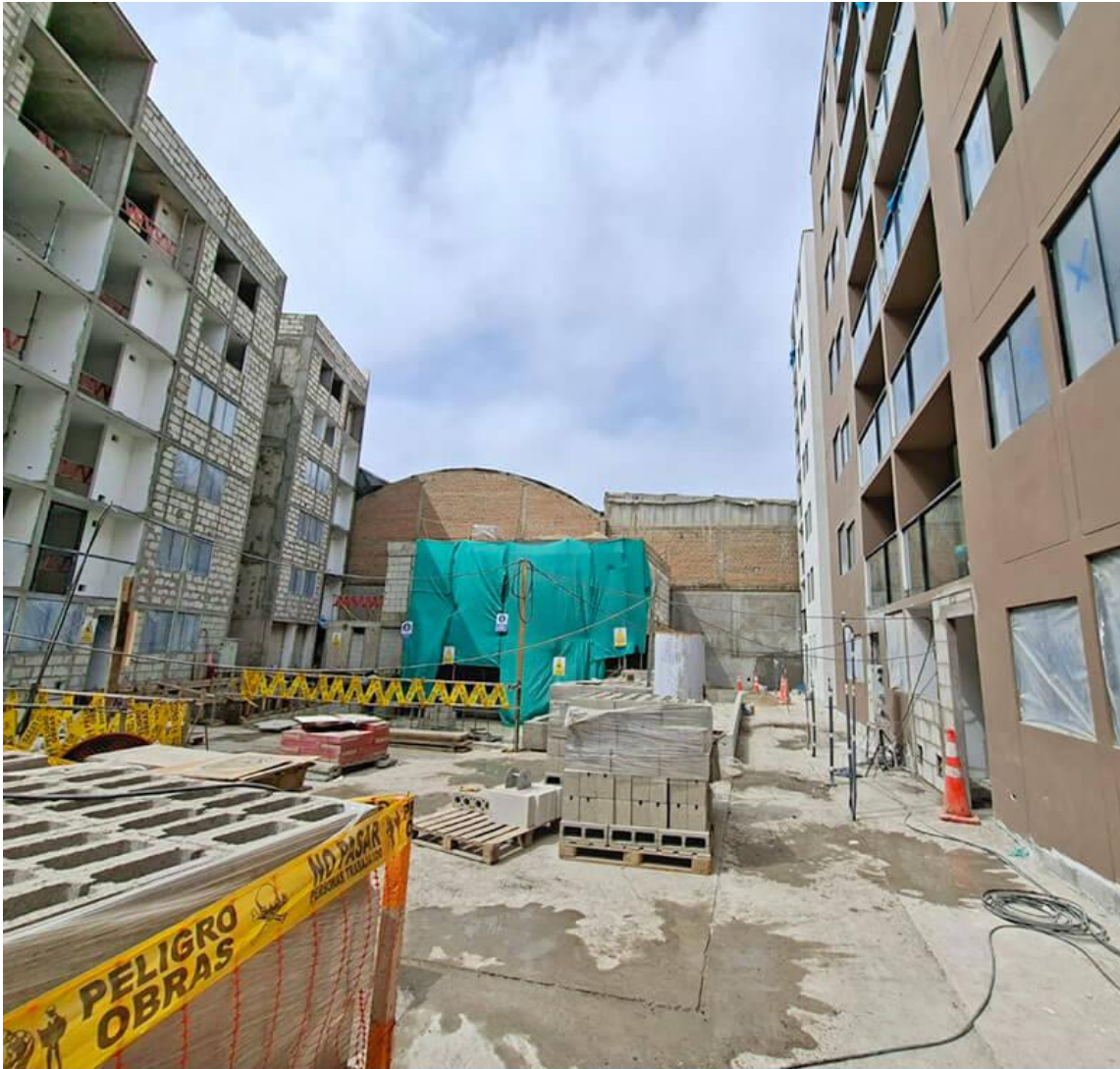
AVANCE DE OBRA - MAYO 2025
