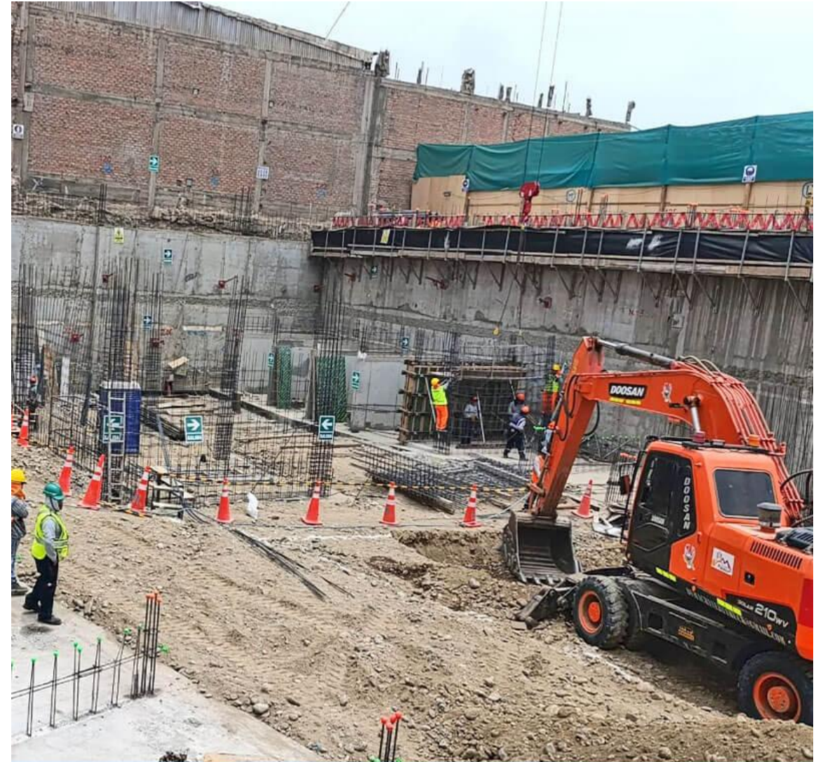
AVANCE DE OBRA - OCTUBRE 2024
