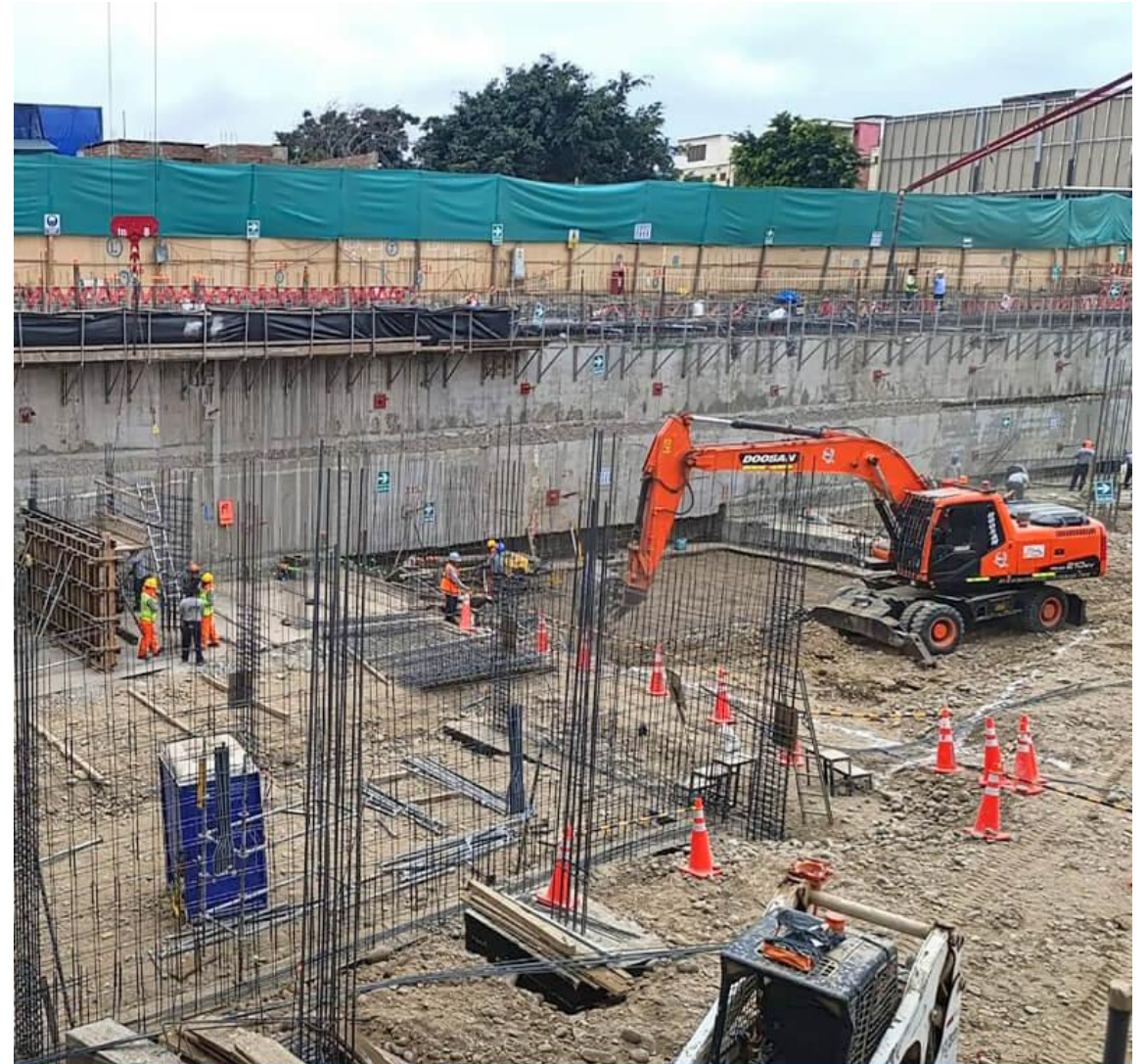
AVANCE DE OBRA - OCTUBRE 2024
