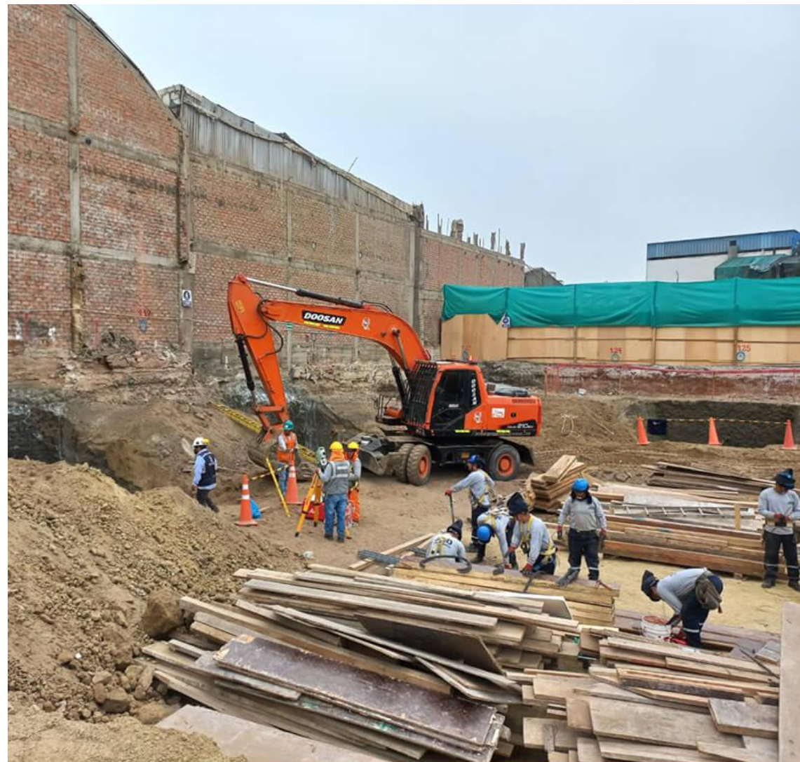
AVANCE DE OBRA - AGOSTO 2024
