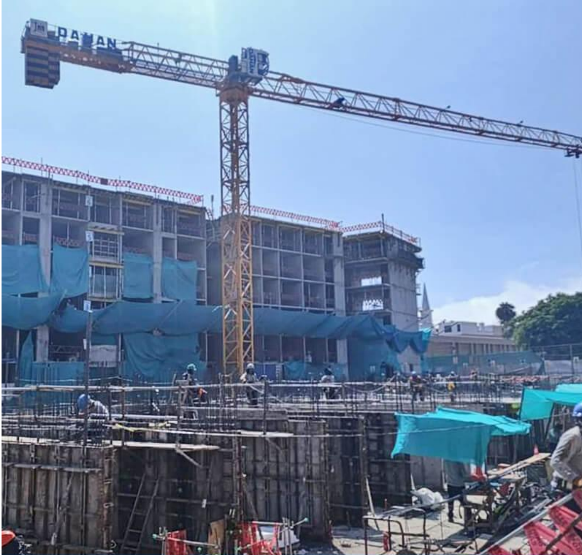
AVANCE DE OBRA - ENERO 2025
