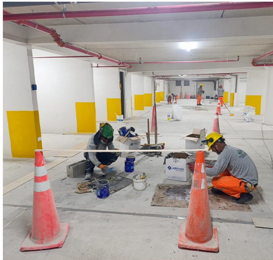
AVANCE DE OBRA - JULIO 2025
