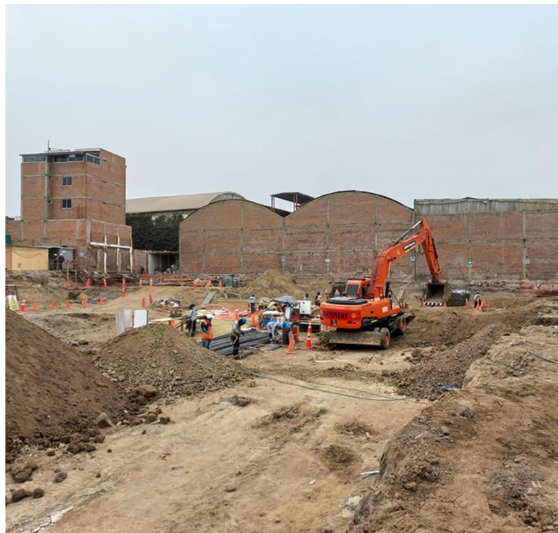
AVANCE DE OBRA - AGOSTO 2024
