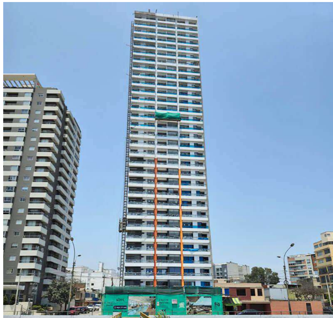
AVANCE DE OBRA - OCTUBRE 2024
