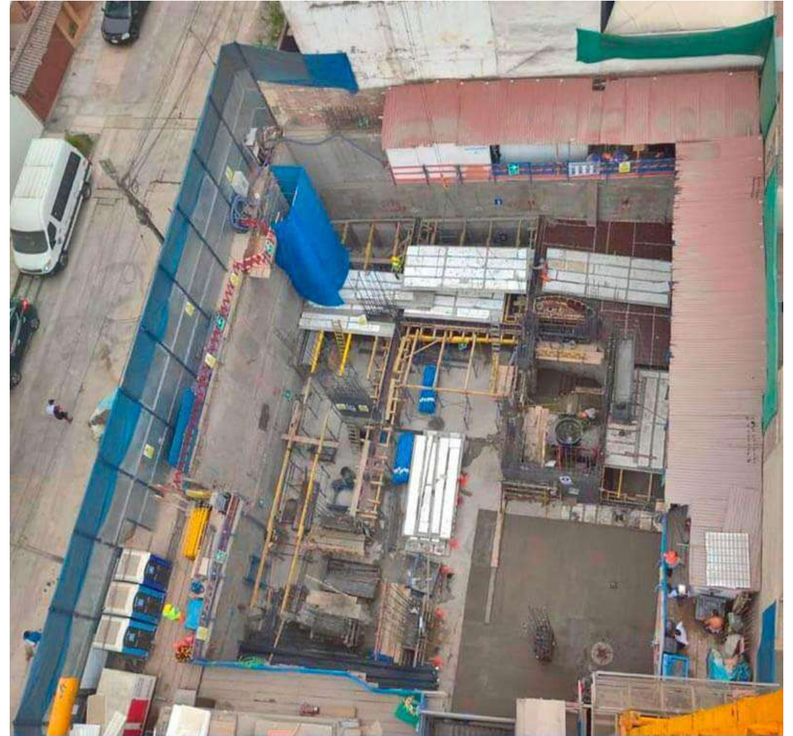
AVANCE DE OBRA - DICIEMBRE 2023
