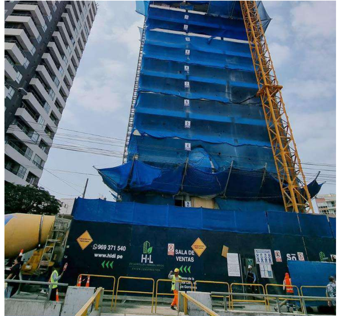
AVANCE DE OBRA - ABRIL 2024
