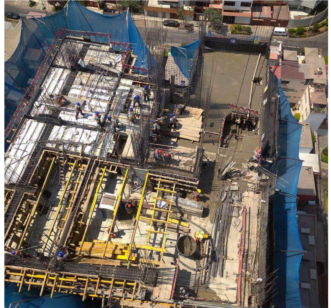
AVANCE DE OBRA - ABRIL 2024
