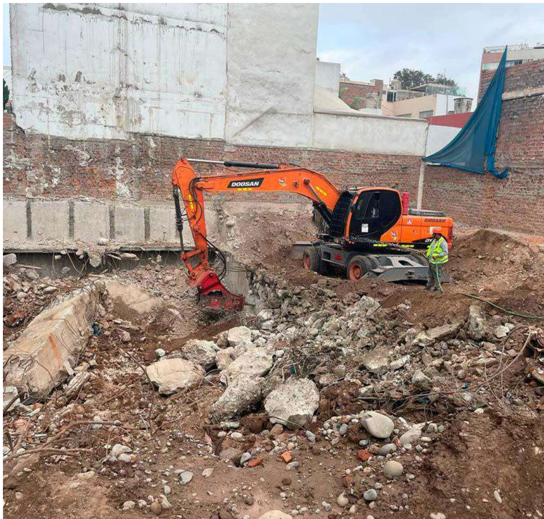
AVANCE DE OBRA - MAYO 2023
