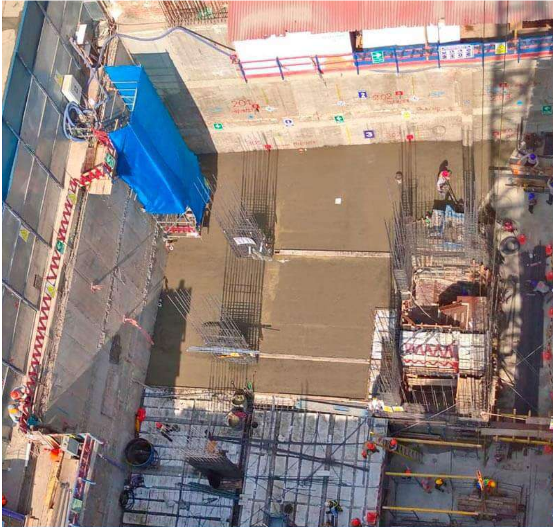
AVANCE DE OBRA - DICIEMBRE 2023
