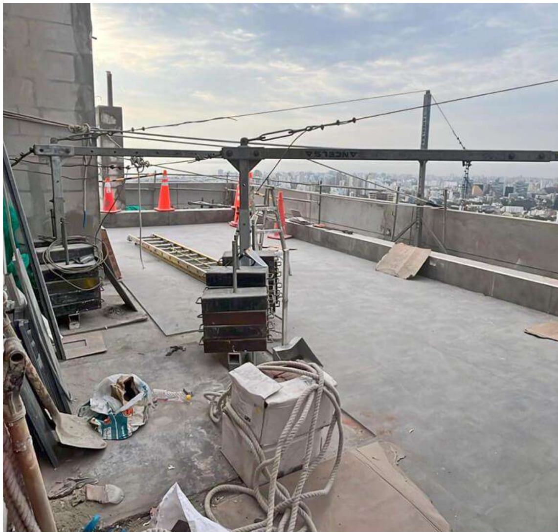
AVANCE DE OBRA - DICIEMBRE 2024
