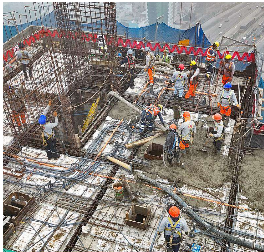
AVANCE DE OBRA - JUNIO 2024
