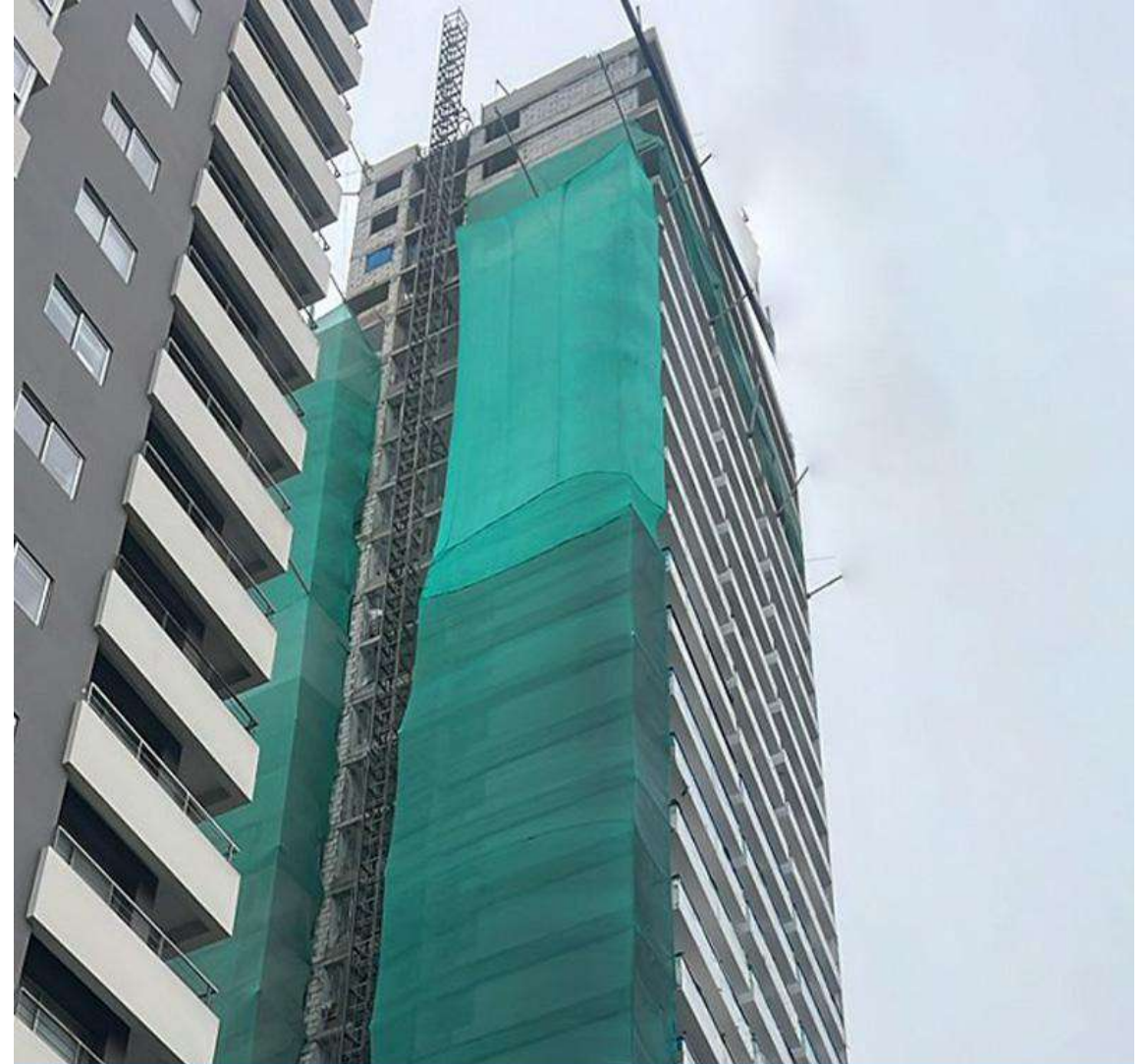
AVANCE DE OBRA - AGOSTO 2024
