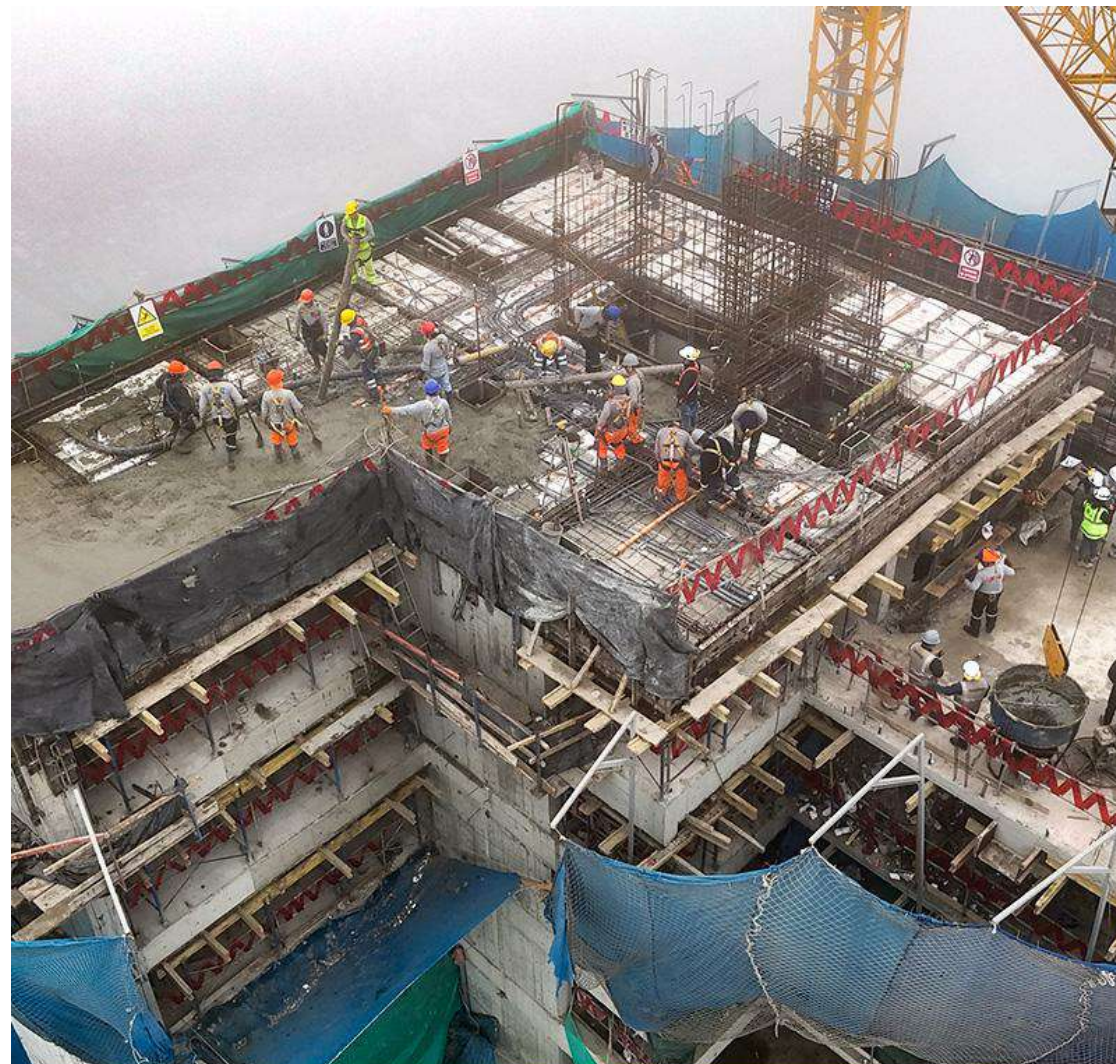
AVANCE DE OBRA - JUNIO 2024
