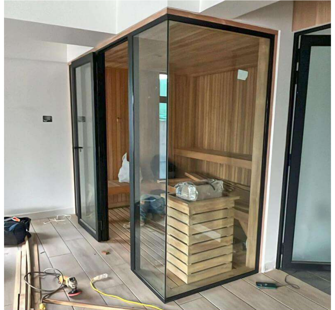
AVANCE DE OBRA - DICIEMBRE 2024
