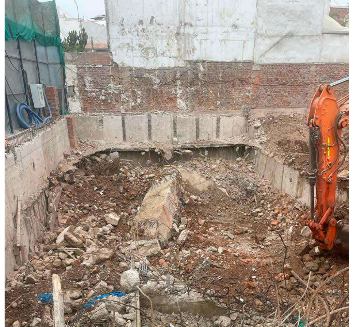
AVANCE DE OBRA - MAYO 2023
