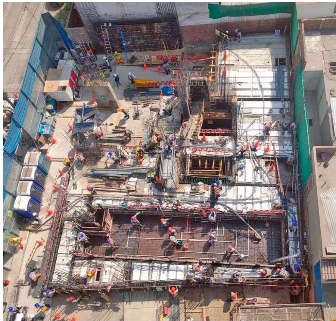
AVANCE DE OBRA - ENERO 2024
