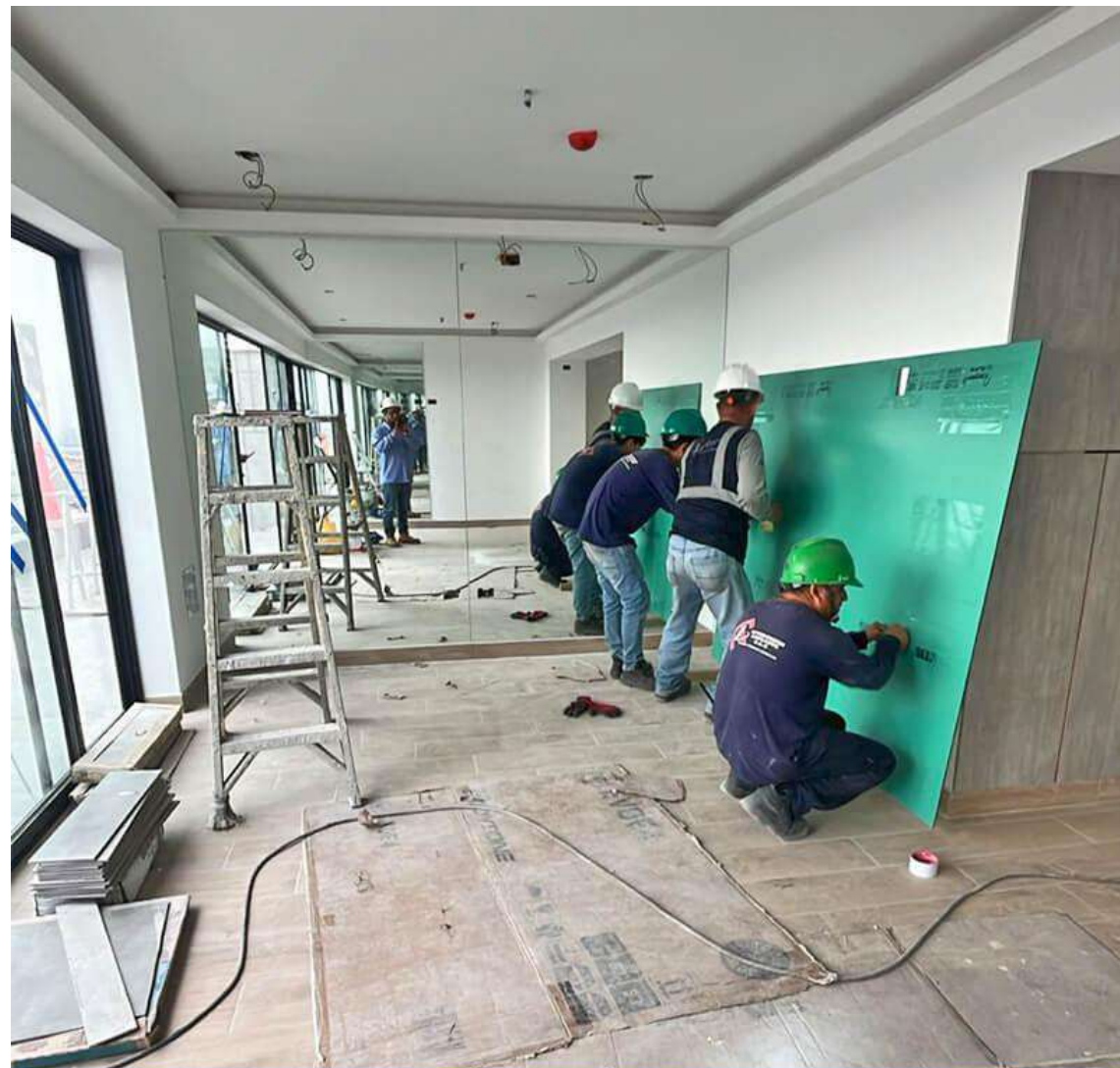
AVANCE DE OBRA - DICIEMBRE 2024
