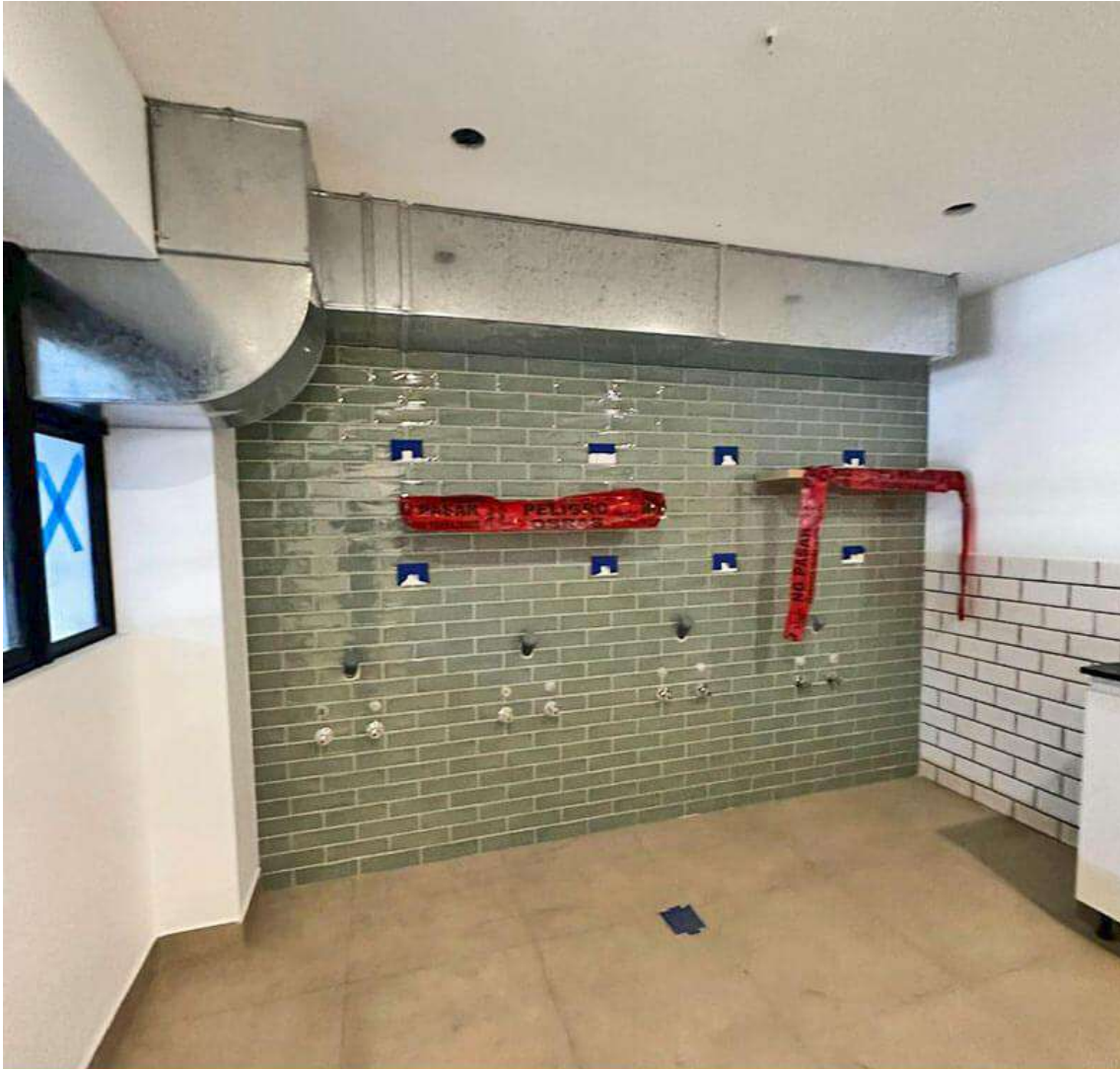
AVANCE DE OBRA - DICIEMBRE 2024
