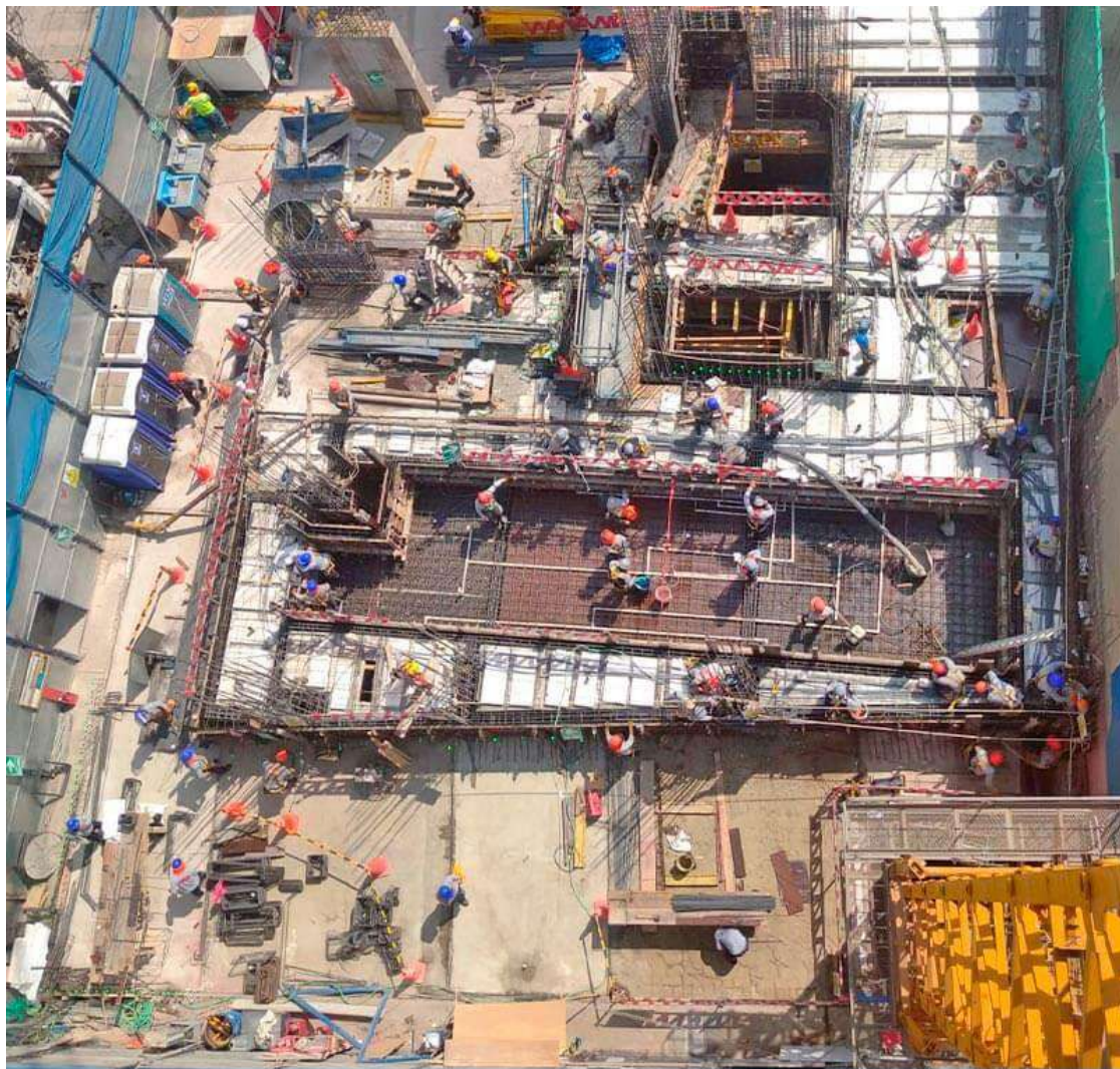
AVANCE DE OBRA - ENERO 2024
