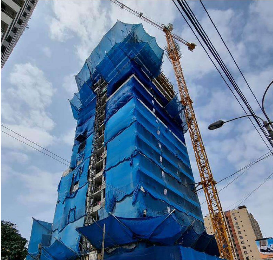
AVANCE DE OBRA - ABRIL 2024
