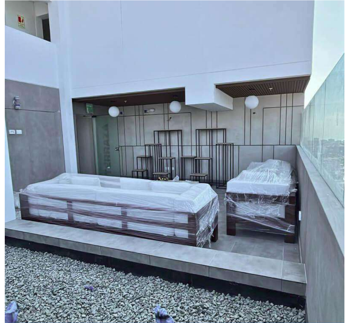
AVANCE DE OBRA - ENERO 2025
