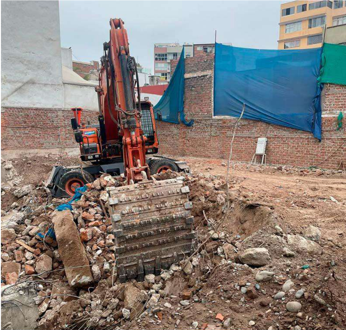
AVANCE DE OBRA - MAYO 2023
