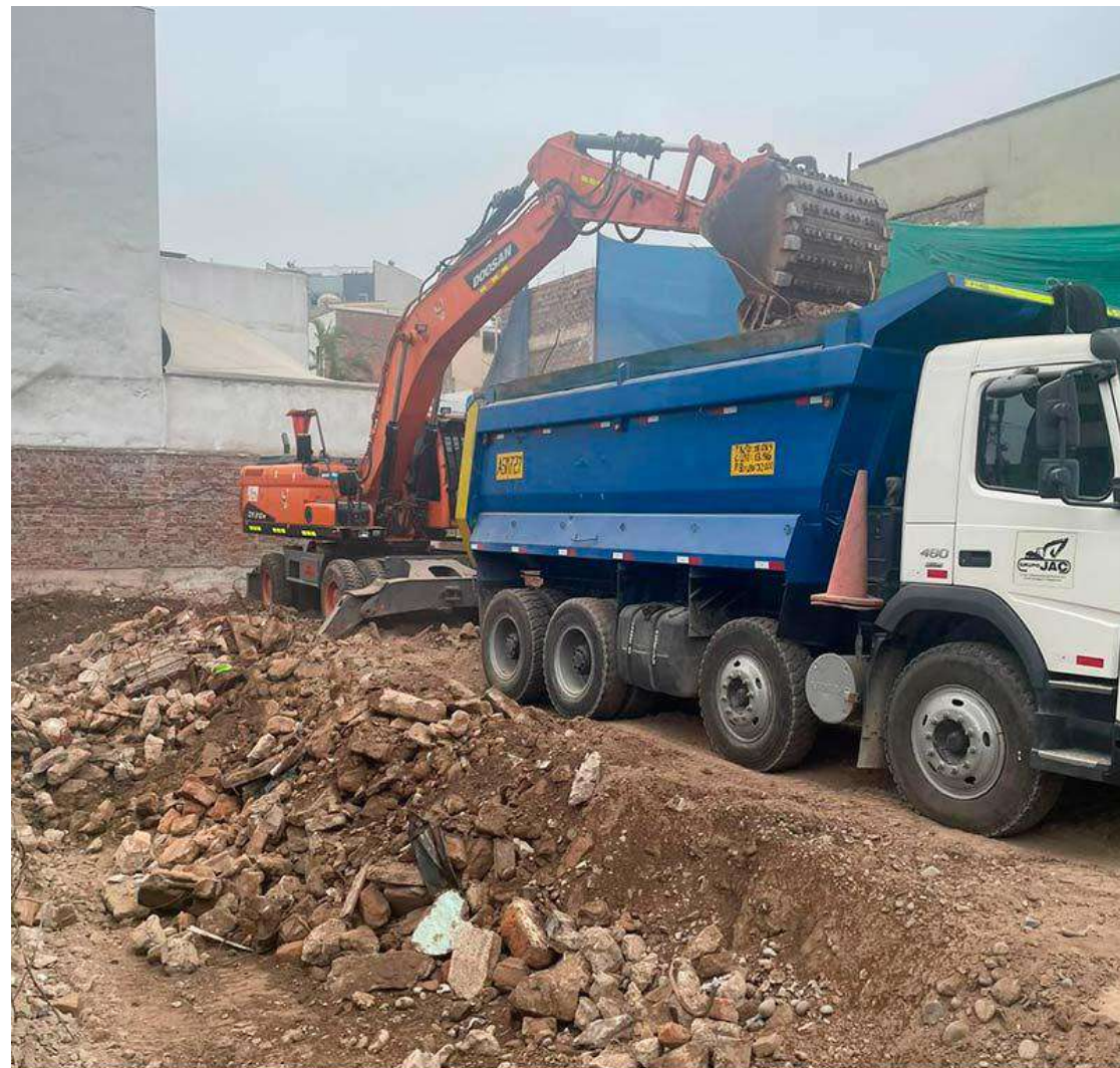
AVANCE DE OBRA - MAYO 2023
