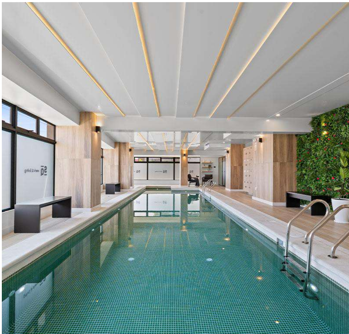
AVANCE DE OBRA - MARZO 2025
