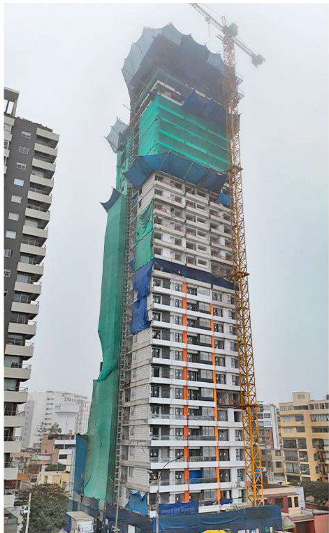
AVANCE DE OBRA - JUNIO 2024
