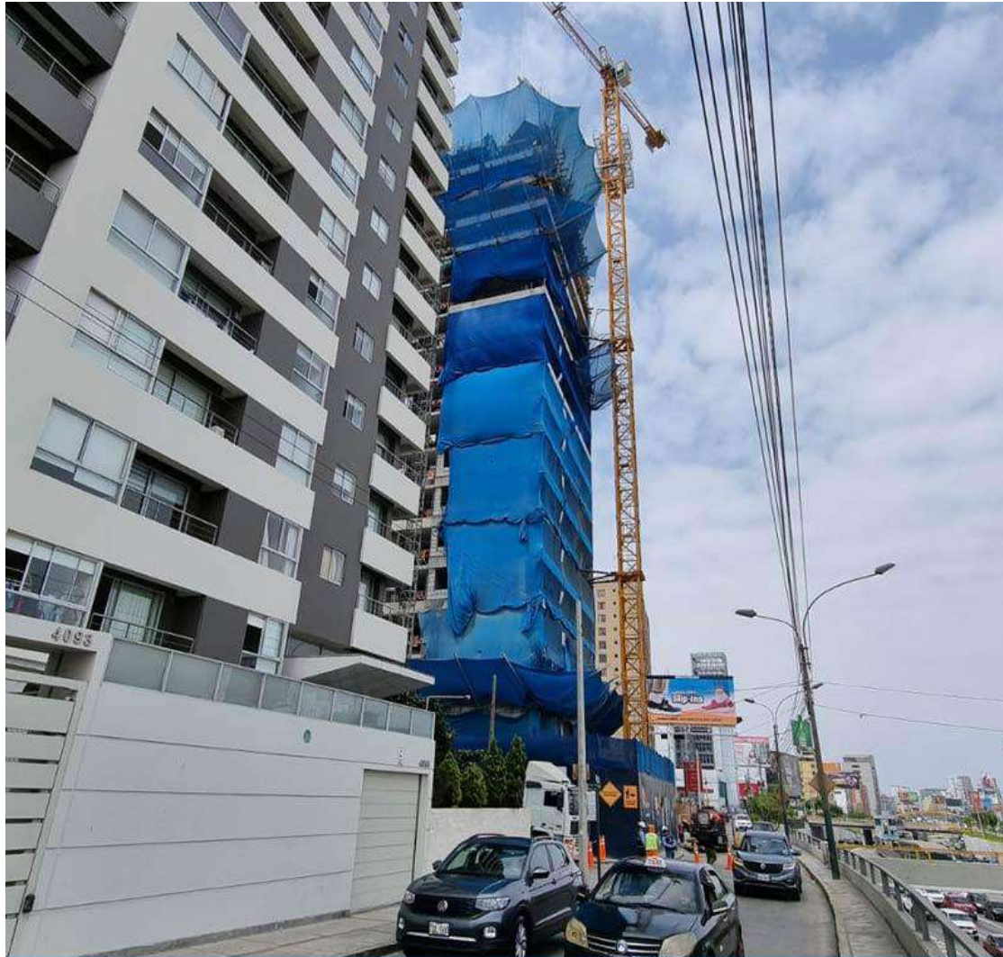
AVANCE DE OBRA - ABRIL 2024
