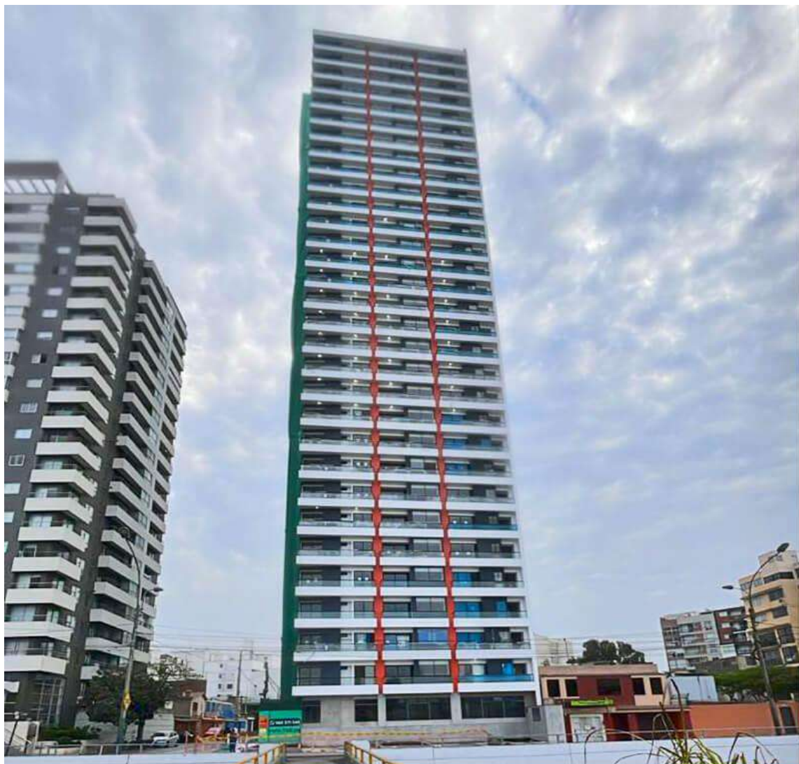
AVANCE DE OBRA - DICIEMBRE 2024
