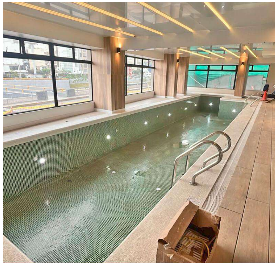
AVANCE DE OBRA - DICIEMBRE 2024
