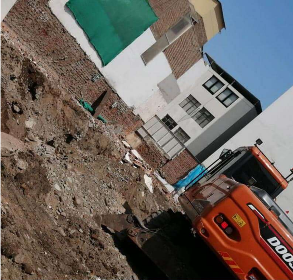
AVANCE DE OBRA - MAYO 2024
