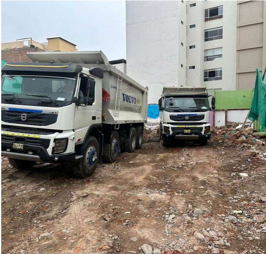
AVANCE DE OBRA - MAYO 2024
