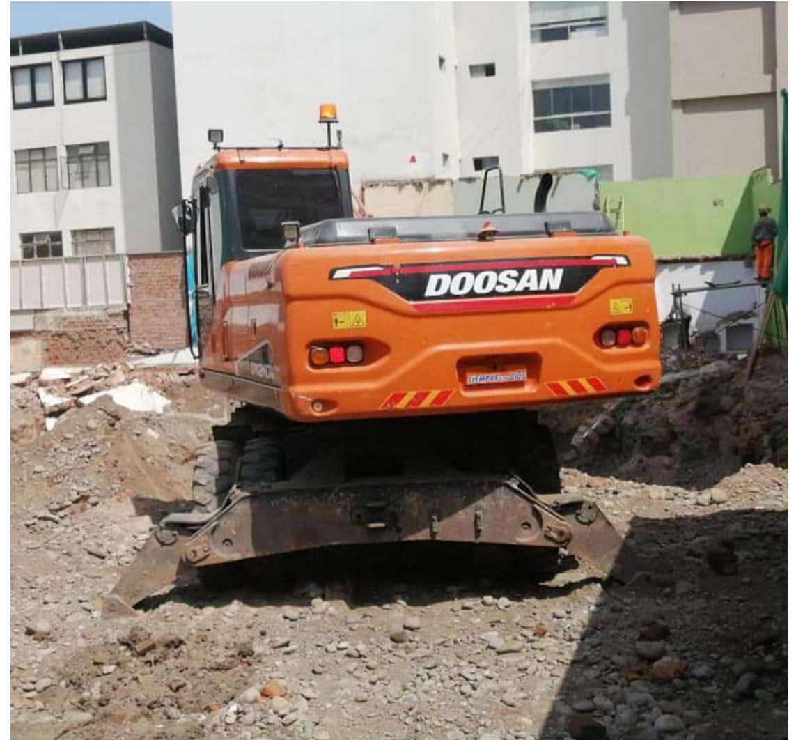
AVANCE DE OBRA - MAYO 2024
