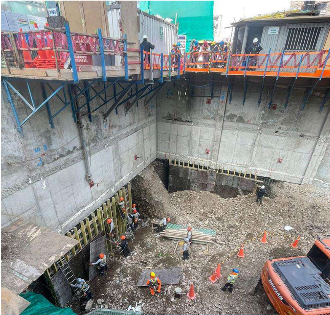
AVANCE DE OBRA - JULIO 2024
