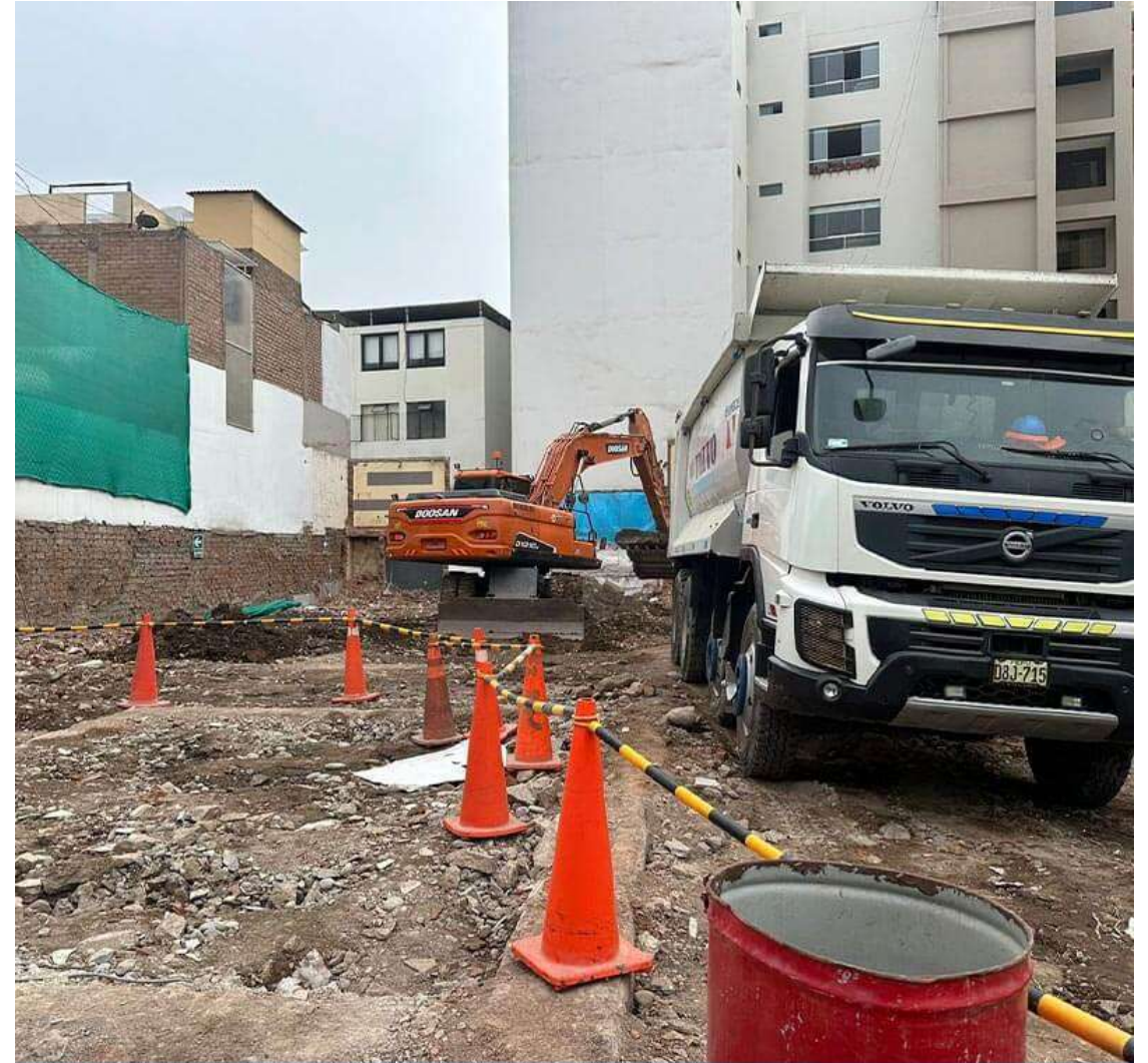
AVANCE DE OBRA - MAYO 2024
