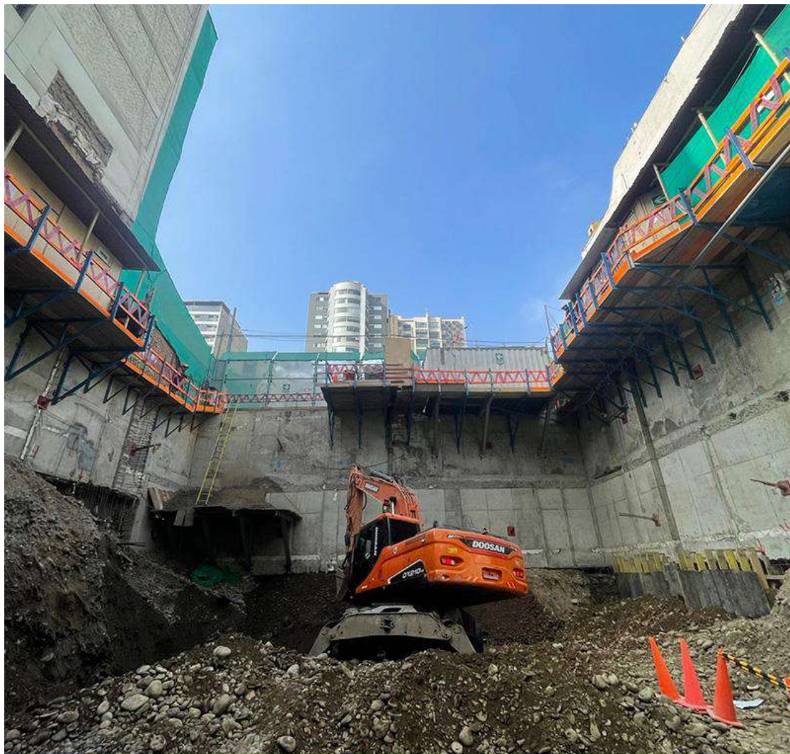
AVANCE DE OBRA - JULIO 2024
